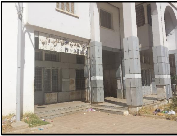
Figure 33 les locaux commerciaux laissés à l'abandon et deviennent des espaces sales Source:l'auteur,2016
