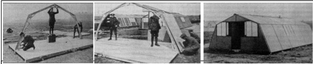
Fig. (1-15): Processus d'érection d'une structure militaire en charpente en bois, 1918, (Kronenburg, 2000, p. 58)
