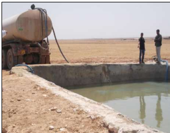
Figure 228 : Réalisation d'un réservoir pour les besoins en eau d'arrosage. Source photo : TRODI F., 2013
