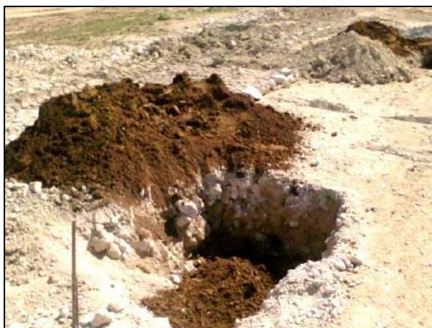
Figure 219 : Comblement avec de la terre végétale. Photo : TRODI F., 2014.
