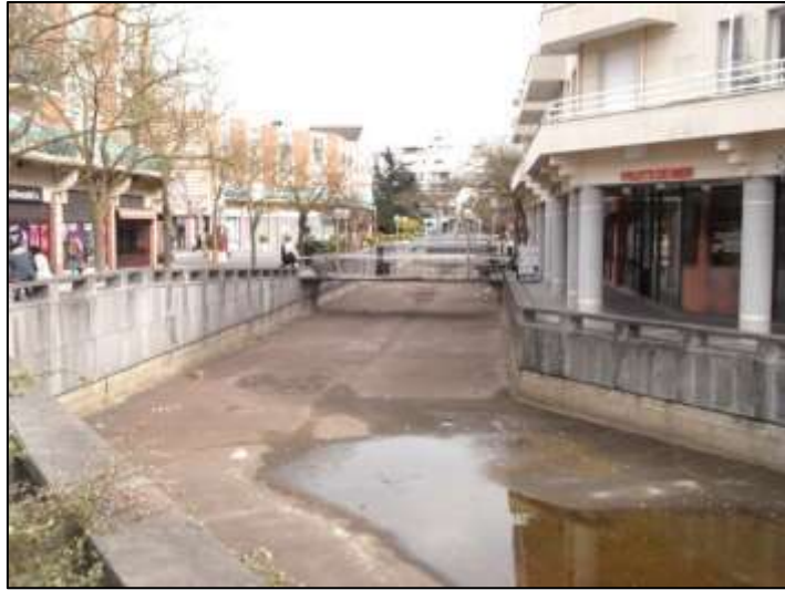
Figure 276 : Le canal d'eau de Saint-Quentin-en-Yvelines à sec. Source photo : TRODI F., 2014.
