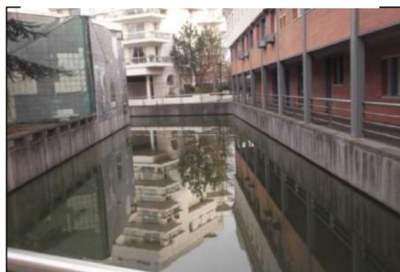
Figure 89 : Une portion du canal du Centre remplie d'eau. Source photo : TRODI F., 2014.
