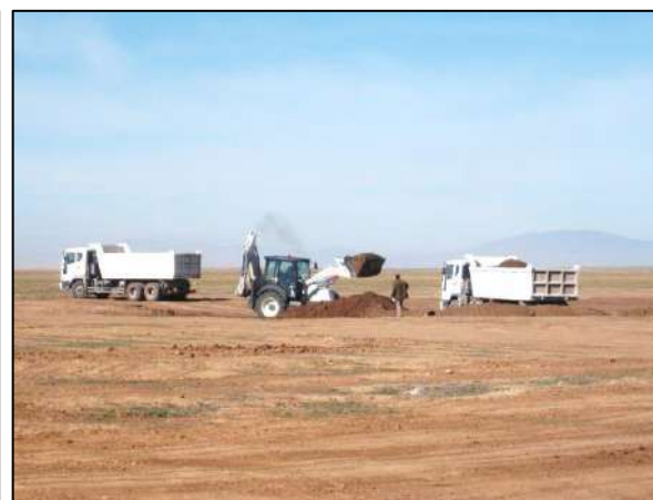
Figure 242 : Acheminement de la terre végétale vers les potées. Source photo : TRODI F., 2014.
