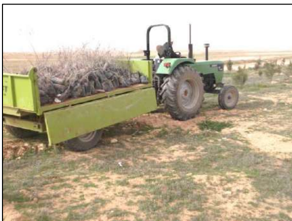
Figure 245 : Déchargement des plants sur le chantier. Source photo : TRODI F., 2014.
