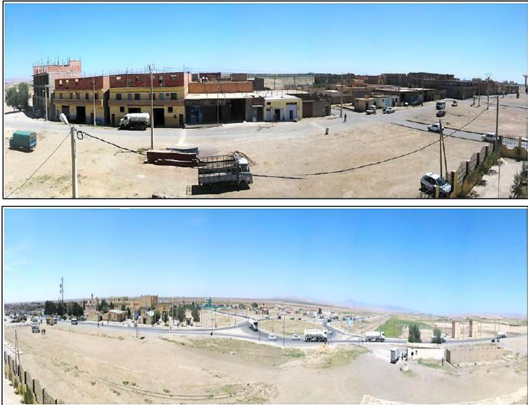
Figure 172: Cadre bâti de l'ancienne commune de Boughzoul après le décret de 2006, source photo : rapport de la mission A
