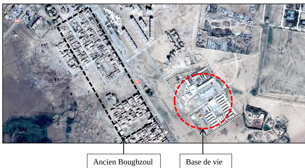
Figure 194 : Base de vie et ancien village de Boughzoul. Source image : Google Maps, le 09/05/2017.
