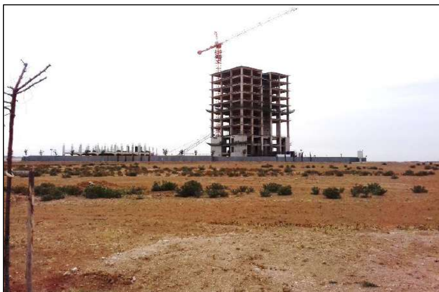
Figure 204 : chantier du siège de la ville nouvelle de Boughzoul. Source photo : TRODI F., 2016
