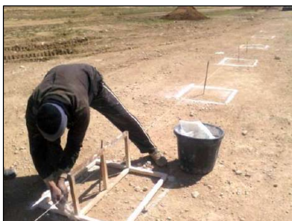
Figure 217 : Traçage des potêts à l'aide de gabarit. Photo : TRODI F., 2014
