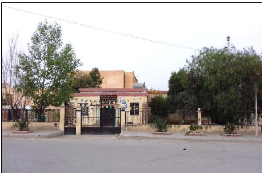
Figure 193 : Les premiers locaux du siège de l'EPIC-Boughzoul. Source photo : TRODI F., 2016.
