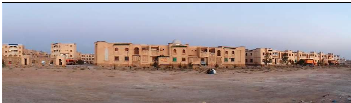
Figure 181 : façade urbaine nord-ouest du nouveau village de Boughzoul. Source photo : TRODI F., 2016.
