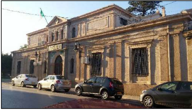
Figure 15 : le siège de l'APC de Cherchell, un bâti colonial monumental à valeur patrimoniale (Auteur)
