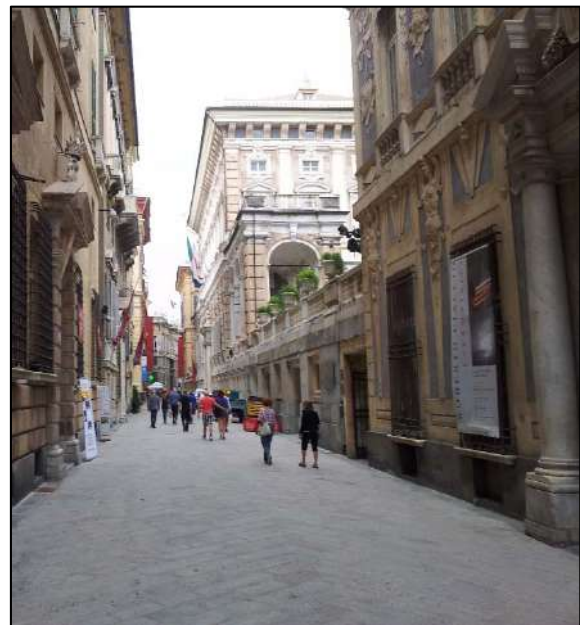
Figure 59 : La rue Garibaldi une fois les travaux de réhabilitation terminés, photo prise en 2013 (Auteur)
