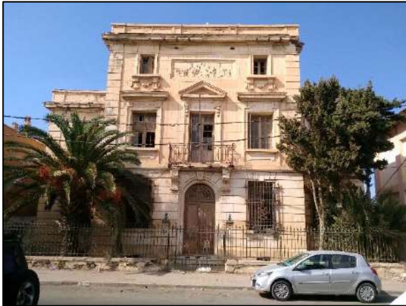
Figure 68 : Façade principale de l'ancien siège de la banque d'Algérie à Cherchell (Auteur)
