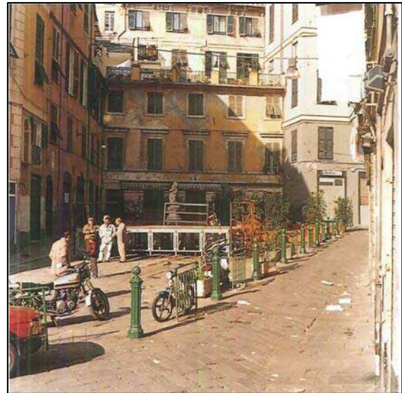
Figure 50 : Une placette génoise avec un bâti en état de dégradation avancée durant les années 90 (IRITECNA, 1992)
