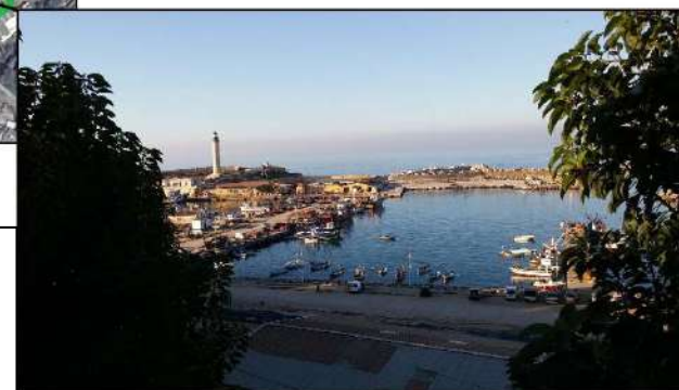
Nouveau bassin du port et hangar de réparation d'embarcations de pêche.
