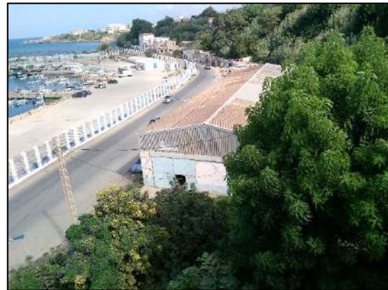
Figure 73 : Hangar de réparation de bateaux séparé du quai du port par une clôture en cour de construction (Auteur)
