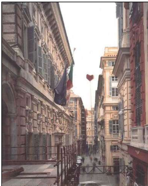
Figure 58 : La rue Garibaldi durant les travaux de sa réhabilitation pour Gênes capitale de la culture européenne en 2004 (Alcozer, et al., 2004)
