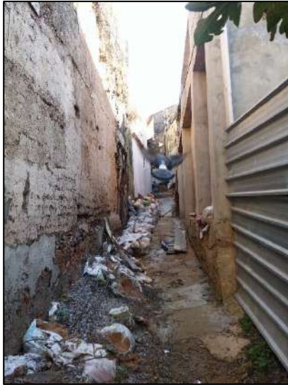
Figure 13 : ruelle du quartier Ain Ksiba avec, à gauche une maison traditionnelle, et à droite une nouvelle construction et un chantier en lieu et place d'anciennes maisons démolies (Auteur)
