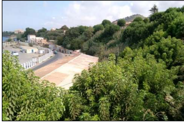
Figure 80 : La toiture du hangar de réparation de petits bateaux, vu de la place (Auteur)
