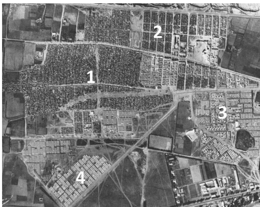
Fig. 25 : Ecohard, AA (1955, n. 60) 1. Le bidonville ,2. Le bidonville amélioré : Noualas sur trame sanitaire ,3. Trame réalisée, chantier traditionnel ,4. Trame réalisée en série, procédé « Tournaley » (source : Marilena_KOURNIATI).
