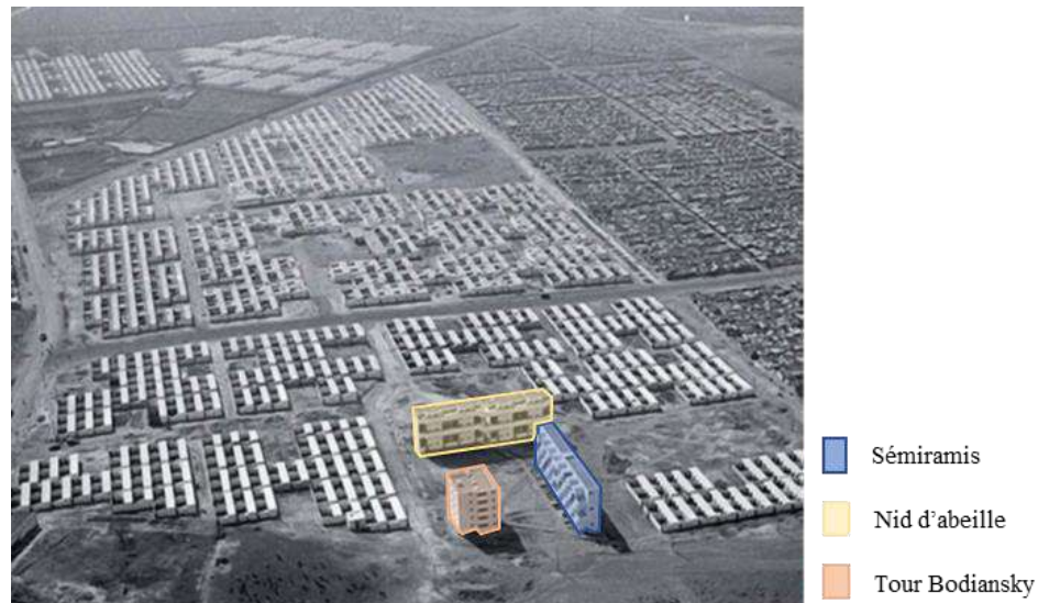
Fig. 28 : Les trois immeubles collectifs réalisés par l'ATBAT en 1951, au milieu de la trame horizontale, source (Coslett, Daniel), traité par auteur.
