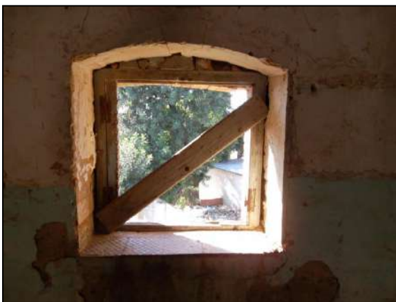
Photo 4.30 : Vue intérieure d'une grande fenêtre
