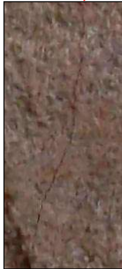
Photos 4.66, 4.67 et 4.68 : Fissures longitudinales
