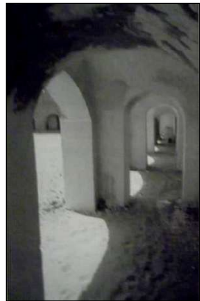
Photo 3.29 : Vue sur le péristyle du Fort Lallemand
