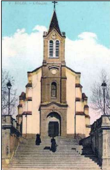
Photo 2.26 : La façade de l'église de Koléa
