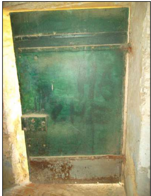
Photo 4.25 : La face intérieure de la porte d'accès à l'édifice
