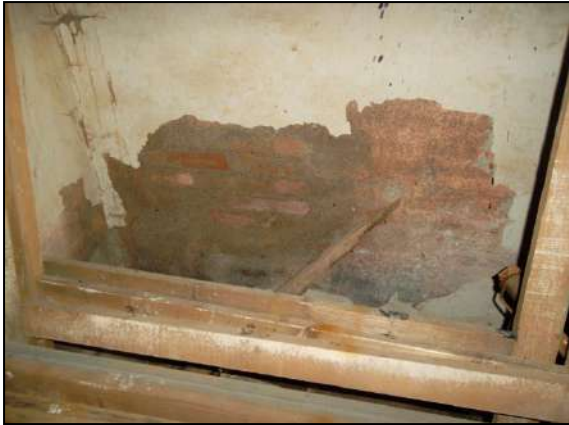
Photo 4.42 : Portion de la partie en brique du mur intérieur du R.D.C
