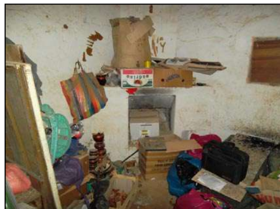
Photo 4.40 : La cheminée du R.D.C
