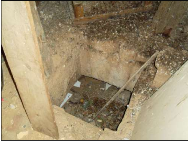
Photo 4.8 : La trappe du sous-sol
