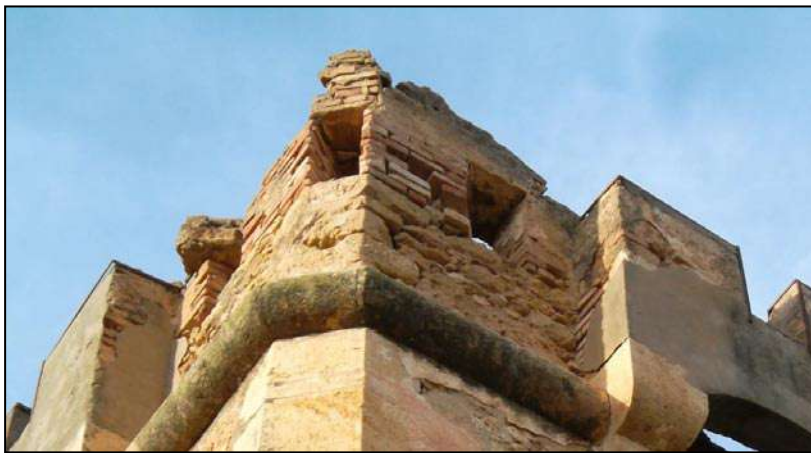
Photo 4.21 : Le traitement oblique du parapet à l'angle S-O
