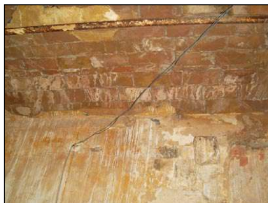
Photo 4.82 : Voûtain encastré dans le mur porteur à la rive
