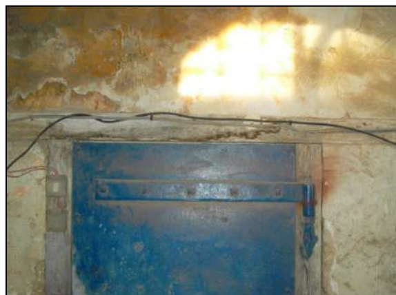
Photo 4.79 : Linteau et une partie du jambage en bois de la porte intérieur (R.D.C)
