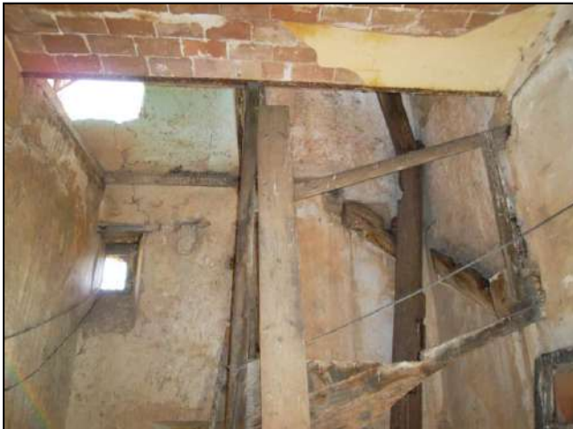
Photo 4.10 : La structure de l'escalier
