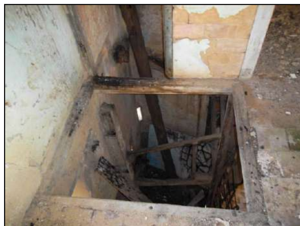
Photo 4.15 : Le vide qui suit la porte du premier étage
