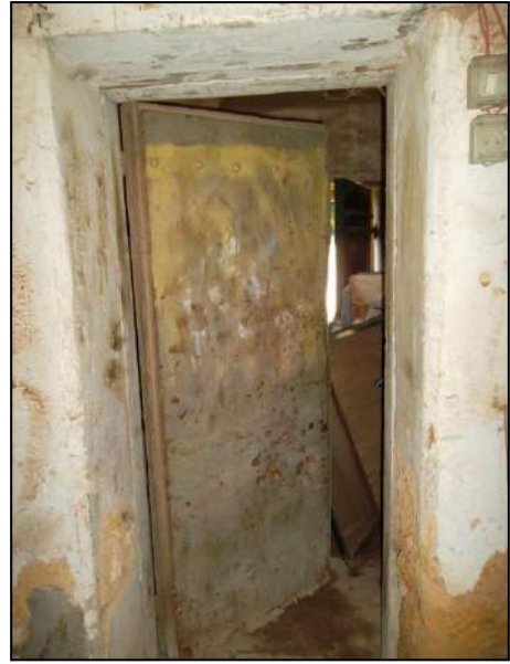
Photo 4.27 : La face intérieure de la porte intérieure
