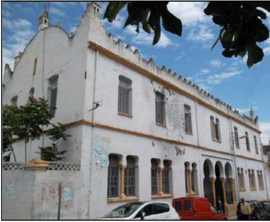
Photo 2.31 : Façade principale de l'ancienne école maternelle
