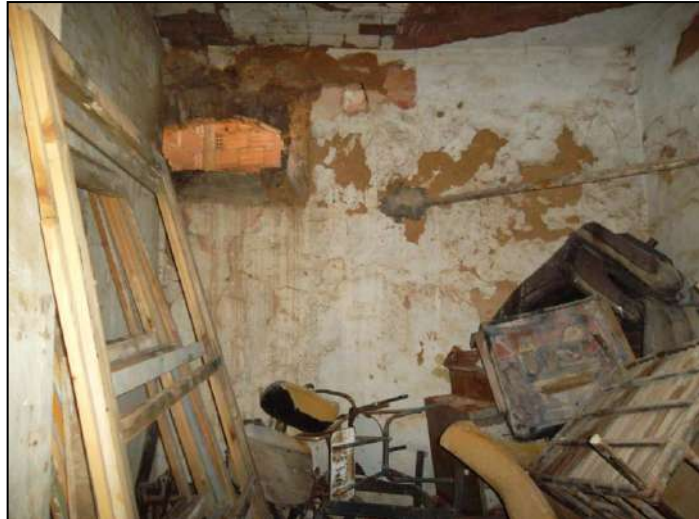
Photo 4.12 : Vue à l'intérieur de la deuxième salle du rez-de-chaussée
