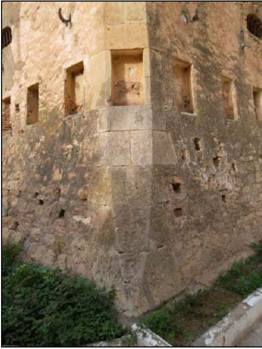
Photo 4.22 : Le traitement d'angle à la base
