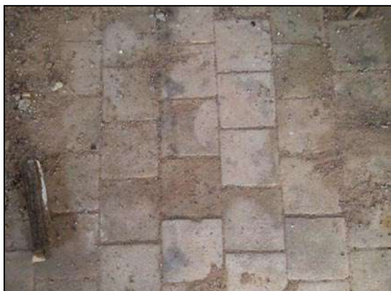
Photo 4.39 : Revêtement du sol du premier étage
