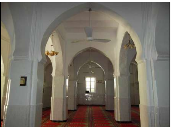
Photo 2.12 : une des travées de la mosquée
