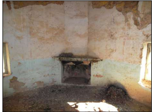
Photo 4.14 : Vue sur l'angle sud-est du premier étage
