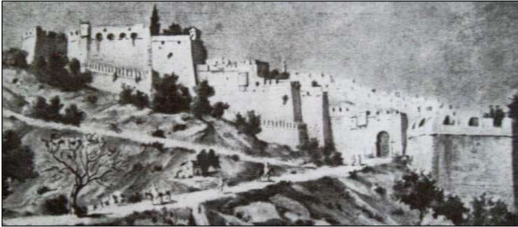
Figure 3.31 : Vue sur Bâb el-djadid et la double muraille
