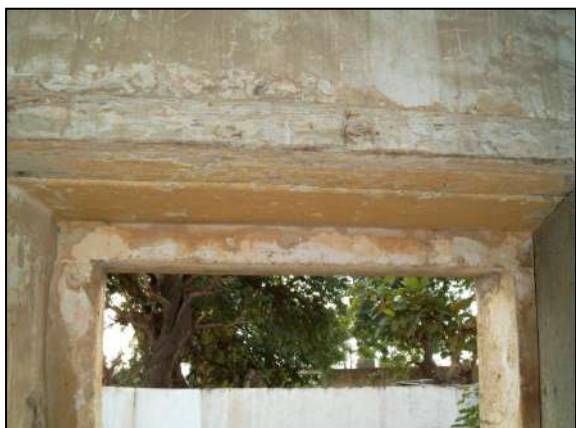
Photo 4.78 : Linteau en bois de la porte principale
