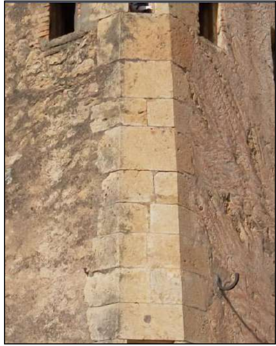
Photo 4.23 : Le traitement d'angle au-dessus de la base
