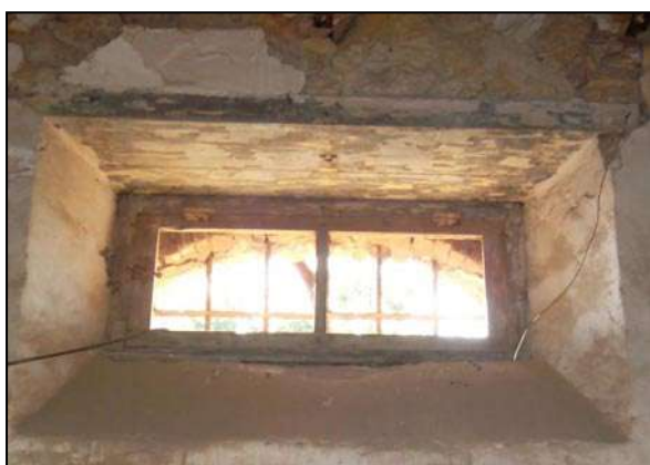
Photo 4.80 : Linteau intérieur et châssis en bois de la petite fenêtre
