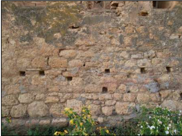
Photo 4.83 : Nature des pierres à la base de l'édifice
