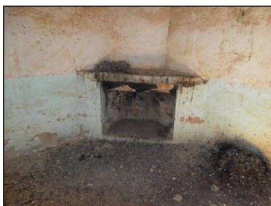
Photo 4.41 : La cheminée du premier étage
