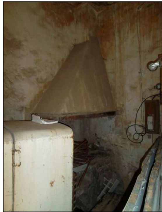
Photo 4.11 : Le potager et la hotte du rez-de-chaussée
