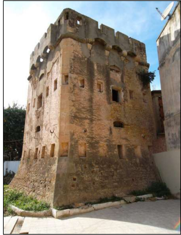
Photo 4.6 : Vue du blockhaus à partir de l'angle sud-est
