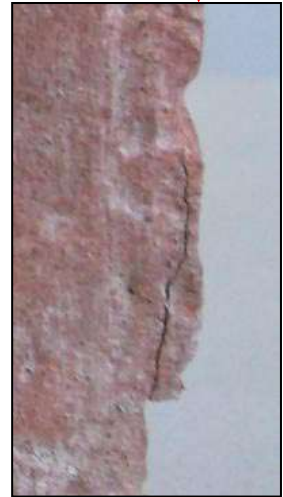
Photo 4.75 : Fissures longitudinales
