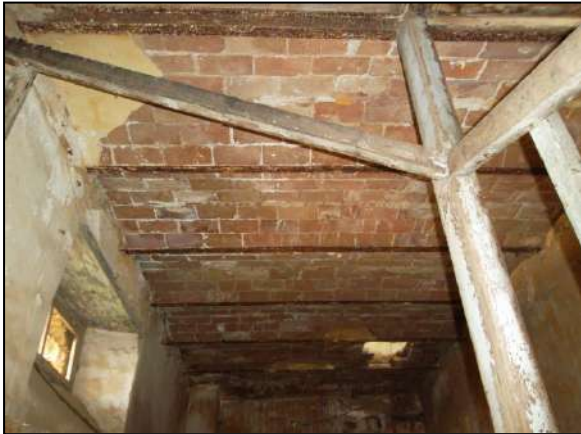
Photo 4.85 : Une partie du plancher du premier étage
