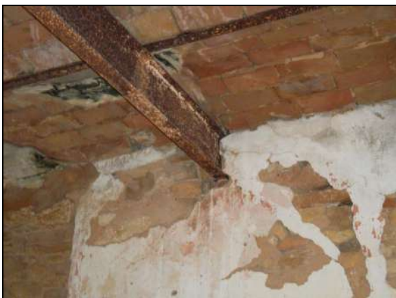
Photo 4.87 : La poutrelle intermédiaire au premier étage supportant les poutrelles
