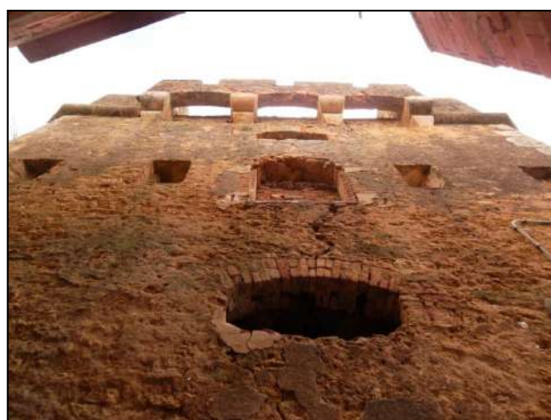
Photo 4.19 : Vue sur une partie de la façade nord
