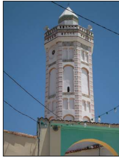
Photo 2.9 : Le minaret de la mosquée
