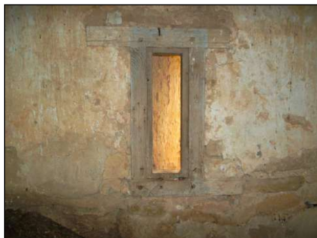
Photo 4.36 : Meurtrière encadrée de l'intérieure
