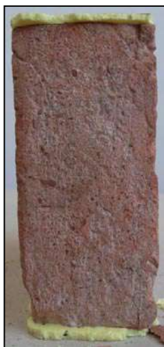
Photo 4.76 : Fissures longitudinales et transversales
