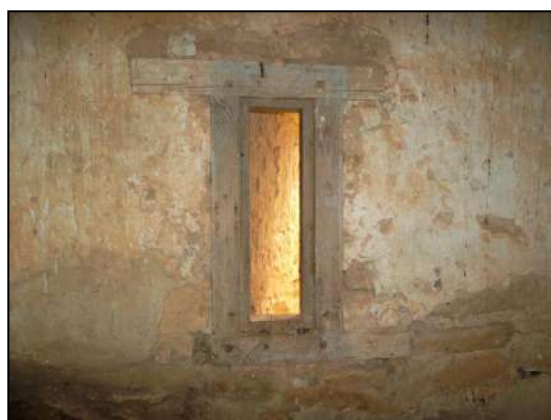
Photo 4.81 : Encadrement intérieur en bois d'une meurtrière
