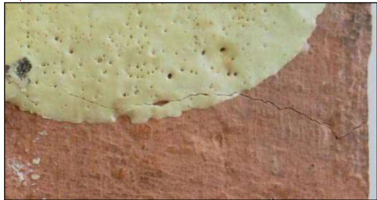
Photo 4.61 : Fissure transversale
