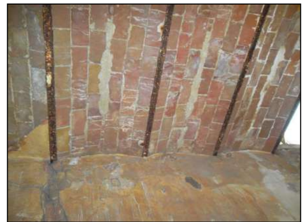
Photo 4.88 : Le mur porteur intermédiaire du R.D.C supportant les poutrelles
