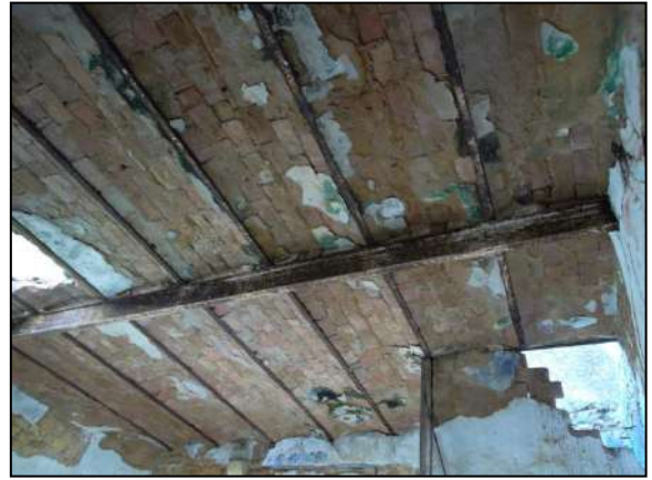
Photo 4.86 : Vue sur le plancher du deuxième étage
