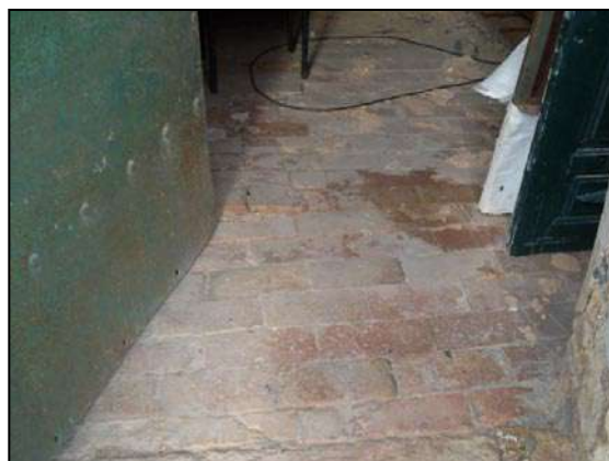
Photo 4.38 : Revêtement du sol du R.D.C
