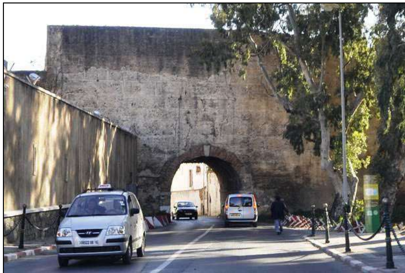
Photo 3.18 : Vue sur la porte de Bâb el-djadid
