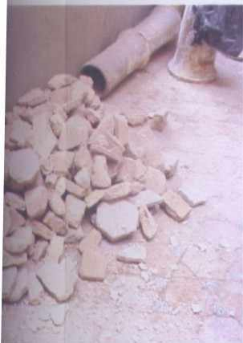
TTES RECUPEREES LORS D'UN PLANCHER DE TERRASSE.
