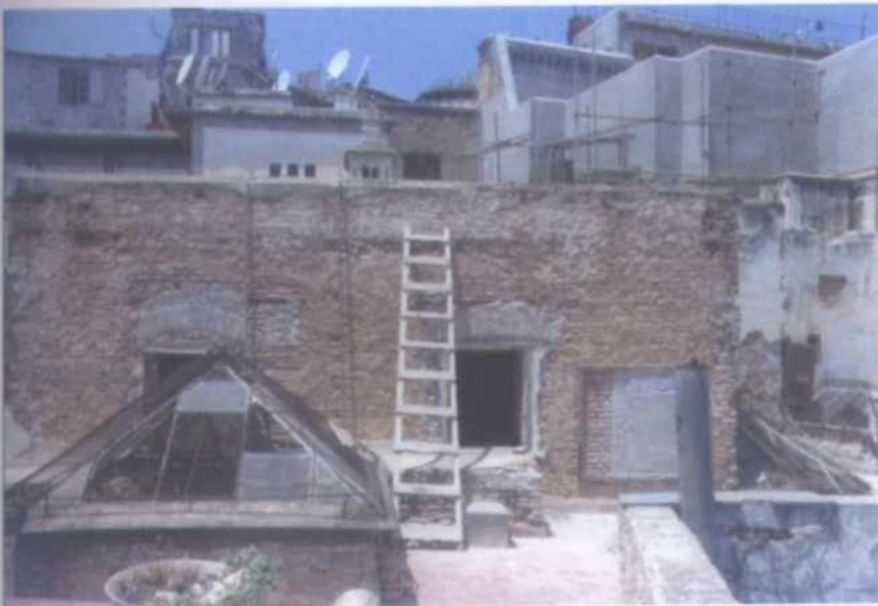
FIGURE 376 : MUR SUD-OUEST DE LA TROISIEME PARTIE DE TERRASSE.
