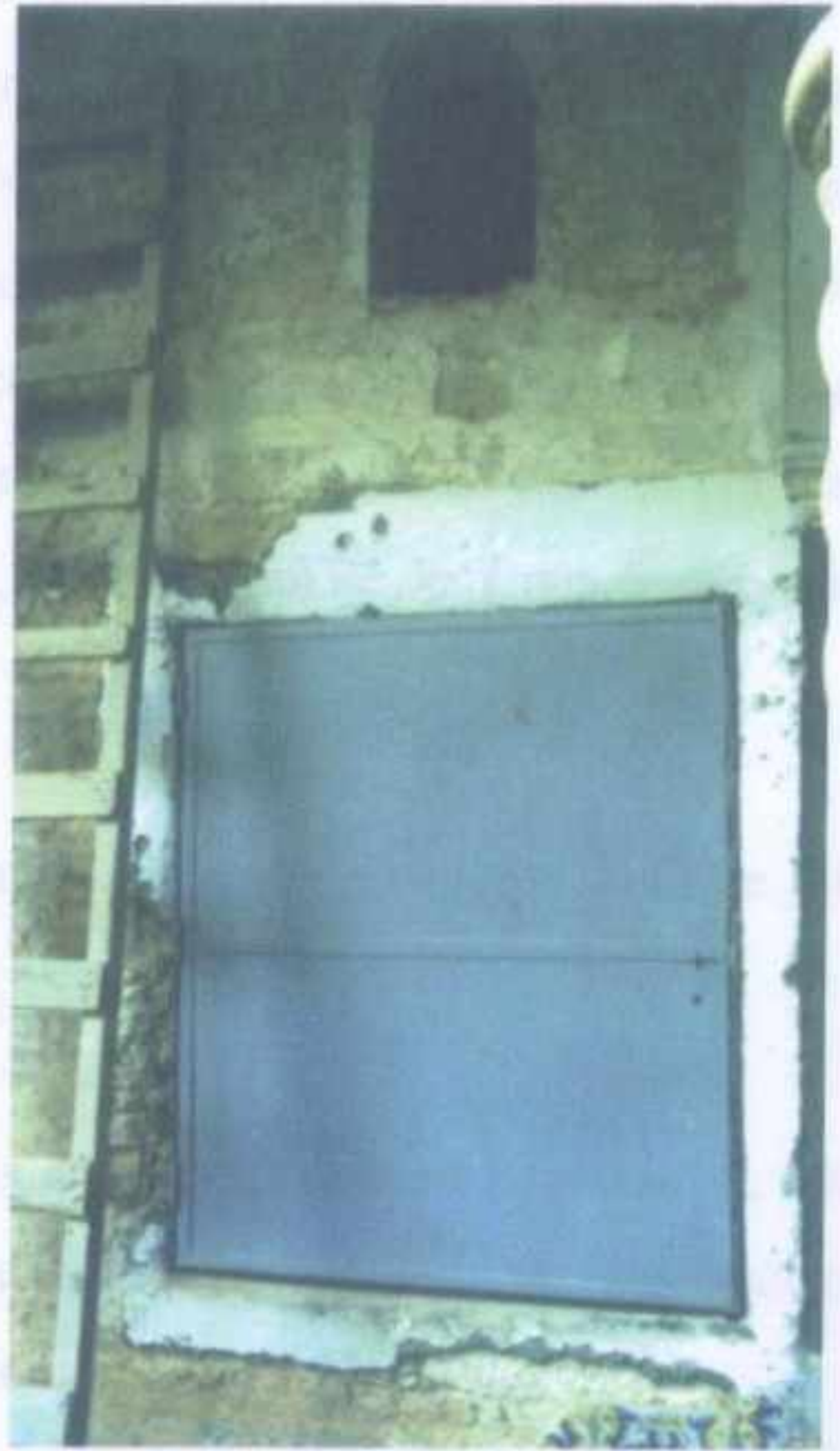
FIGURE 344 : TRANSFORMATION D'UNE FENETRE EN PORTE AU NIVEAU DE LA GALERIE [Gal se 201].
