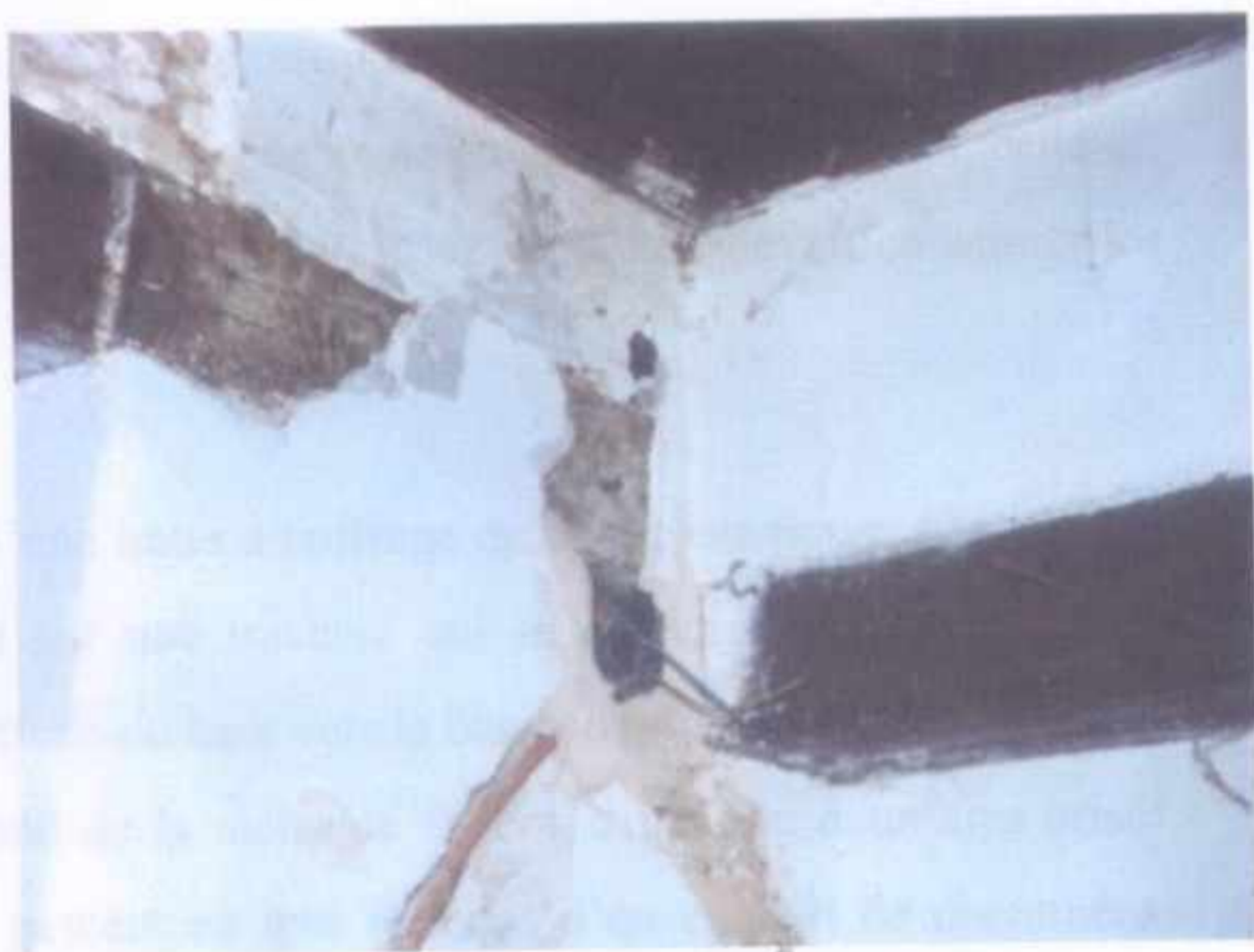
LES EPAIS LINTEAUX DE BOIS. (Ci-dessus et ci-contre à droite).
