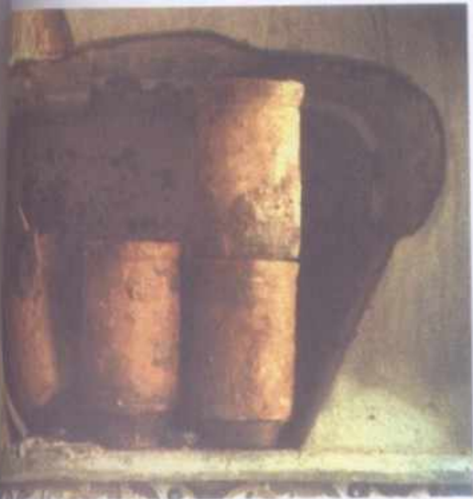
FIGURE 436 : ELEMENTS EN POTERIE DONT UN TYPE CYLINDRO-CONIQUE S'EMBOITANT DANS LES AUTRES POUR FORMER LA CONDUITE.
