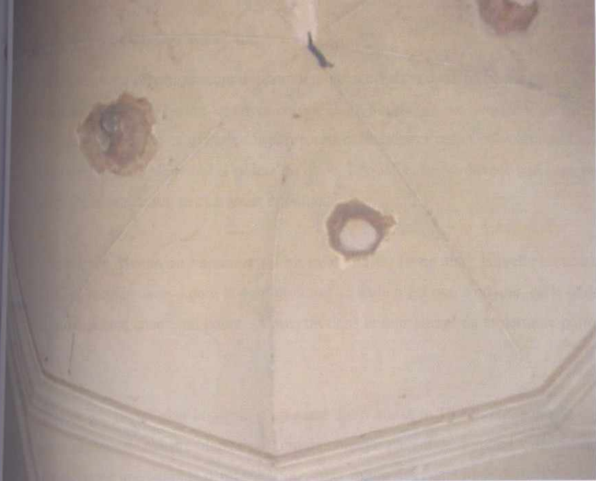
FIGURE 410 : COUPOLE DE LA CHAMBRE FROIDE.
