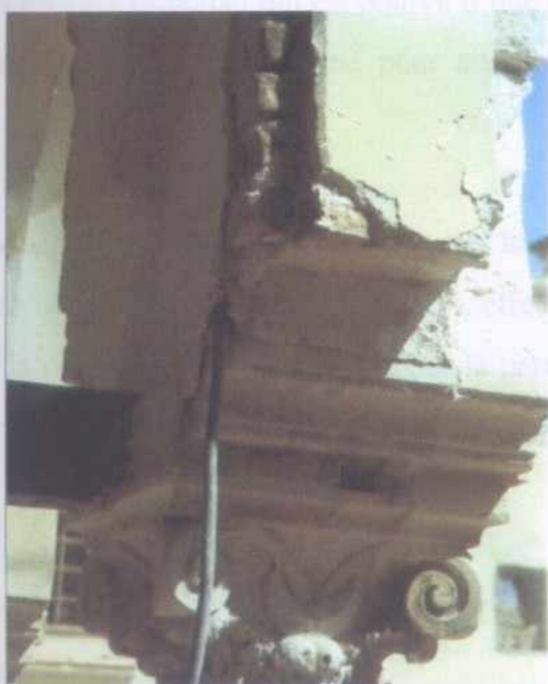
FIGURE 364 : DETAIL DE L'INTERVENTION FRANCAISE. LE BELVEDERE A PORTIQUE [P so 301].
