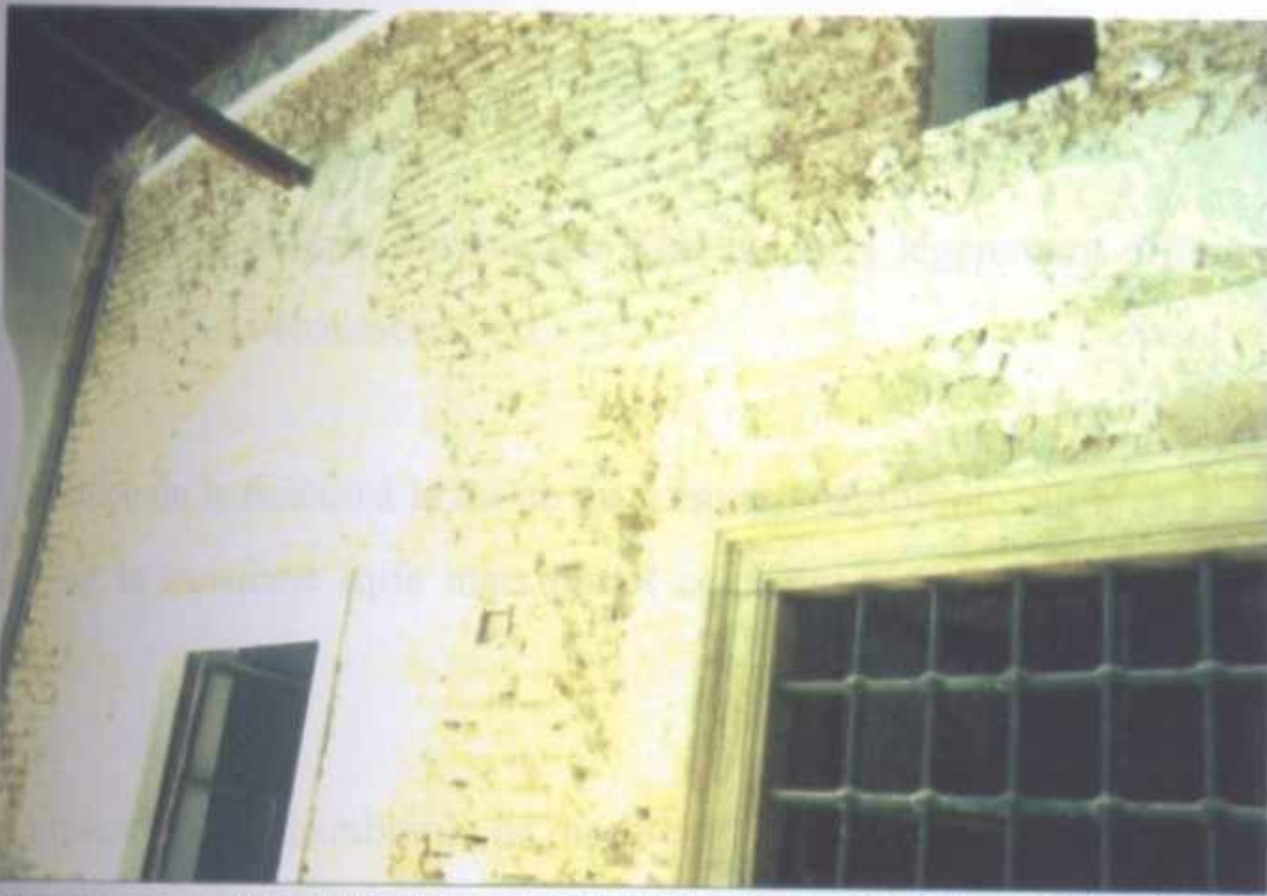
FIGURE 342 : TRACES D'ANCIENNES OUVERTURES ARQUEES RE-OBSTRUEES SURMONTANT LES FENETRES.
