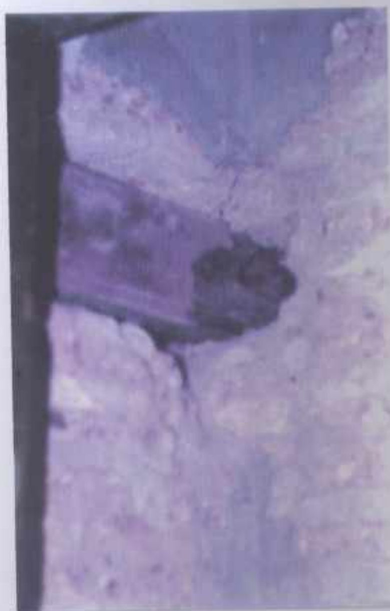
FIGURE 401 : DECOUVERTE DE LA PARTIE RESTANTE D'UNE CONSOLE DE BOIS ENCASTREE.
