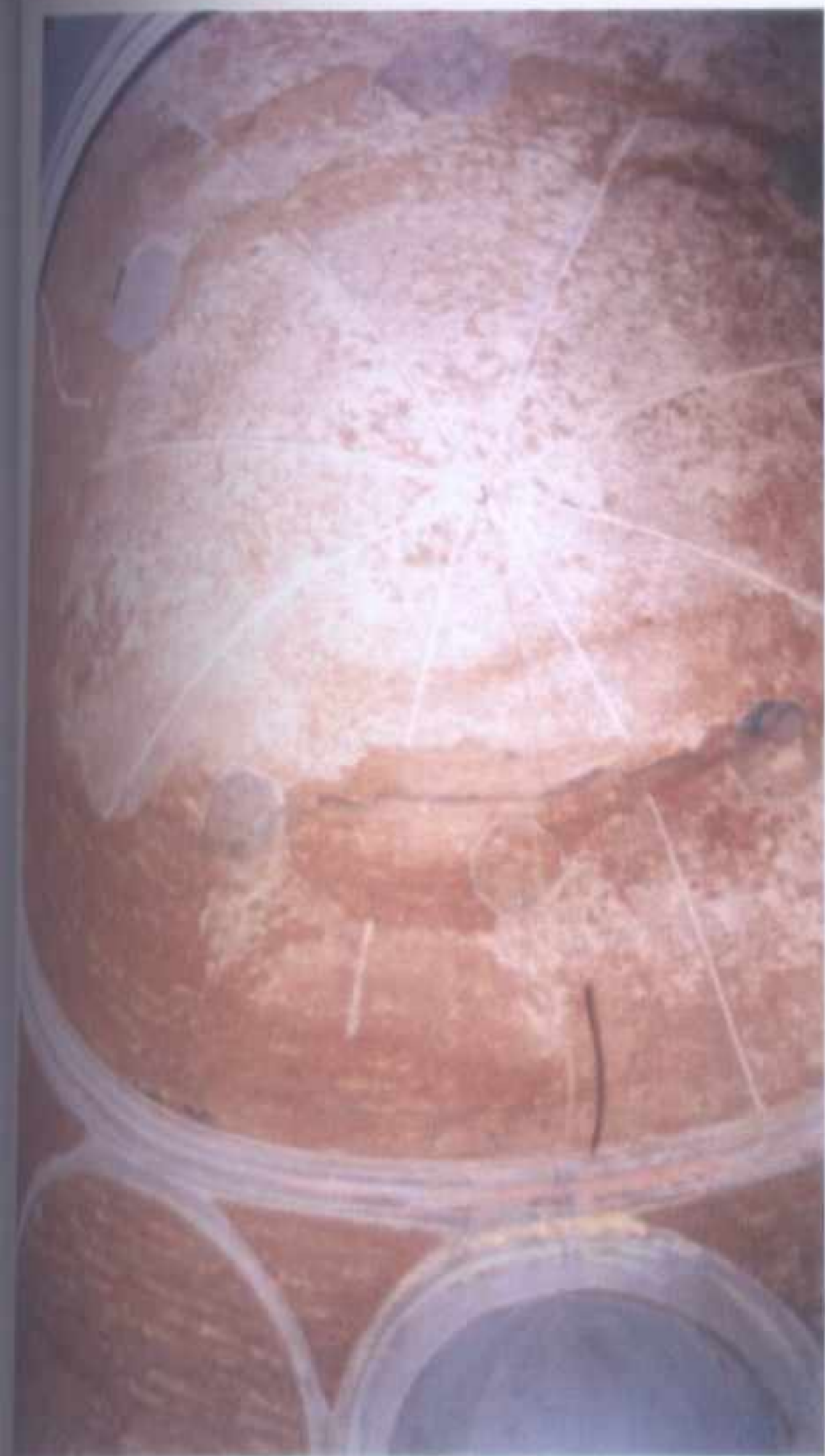
FIGURE 412 : COUPOLE DE LA CHAMBRE CHAUDE.
