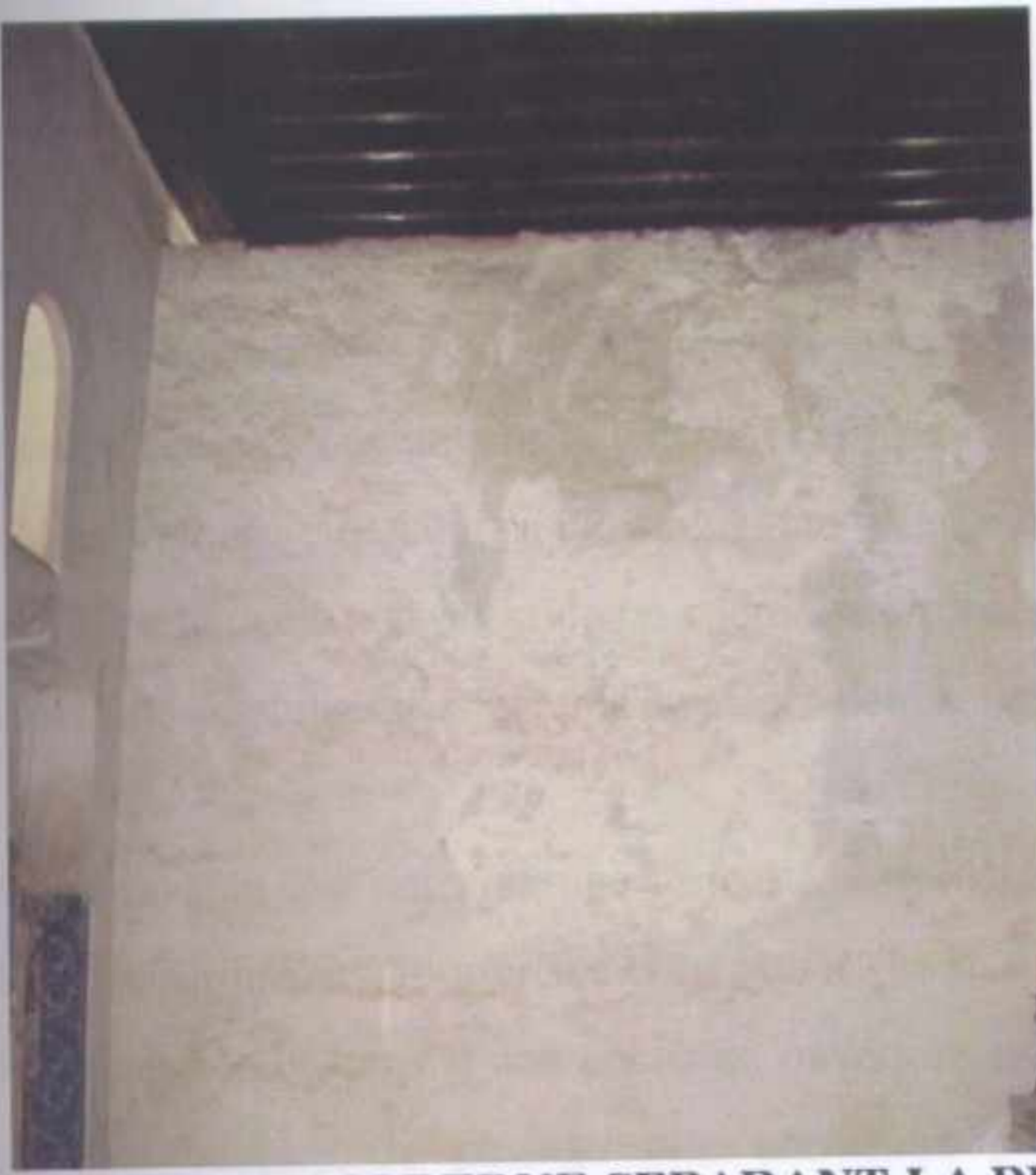
FIGURE 350 : CLOISON MODERNE SEPARANT LA PIECE [P se 201]. (Cliché personnel).
