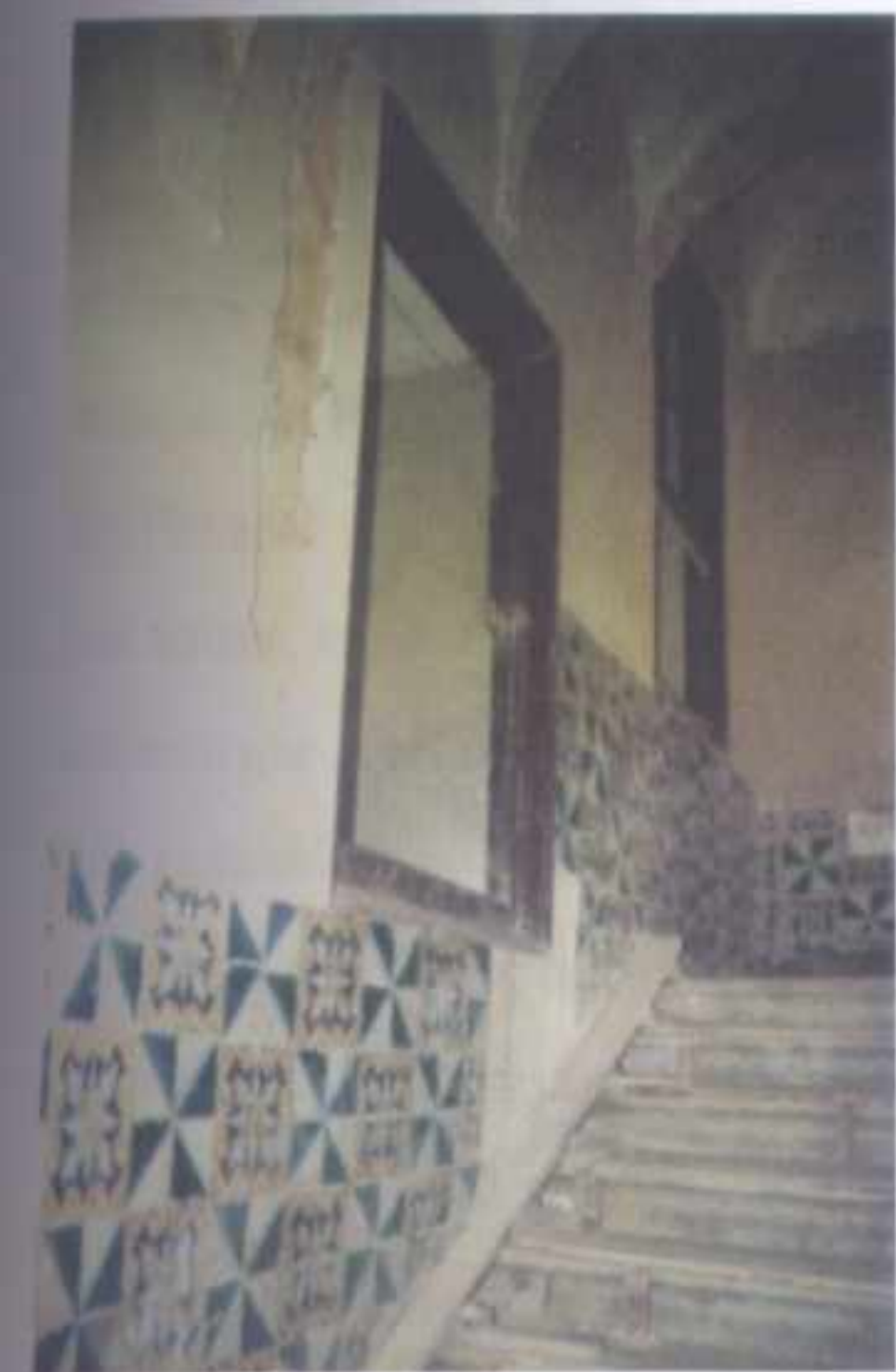
FIGURE 384 : LES DEUX BAIES FRANCAISES PERCANT LE MUR LATERAL DE LA TROISIEME VOLEE.
