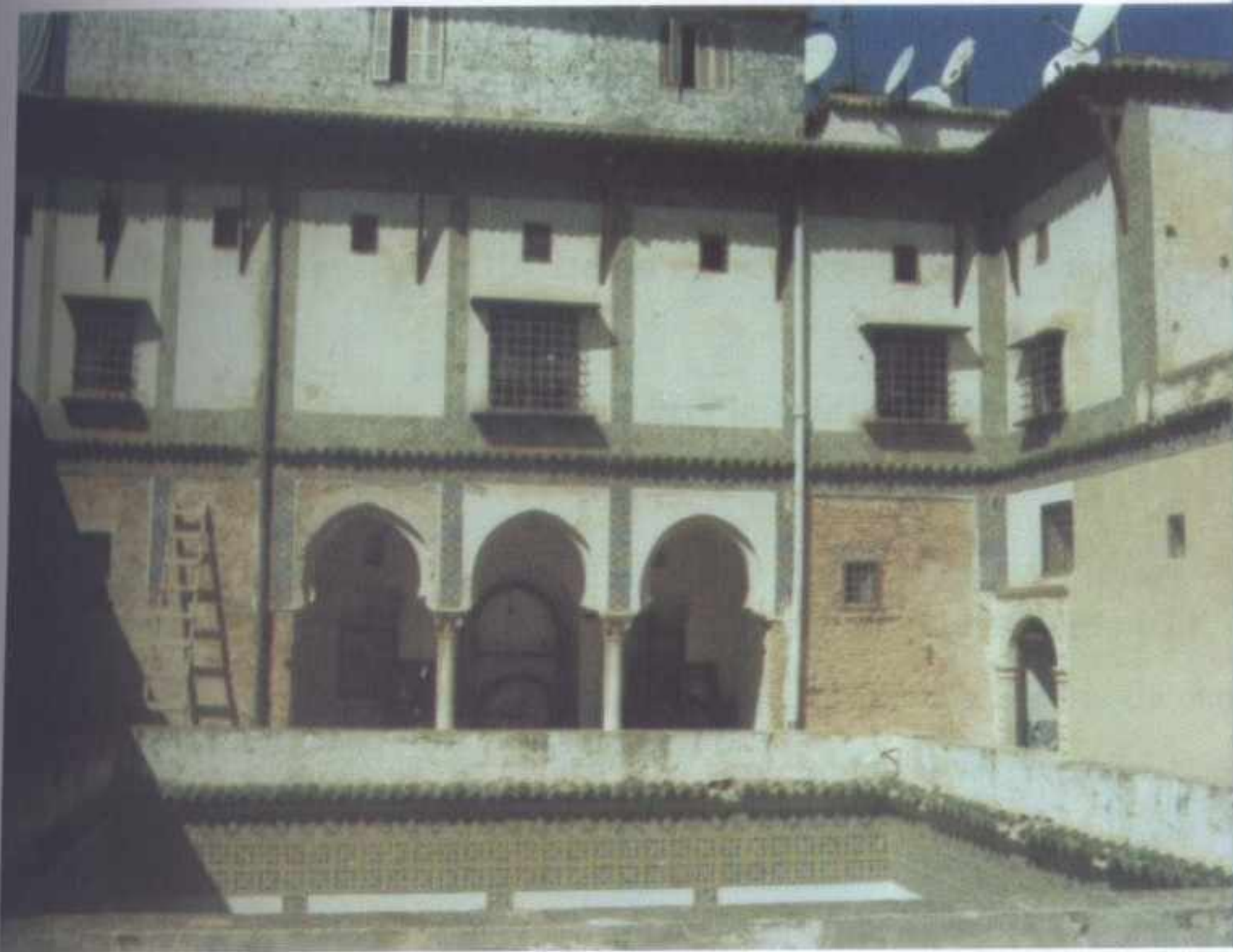
FIGURE 372 : FACADE SUR TERRASSE.
