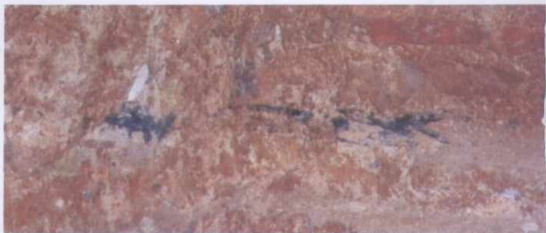
FIGURE 416 : TRACES DE LA PLAQUE DE SCHISTE QUI DEVAIT SURMONTER LES RESEVOIRS D'EAU.
