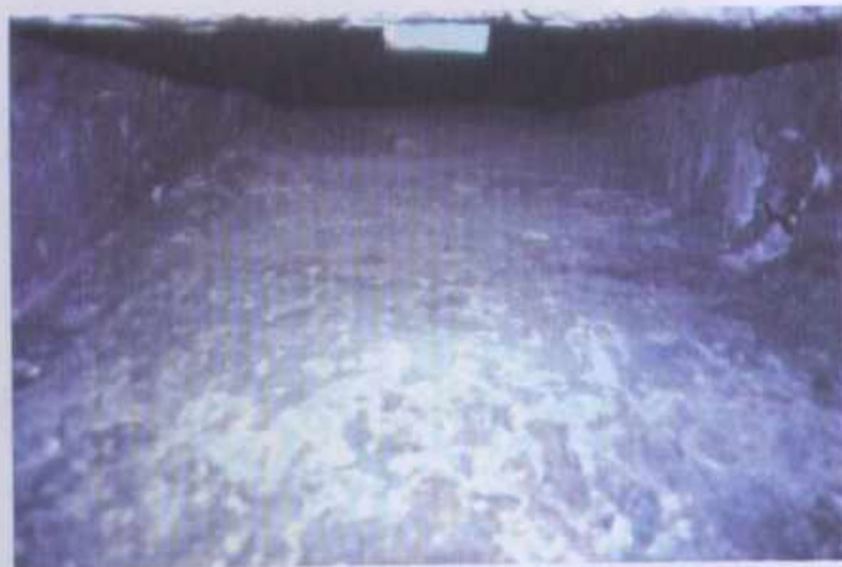
FIGURE 400 : CONDUIT DE CHEMINEE SE POURSUIVANT JUSQU'EN TERRASSE.
