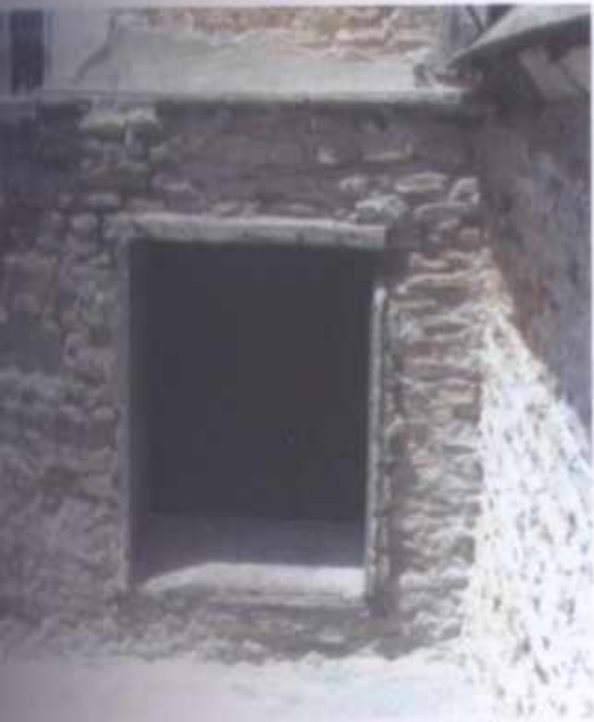
FIGURE 375 : FENETRE DE L'ESPACE "BIZARRE" SUR LA TERRASSE.
