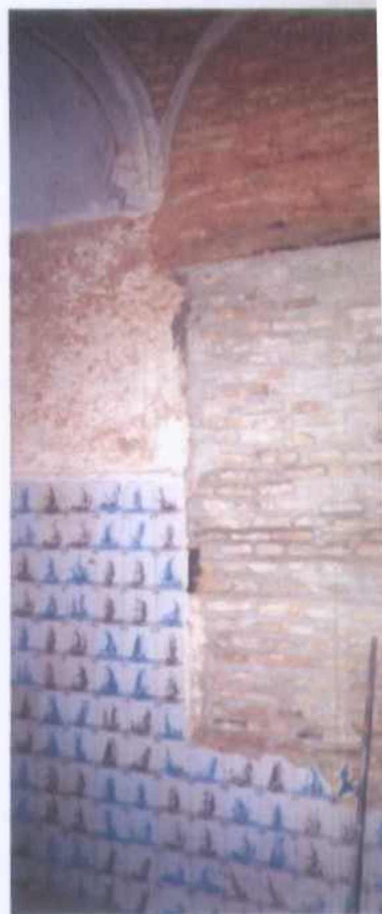
FIGURE 413 : FENETRE SUR DE LA PERIODE COLONIALE
