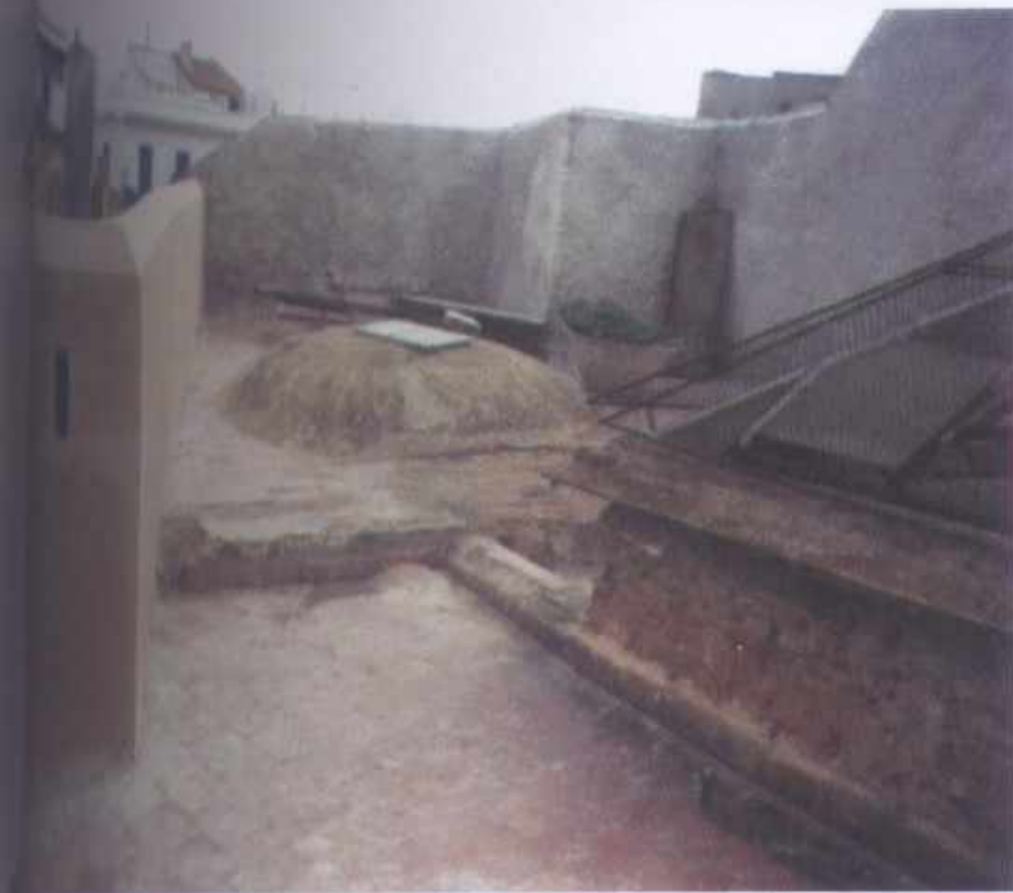
FIGURE 378 : QUATRIEME PARTI DE TERRASSE [Ter no 301] Dôme correspondant à la coupole de la chambre froide. (Cliché personnel).
