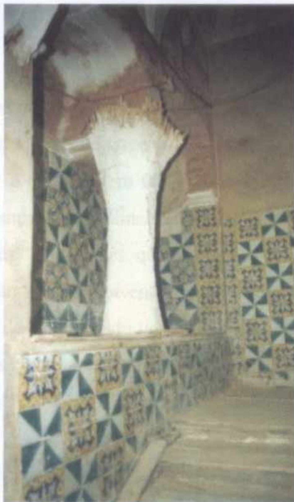
FIGURE 382 : NICHE-BANQUETTE PRATIQUEE DANS LE MUR LATERAL DE LA SECONDE VOLEE DE L'ESCALIER PRINCIPAL.
