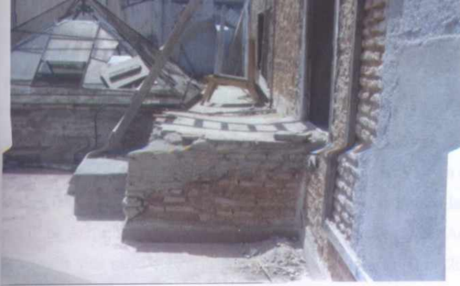
FIGURE 374 : PLATE-FORME COUVRANT L'ESPACE "BIZARRE" [P no 306].
