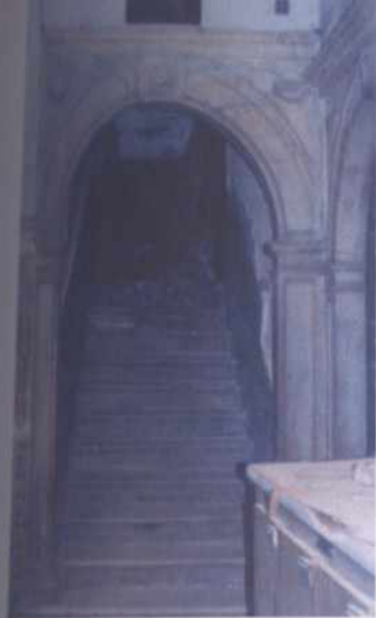
FIGURE 381 : AMORCEMENT DE L'ESCALIER PRINCIPAL.
