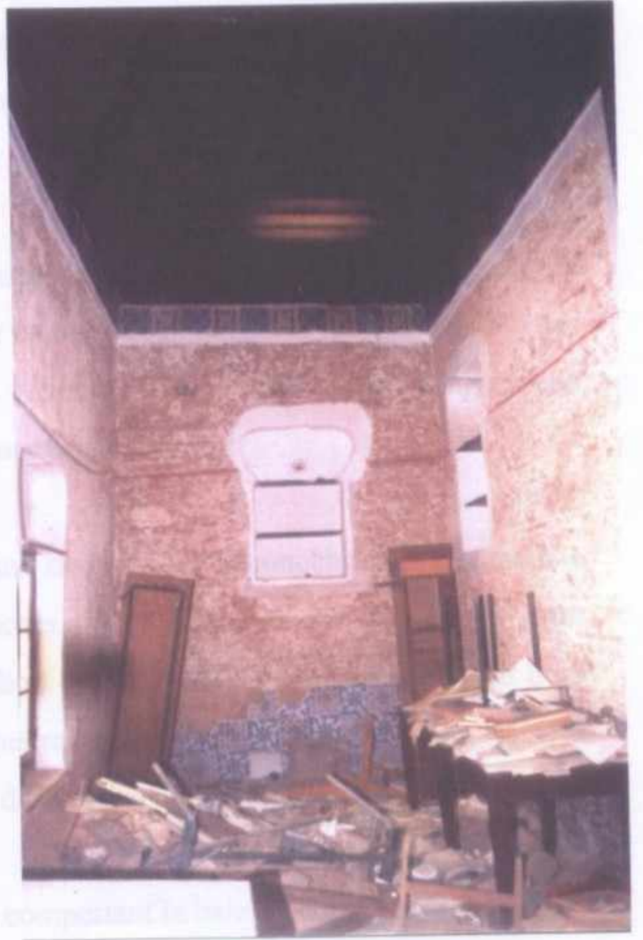
FIGURE 351 : NICHES-PLACARDS SURELEVEES AU NIVEAU DE LA PIECE [P ne 201]. (Cliché personnel).
