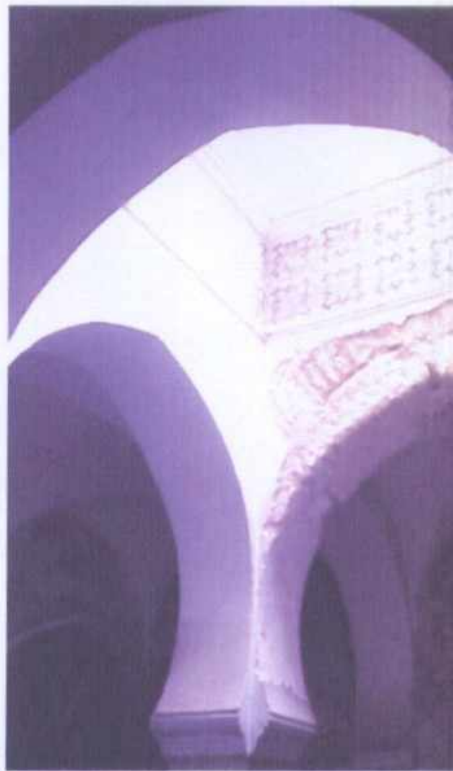
FIGURE 394 : TREMIE SURMONT CENTRALE DE LA CUISINE.
