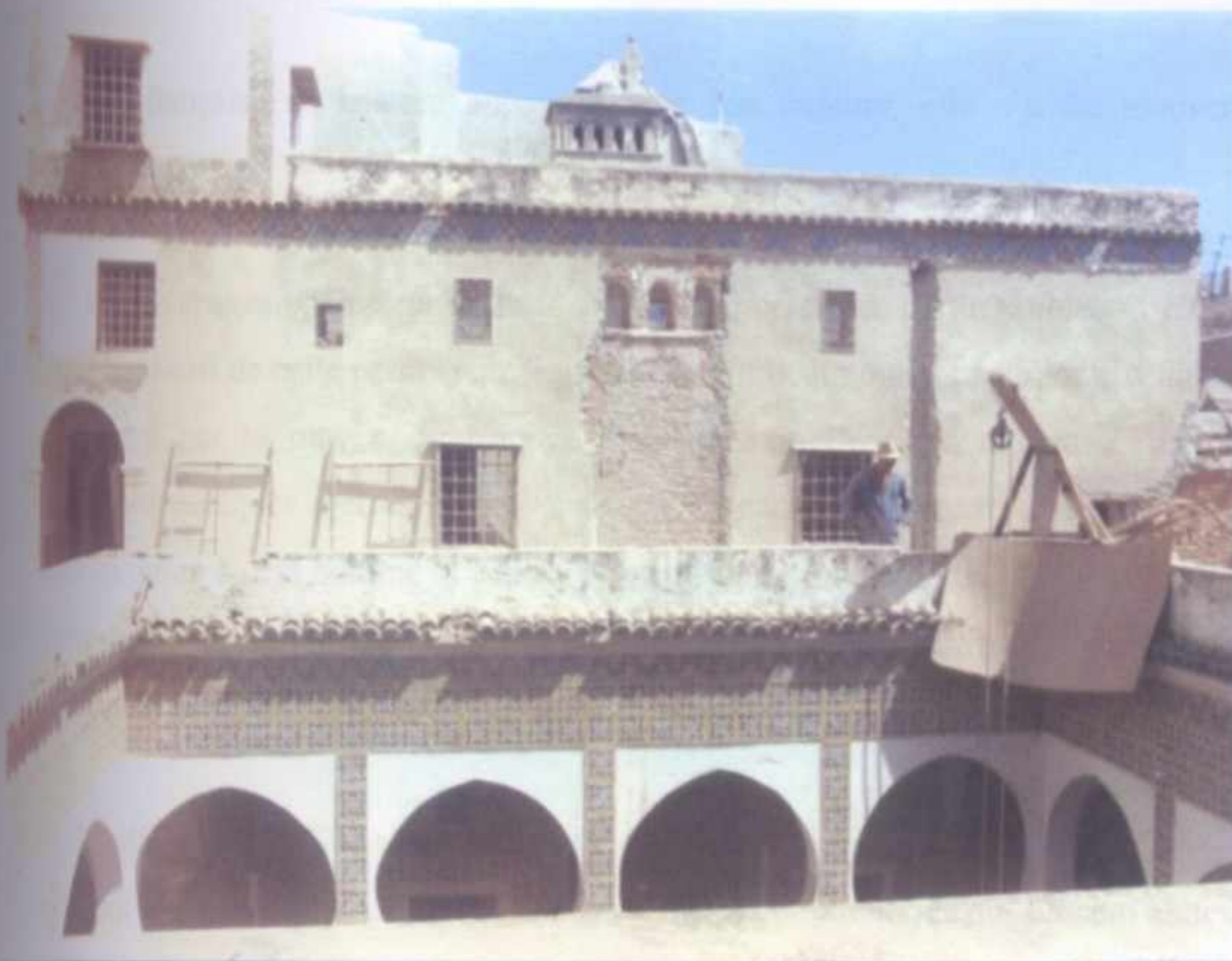
FIGURE 370 : MUR DE L'ALLEE EN TERRASSE [Gal no 301]. (Cliché personnel).
