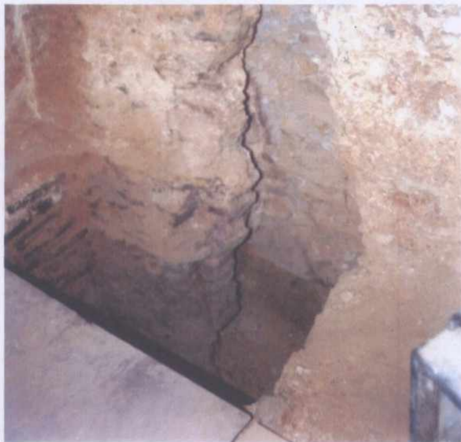
FIGURE 417 : DECOUVERTE DU VIDE SOUS LE PLANCHER ET DES HYPOCAUSTES.
