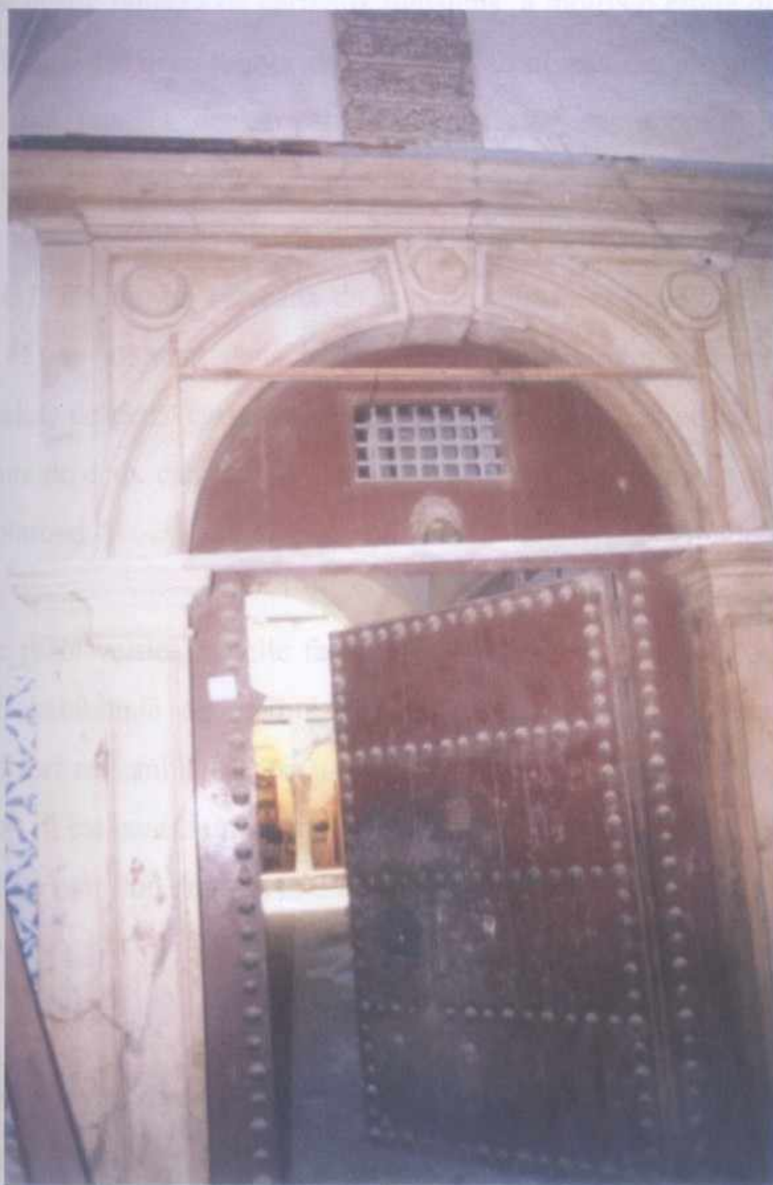
FIGURE 332 : PORTE S'OUVRANT SUR LA GRANDE SQIFA.
