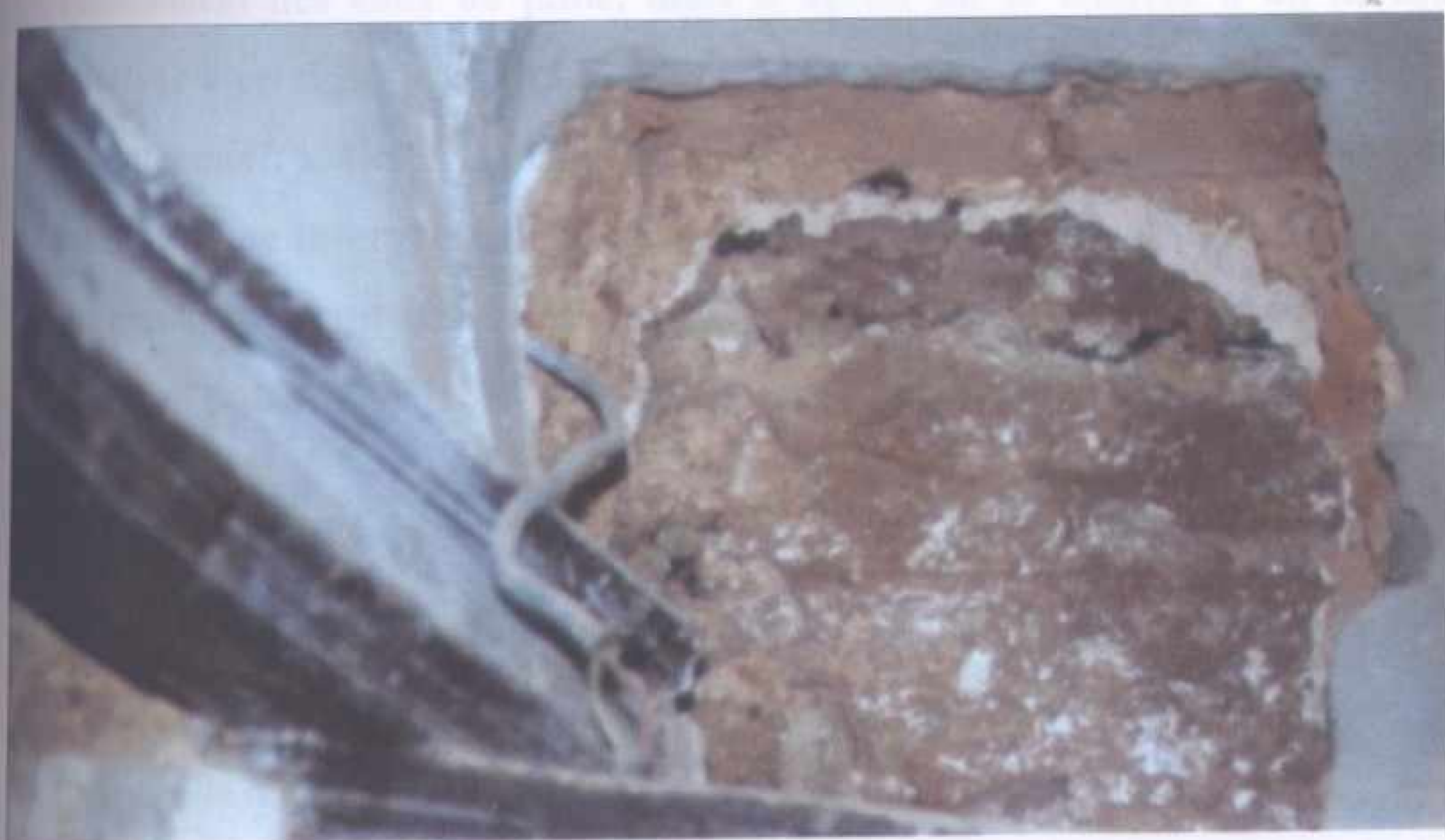
FIGURE 425 : TRACES DE BADIGEONNAGE A LA CHAUX ENTRE LES DEUX MURS MITOYENS DE DAR ESSOUF ET DE DAR MUSTAPHA PACHA.
