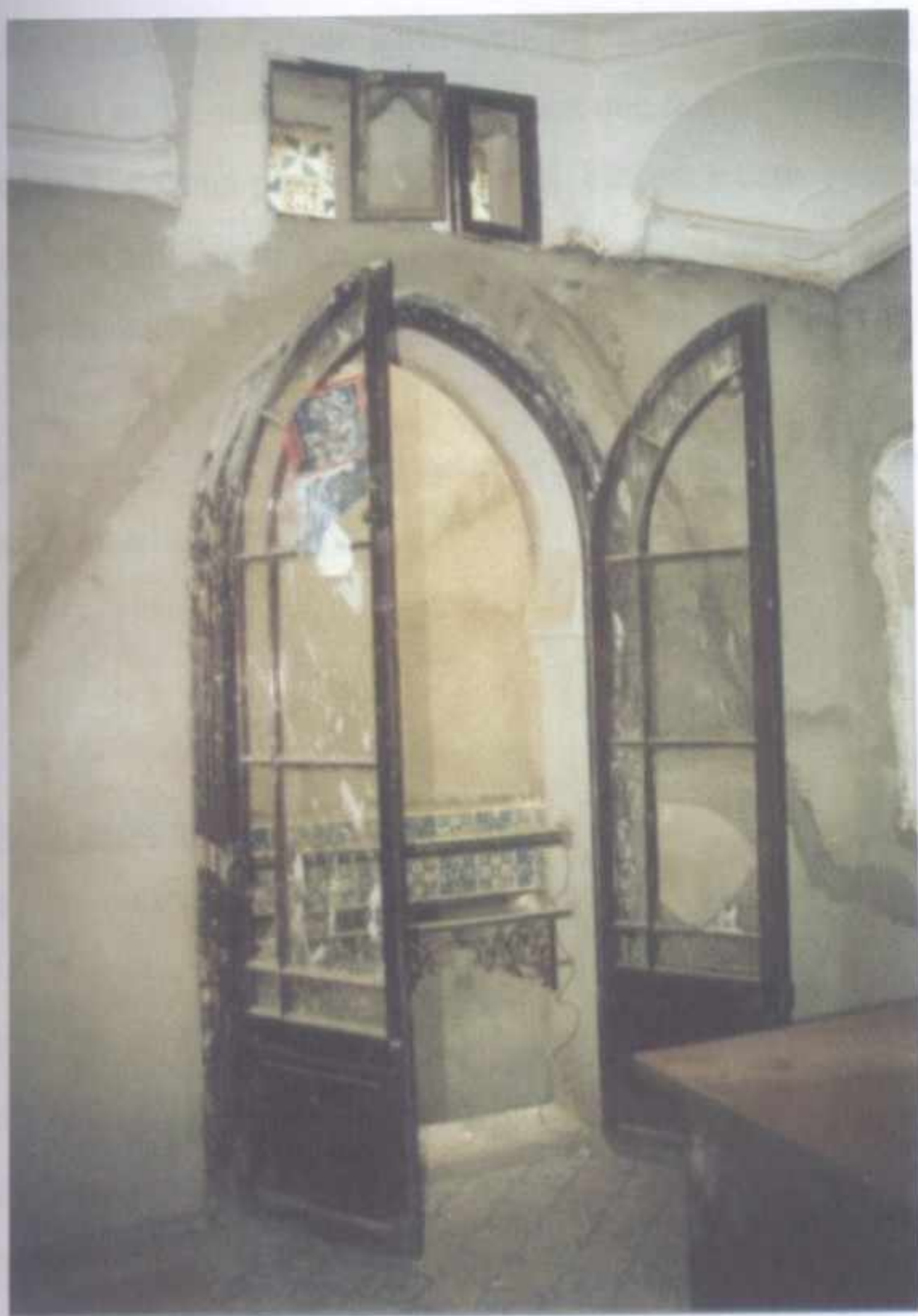
FIGURE 359 : BAIE FRANCAISE, VITREE ET POURVUE DE GARDE-CORPS.
