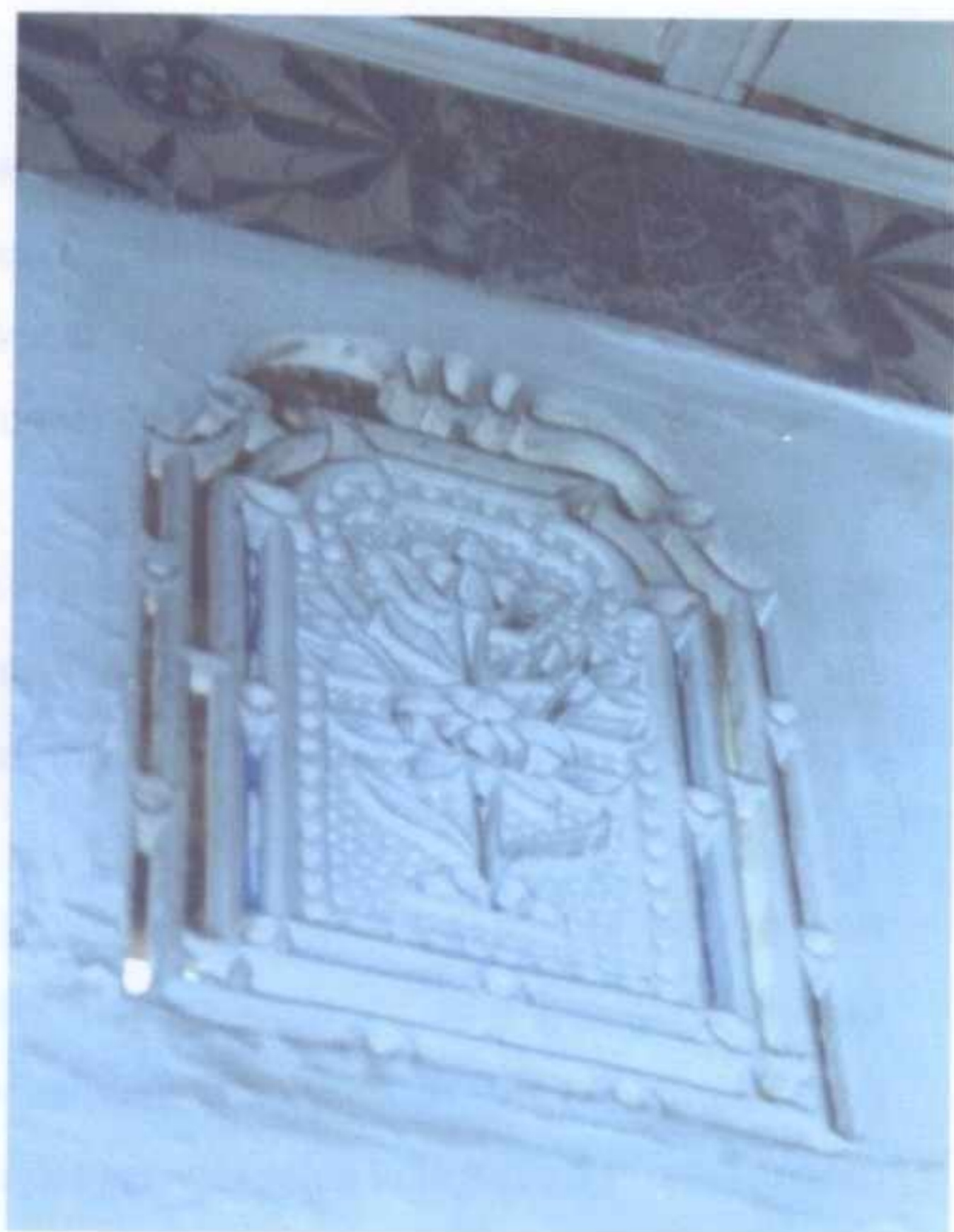
FIGURE 431 : CLAUSTRAS EN PLATRE AJOURE ET VITRAUX AU NIVEAU DU KOUCHEK.
