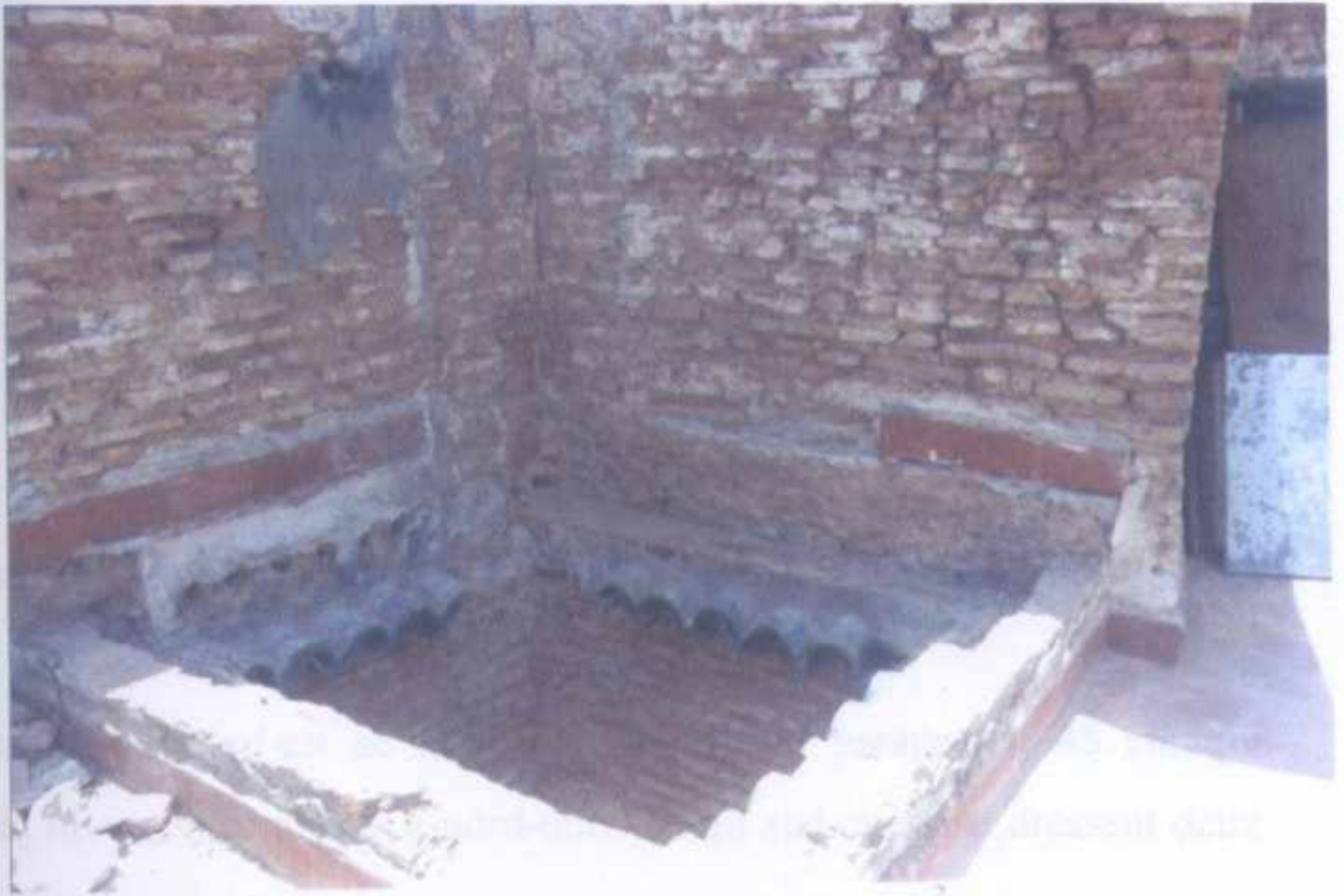
FIGURE 379 : QUATRIEME PARTIE DE TERRASSE [Ter no 301] Trémie du puits de lumière à "Café du Dey" [C ne 201]. (Cliché personnel).
