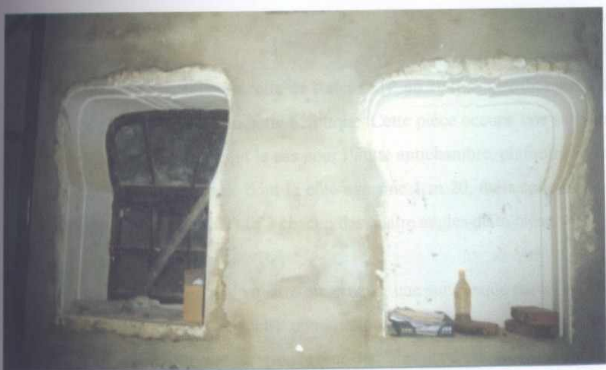
FIGURE 358 : NICHE-PLACARD PERCEE ET TRANSFORMEE EN BAIE VITREE.
