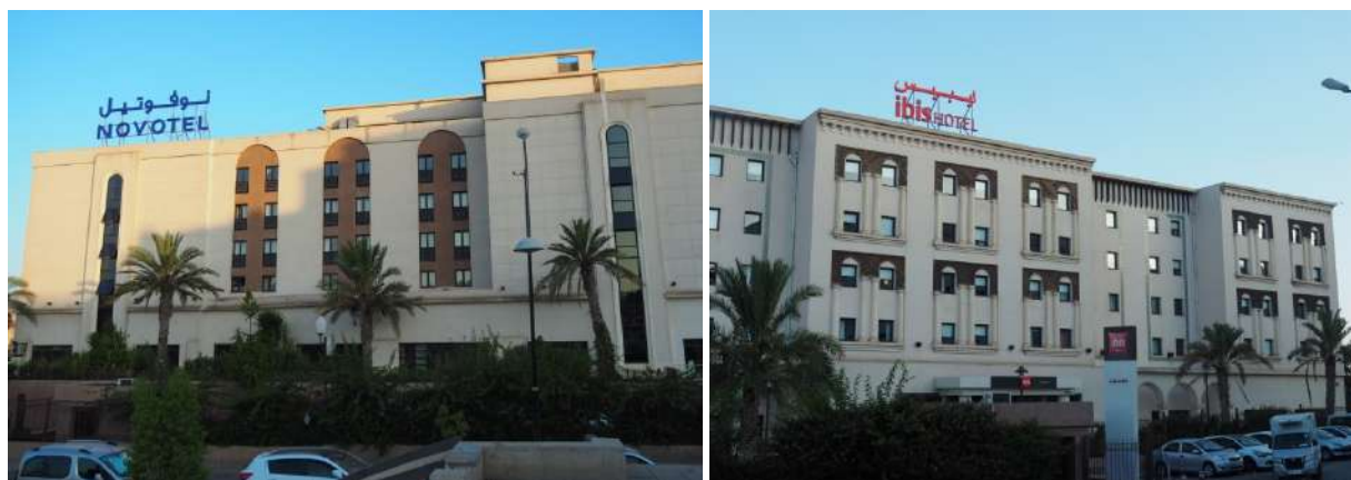
Figure 44: Hôtels construits sur l'emplacement du square Panis. Photo: N. Baziz (septembre 2017)
