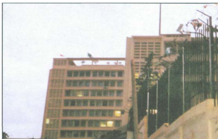
Figure 2 : Photo du siège de la Sonatrach, rue du Sahara, Hydra.
