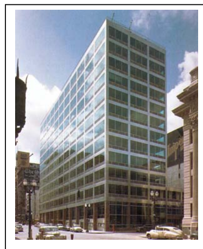
Figure 10: Le "Lever building", un des premiers environnements hermétiques en mur-rideau de verre, New York, 1952 (source: www.bc.edu [En ligne, téléchargé le 27.01.03])
