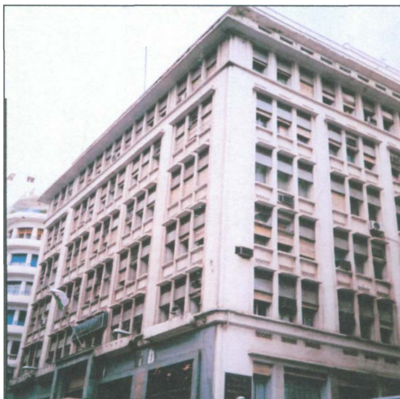
Figure 1 : Photo de l'ancien édifice de la Sonatrach, boulevard Mohammed V, Alger centre (actuellement Ministère du Commerce).
