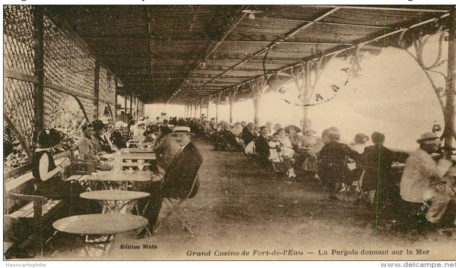
Figure 35 - Une ancienne photo de la pergola qui donnait sur la mer Source : https://www.delcampe.net/
