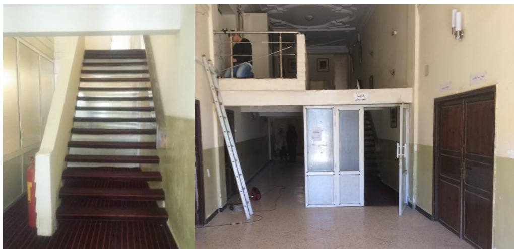
Figure 41 – Photos du couloir et de l'escalier intérieur rajouté ultérieurement Source : l'Auteur (2017)
