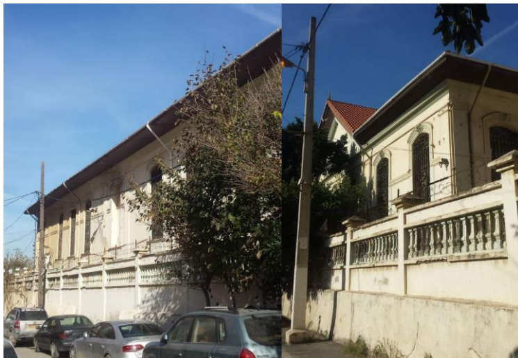
Figure 40 – Façade postérieure depuis l'extérieur Source : l'Auteur (2017)
