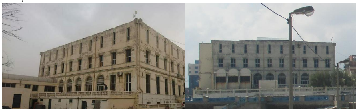
Figure 51 – Façade nord-ouest (sur mer) à l'état actuel Source : l'Auteur (2017)
