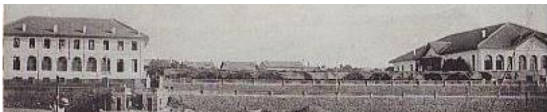
Figure 32 - Une ancienne photo qui montre le casino avec une partie du jardin
