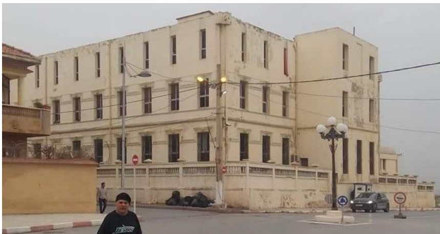
Figure 52 – Façade postérieure & sud-est à l'état actuel Source : l'Auteur (2017)
