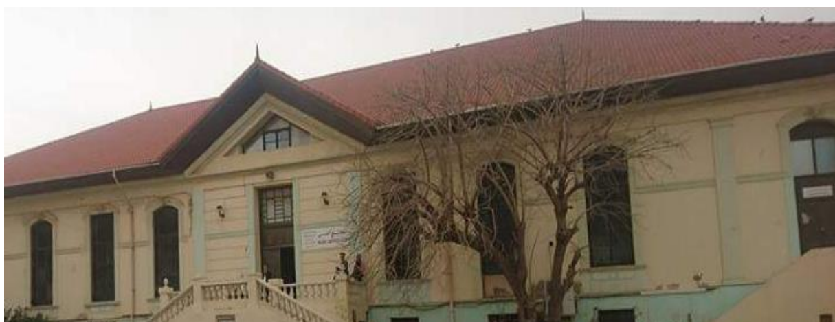
Figure 38 - Photo sur la façade principale dans son état actuel Source : l'Auteur, 2017.
