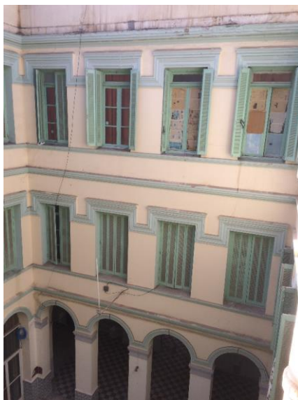
Figure 53 – Façade intérieure à l'état actuel Source : l'Auteur (2017)
