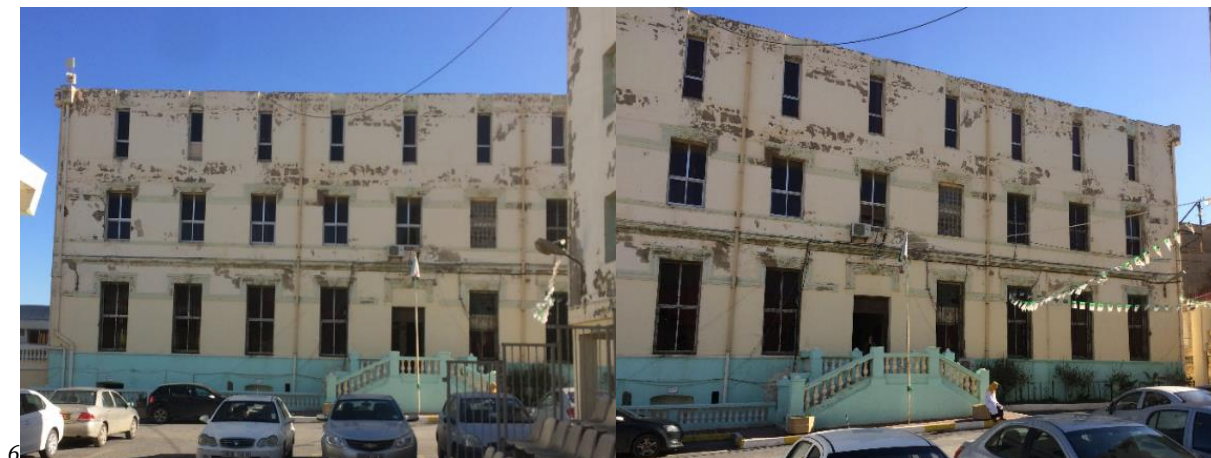
Figure 50 – Façade principale à l'état actuel Source : l'Auteur (2017)
