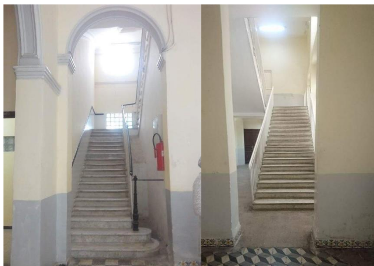
Figure 54 – Vue sur les escaliers à l'état actuel Source : l'Auteur (2017)
