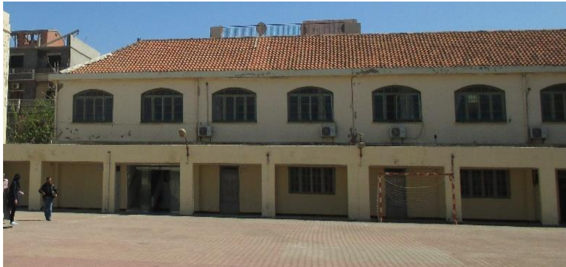
Figure 62 – Le bloc administratif
