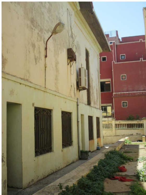
Figure 39 - Photo sur la façade nord-ouest dans son état actuel Source : l'Auteur, 2017.
