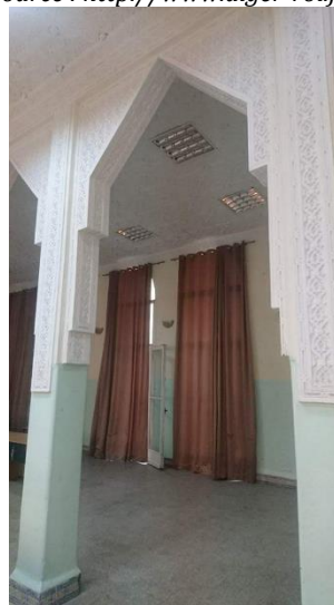
Figure 60 – Poteaux en béton armé, Salle de lecture Source : l'Auteur (2017)
