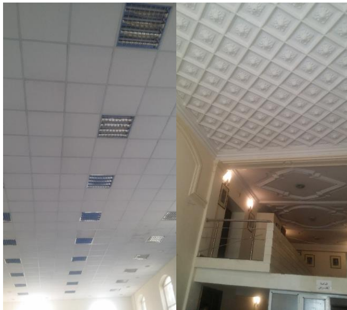
Figure 44 – Faux plafond récent dans la salle de danse
