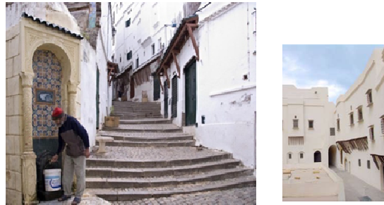
Figure 15 : la casbah d'Alger
