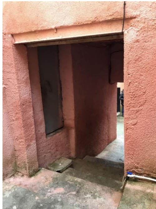
Figure 24 Entrée de la maison kabyle du village d'Ait djemaa (source : auteur)
