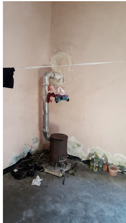
Figure 76: el kanoun (poêle à bois) de la chambre, (source auteur)
