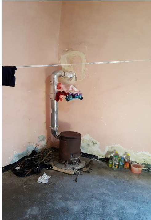
Figure 56: Photo Del kanoun de la chambre du RDC (source : auteur)
