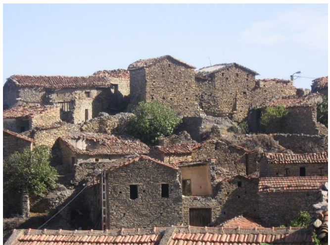
Figure 40 Ensembles de maisons vernaculaires kabyles du village de djaafra wilaya de bordj bou arredji utilisant des matériaux locaux (source : auteur)
