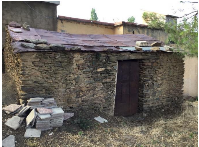
Figure 22 Maison vernaculaire kabyle dans le village de boumessoud dans la wilaya de Michelet ( Source : auteur )
