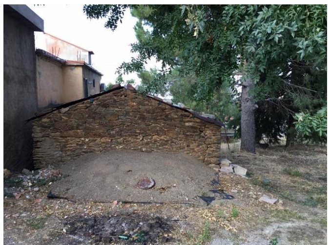
Figure 23 Maison vernaculaire kabyle dans le village de boumessoud dans la wilaya de Michelet (Source : auteur).
