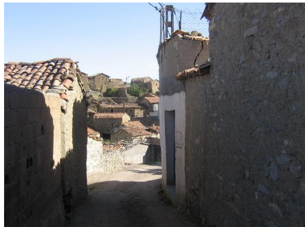
Figure 17 Ruelle du village de djaafra wilaya de bordj bou arredji (source :auteur)
