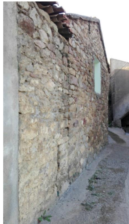
Figure 61: photo d'un des murs en pierre de la maison, (source : auteur)
