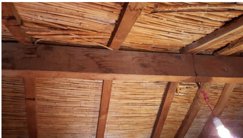
Figure 82: Vue sur la toiture de la chambre de stockage (source auteur)
