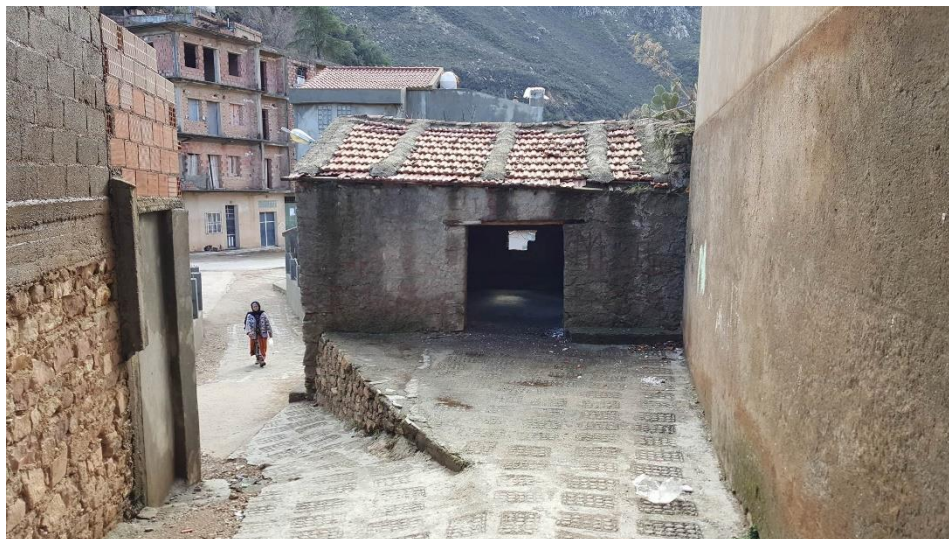
Figure 49 photo de tajmaat du village d'Ait djemaa, (source : auteur).
