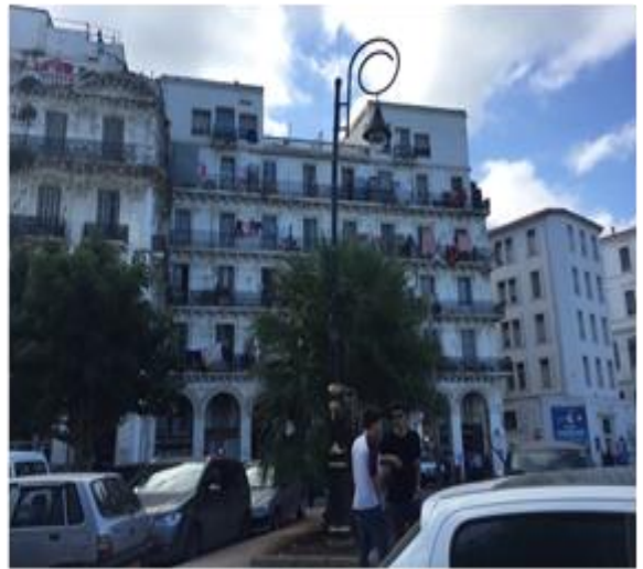
Façades peintes en blanc
