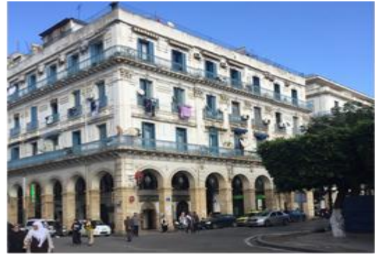
Façades peintes en blanc
