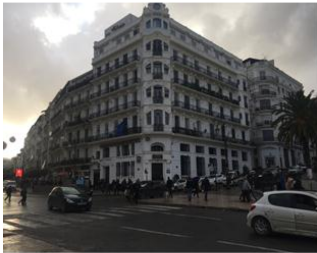
Façades peintes en blanc
