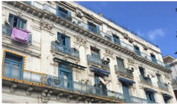
Fenêtre en bois ainsi que gardes corps en fer-forgé peinte en bleu clair.
