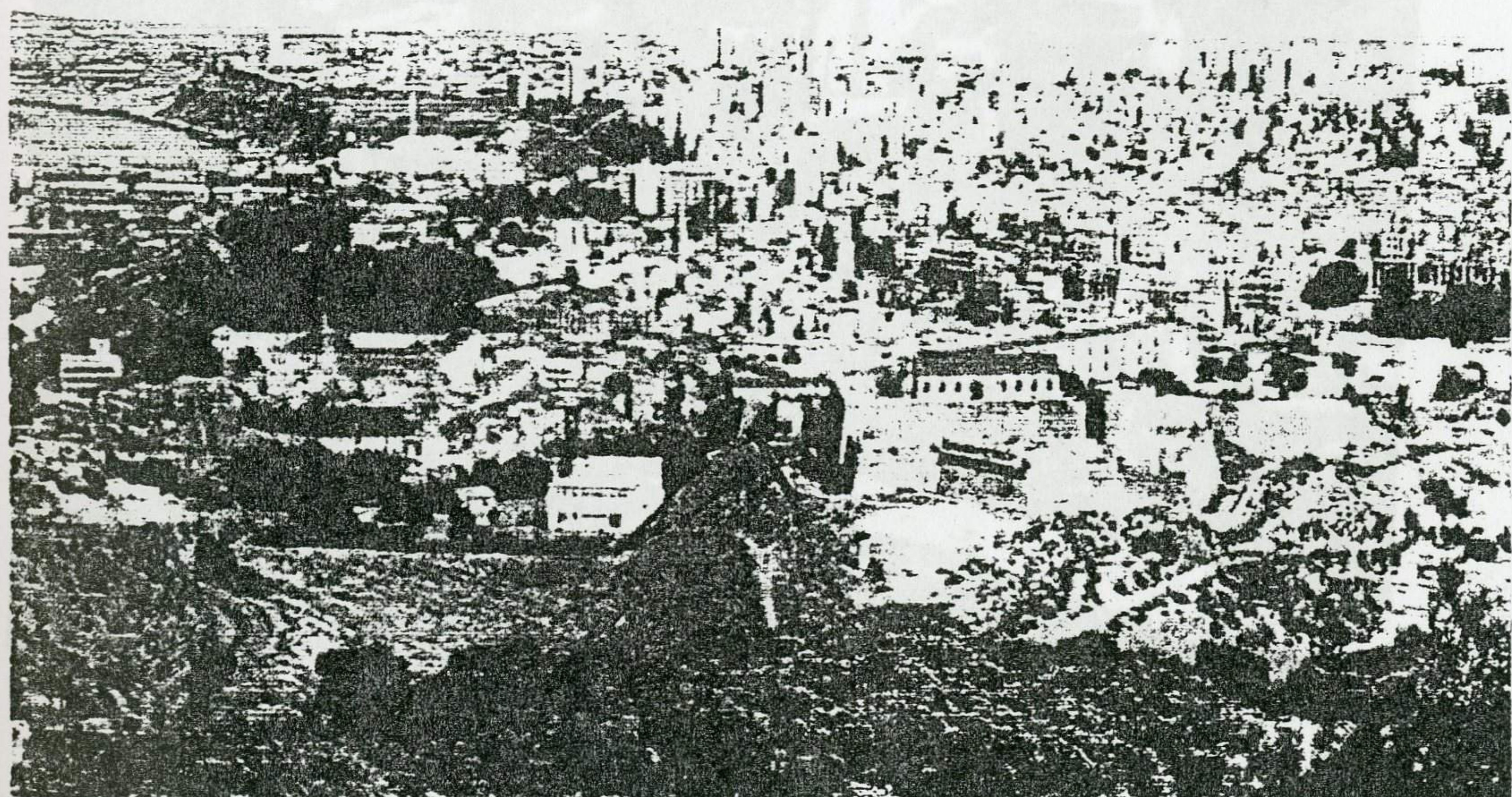
Photo 7. Le quartier sud de la citadelle
