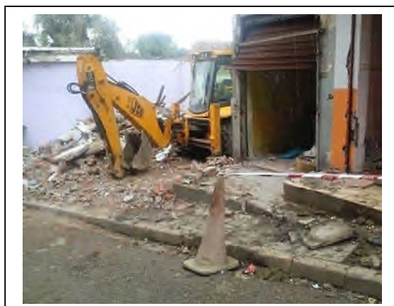
Chantier de démolition Belcourt. Alger
