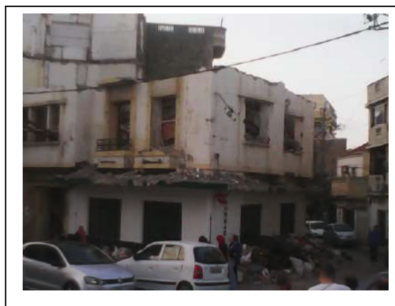
Chantier de démolition H. Dey.
