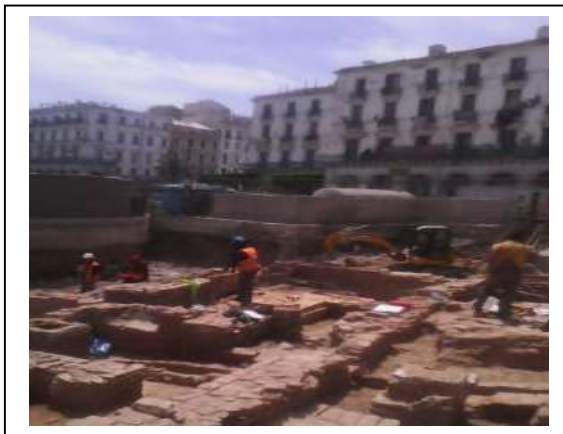
Figure III-5 : Travaux d'extension du métro D'Alger
