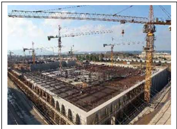
Figure III-6: Chantier en cours grande mosquée d'Alger
