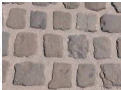
Figure V-4 : mortier utilisé en tant que joint pour la pose des pavés
