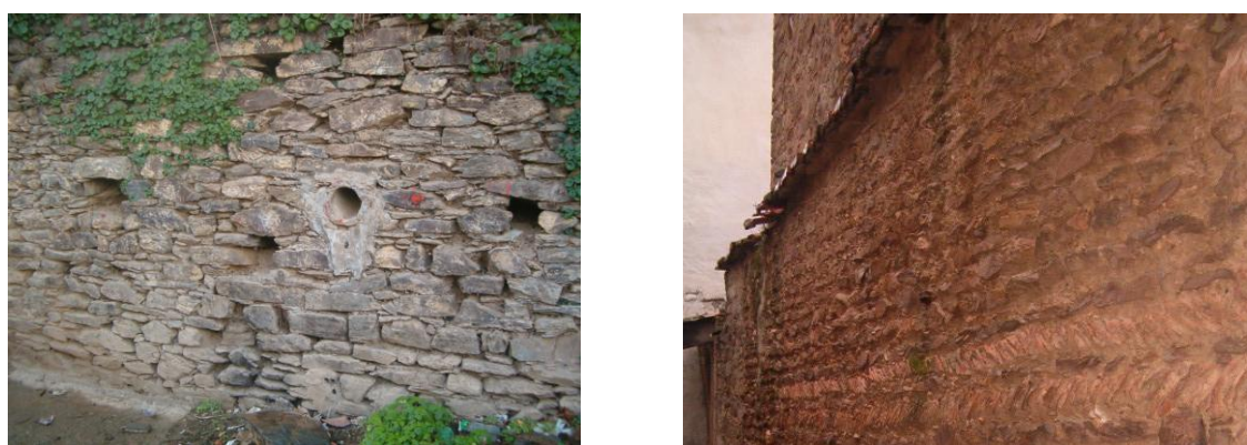
Figure IV. 21 : Images illustrant la diversité des matériaux utilisés et ce dans le même village Ath Abass (Daira Ouacif).
