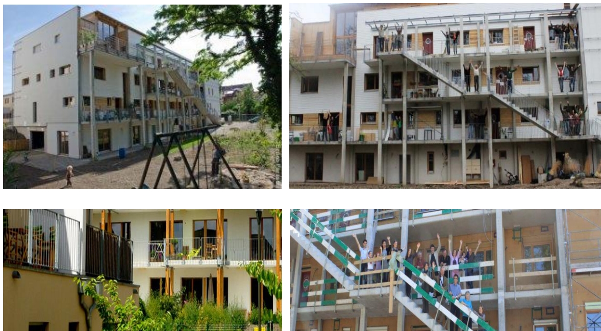
Figure 15: différentes phases de la construction de l'Eco-logis. Source: http://www.consoglobe.com/habitat-participatif-leco-logis-neudorf-strasbourg-cg/3
