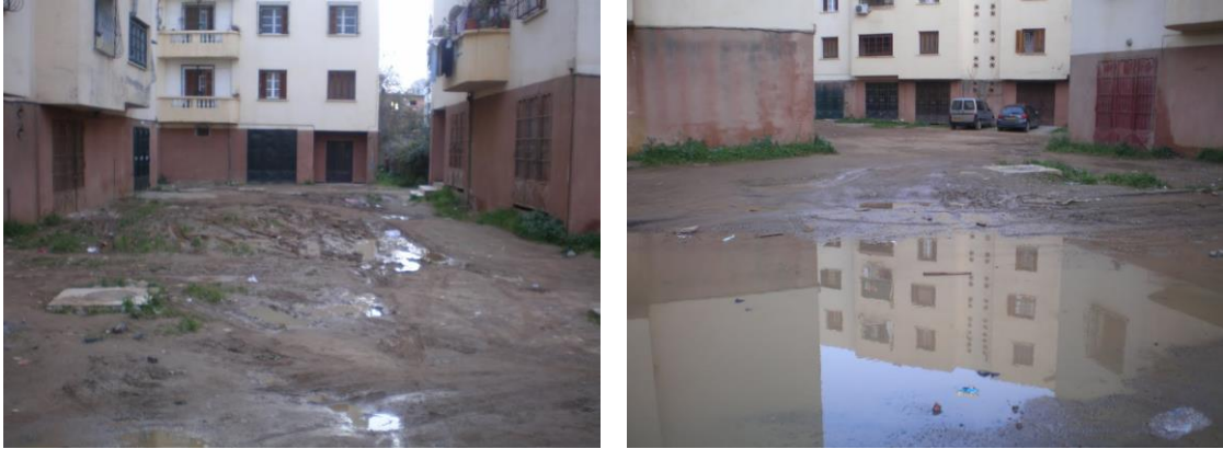
Figure 21: détérioration des espaces verts de la cité El Karam. 2012. Source : http://www.panoramio.com/photo/74090315
