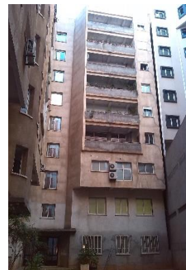
Figure 24: vue sur la façade intérieure de l'immeuble "Haut Hydra" depuis la cour. Source: photo prise par l'auteur, 19 mars 2016.
