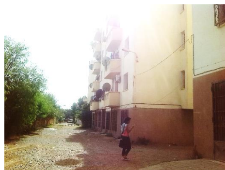
Figure 20: cité el Karam à Birtouta. Source: photo prise par l'auteur.
