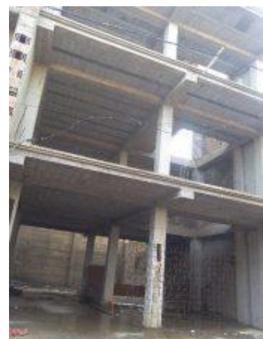
Figure 38: l'immeuble en cours de réalisation
