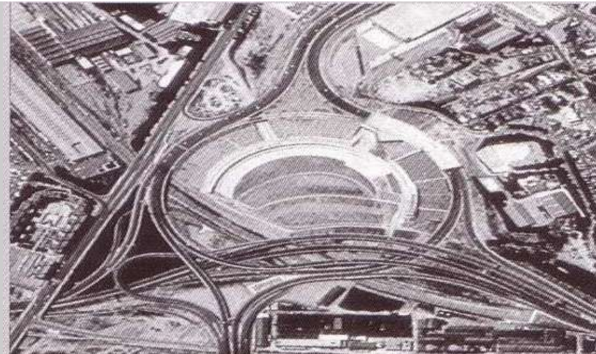
Figure 81: Carrefour de la Trinidad. Projet urbain qui tente de solutionner un problème de trafic tout en générant un espace public de qualité. C'est une intervention sur l'infrastructure qui se révèle comme un facteur d'intégration de la périphérie. Source : PU N°14 1997
