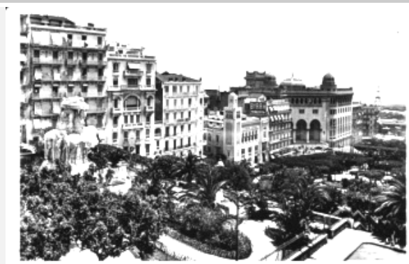
Figure 78: Alger, vue sur la Grande Poste. Source Google images
