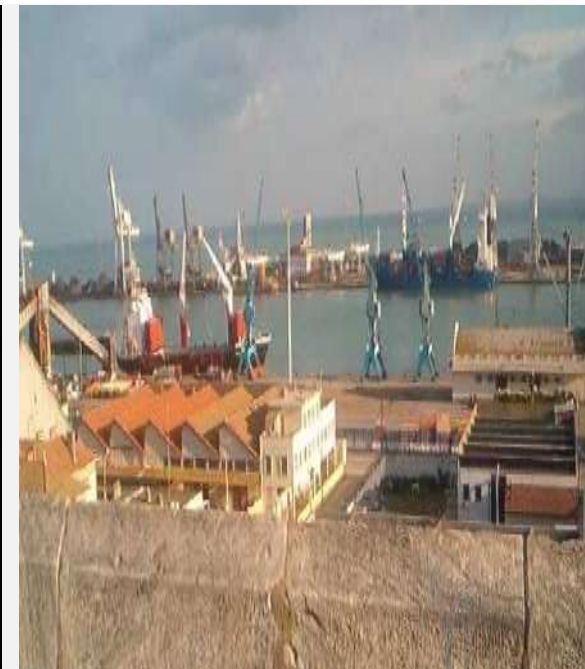
Figure 171: Le port de Annaba .Une importante infrastructure capable de répondre à de nouvelles demandes d'échanges. Source : SCU Annaba URBACO-EDR 2006
