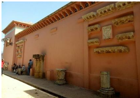
Figure 79. La Fermeture des baies de la façade Ouest Photo © Auteur.
