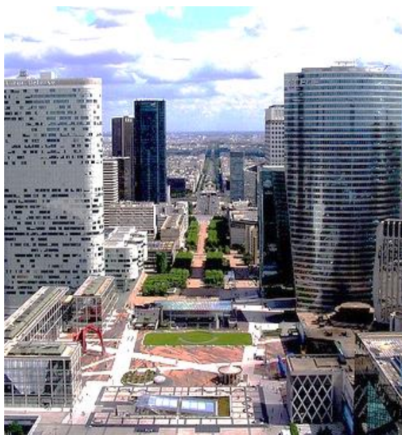
Figure 39. La place de la défense, Paris Photo© Pôle de production photographique et audiovisuelle de l'ambassade de France
