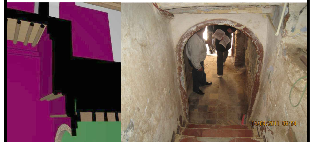
31 rue Benghanif :détail structurel .
