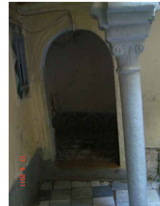
le chambranle du RDC.
