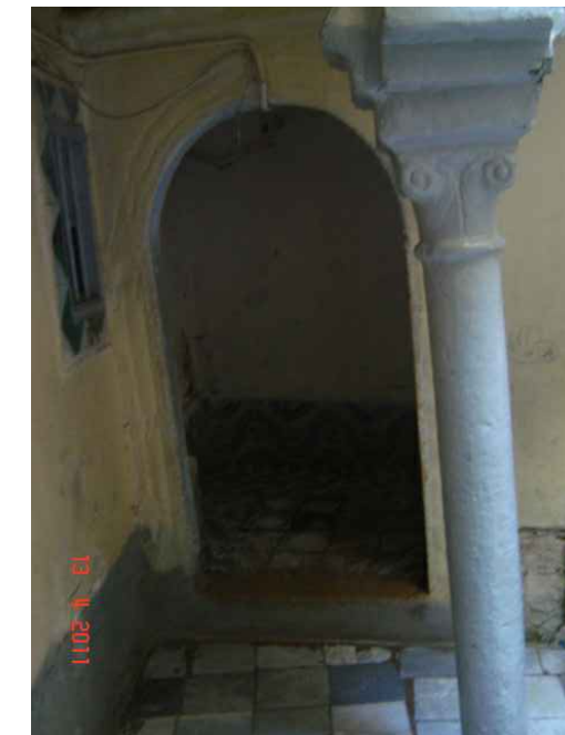
le chambranle du RDC.
