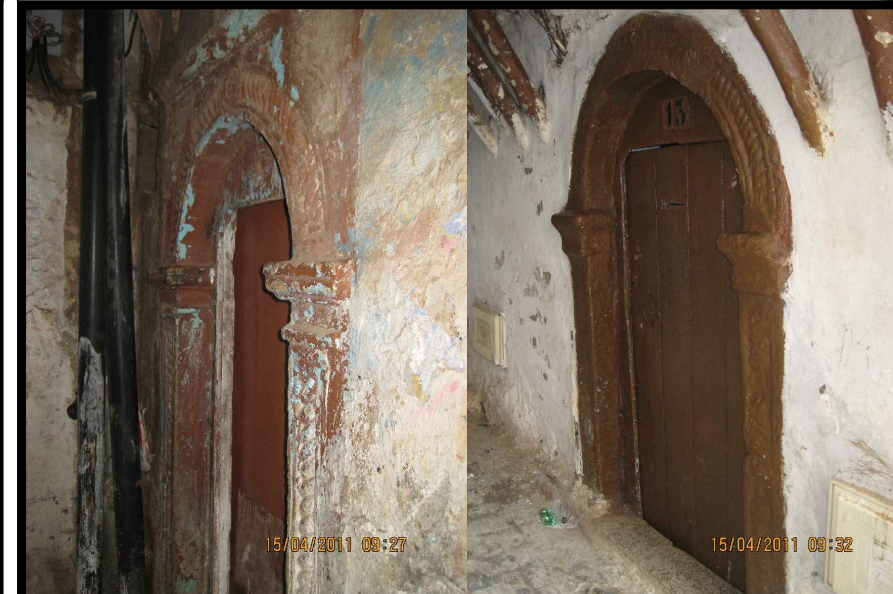
13 & 15 impasse des frères Belhimer. Façade Sud.
