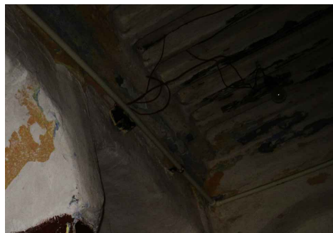
N° 31 rue Benghanif: les gorges en plâtre.
