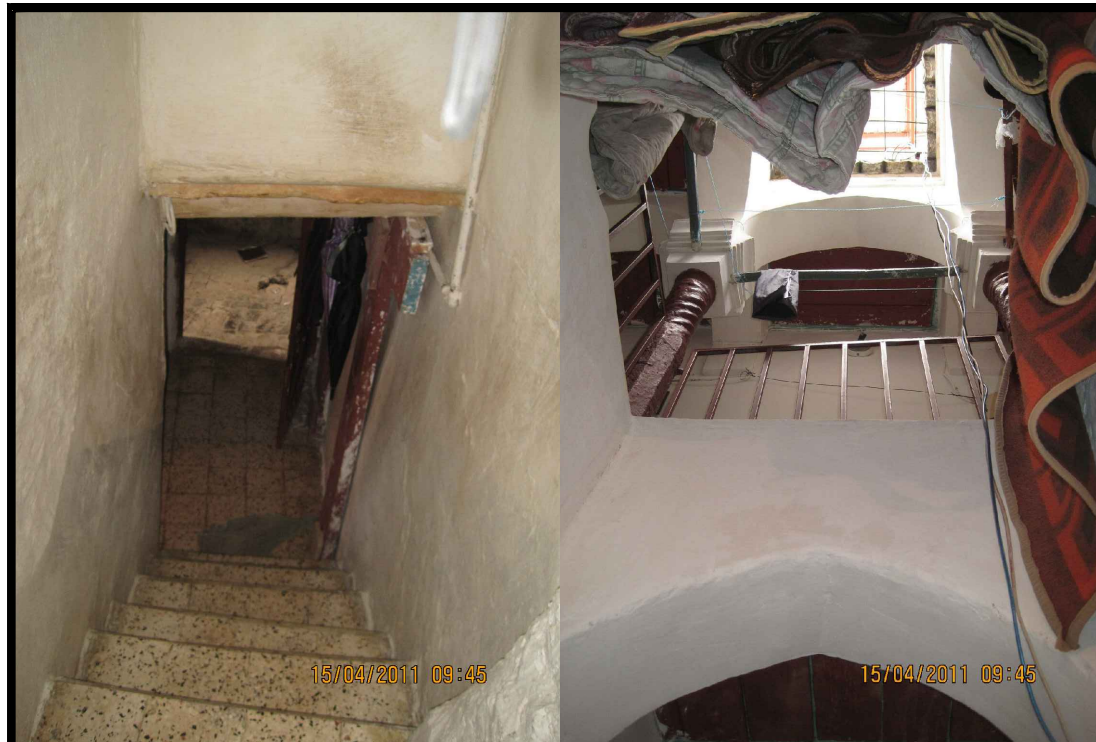
L'escalier de l'entrée.
