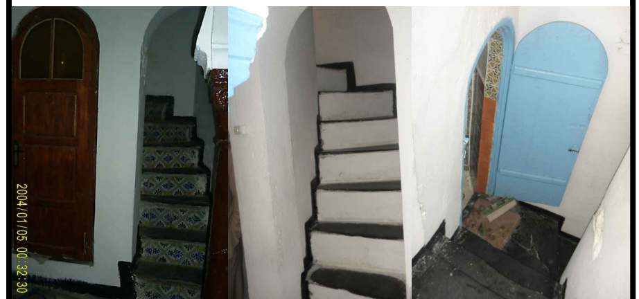
les revêtements de l'escalier.
