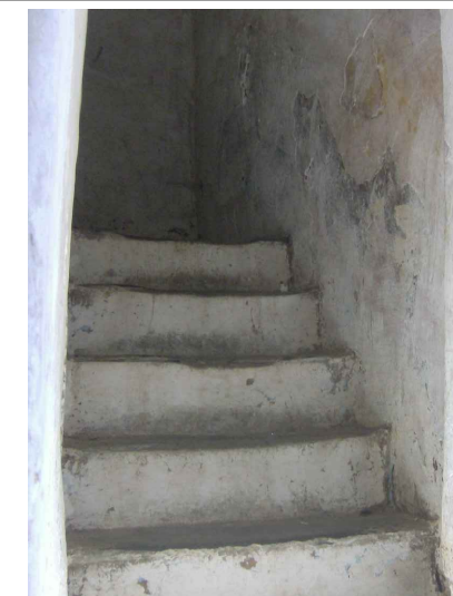
les revêtements de l'escalier.
