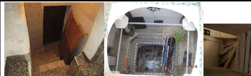
N°13& 15 impasse des frères Belhimer: les revêtement des marches.
