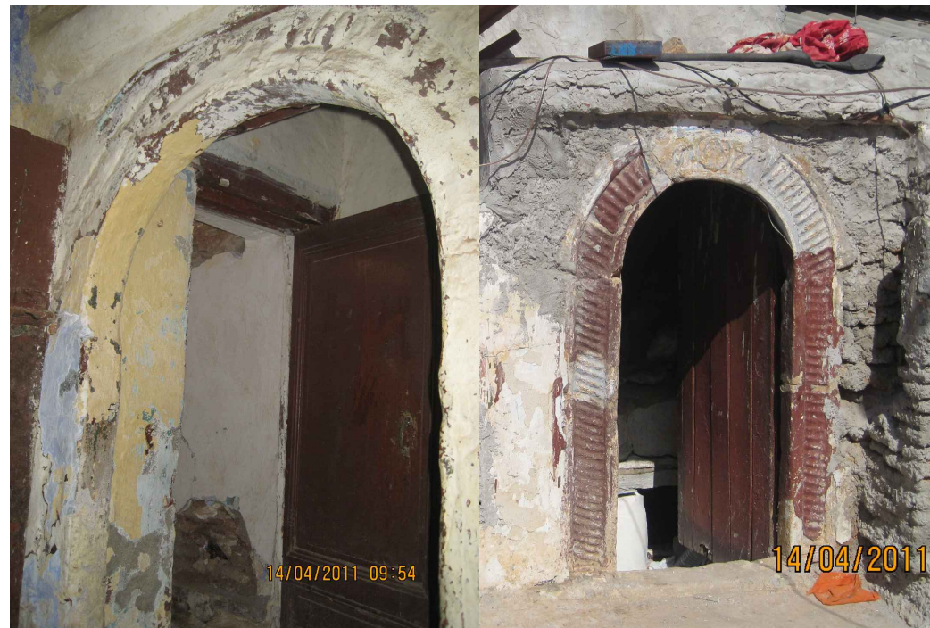
N°31 rue Benghanif: Chambranles en tuf
