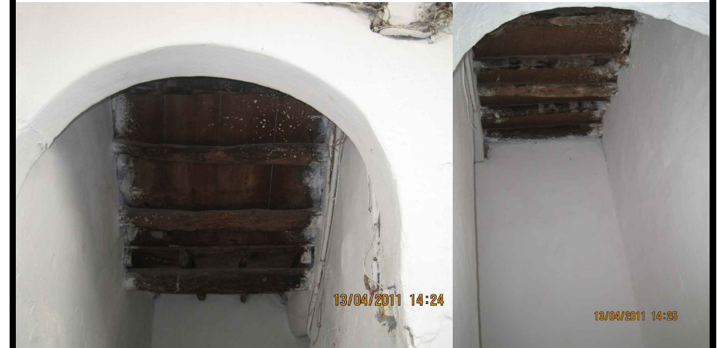
La structure du volume d'escalier.
