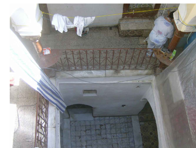
les revêtements de l'escalier.
