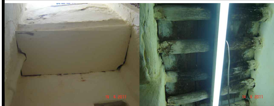
Vue sur le plancher du couloir . Vue sur le plancher rampant .
