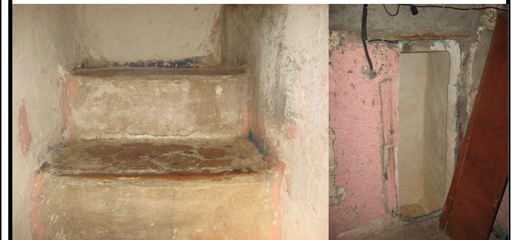
Vues sur le volume d'escalier de la N°33 Mohamed benghanif.
