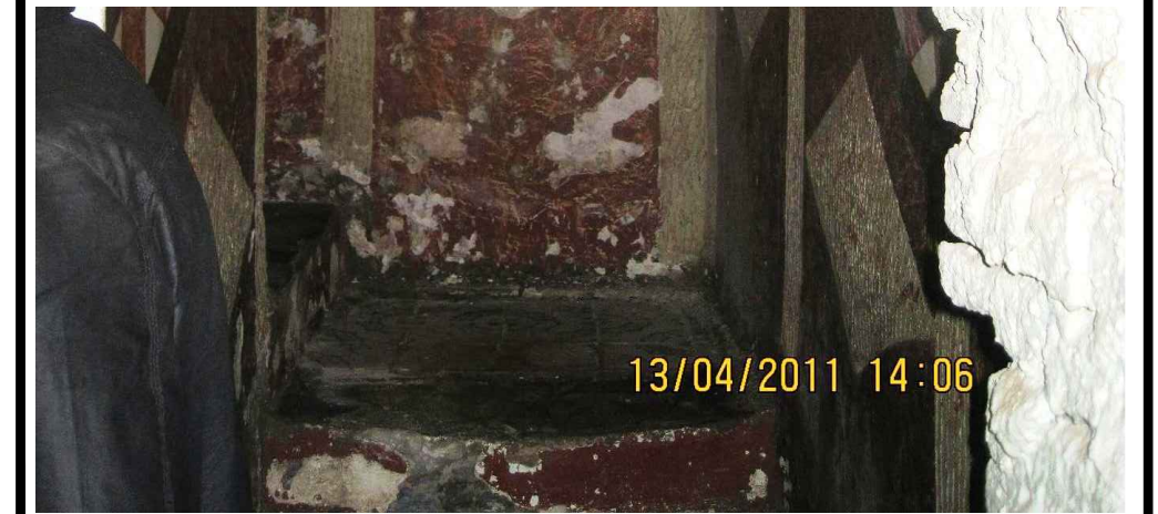
les carreaux des paliers de repos et les plaques en schistes des marches.
