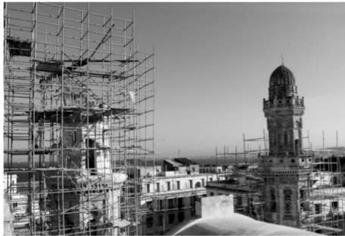
Figure 143 Tours jumelles encadrant l'entrée de la cathédrale Saint-Philippe [en cours de restauration en 2017] Source : A. Hadjilali
