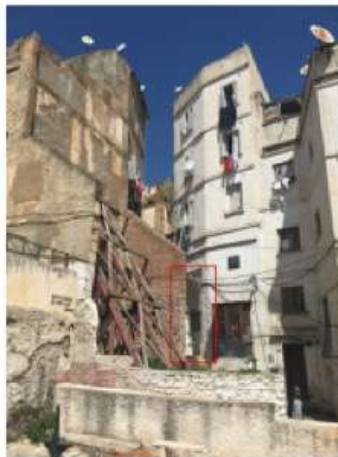
Figure 97 Immeuble de la fontaine de la rue de l'Intendance Source : photo. A. Hadjilal
