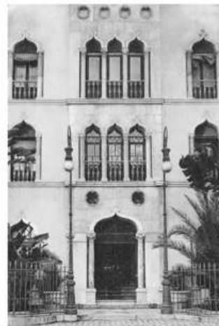
Figure 139 Travée centrale de la façade du palais de Hassan pacha d'après une carte postale ancienne Source : Collection particulière
