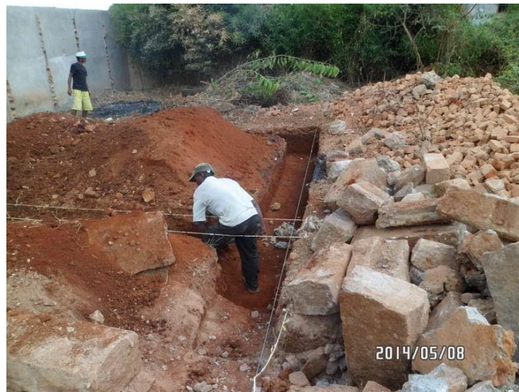
Figure 9 : Fondation en maçonnerie de remplissage
