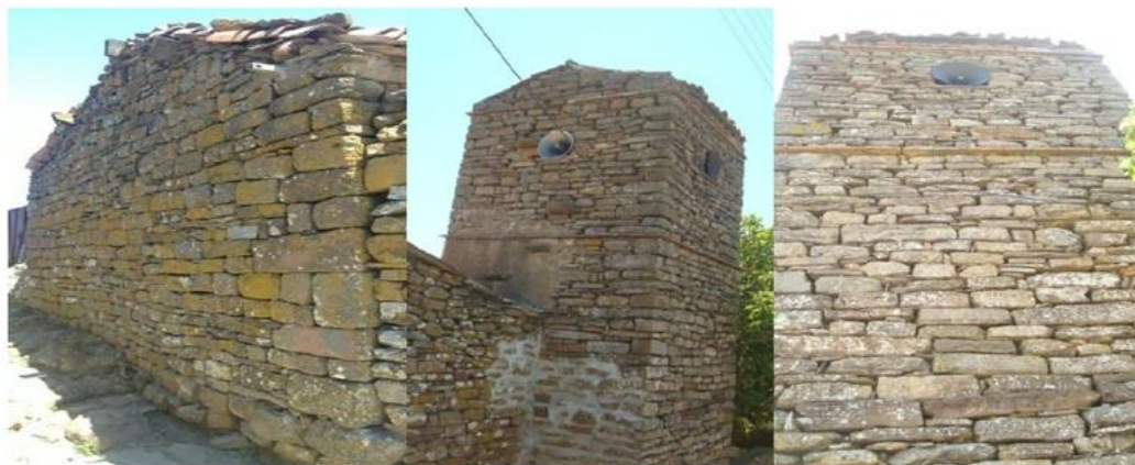
Figure 7: Mur en maçonnerie à sec, village ancien, AZZEFOUN (ALLILIS ; 2013)
