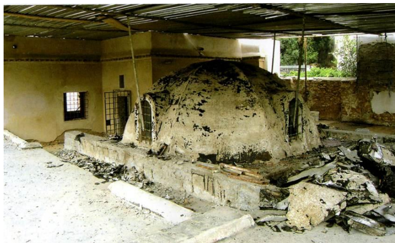
Figure 36- dépôt de l'étanchéité (HAMEG.A ; 2010)
