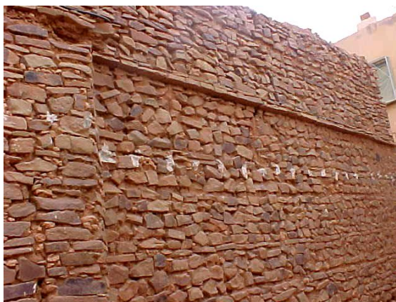
Figure 5 : Exemple de mur en pierraille
