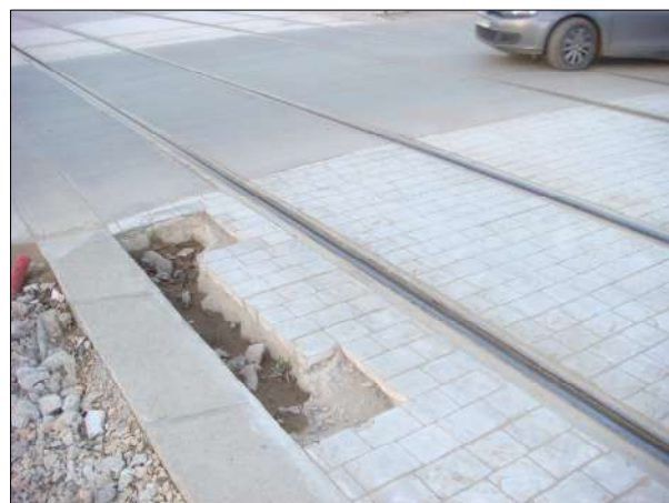
Revêtement de sol du tramway (Source : prise de vue par l'auteur).
