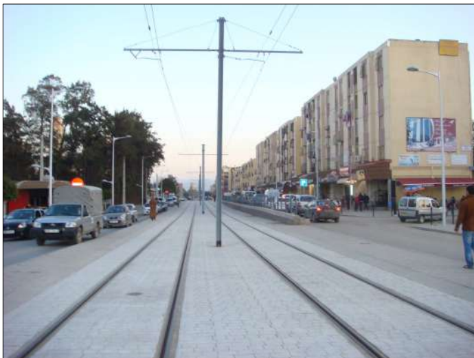
Boulevard El Jorf/ Bab Ezzouar (Source : prise de vue par l'auteur).
