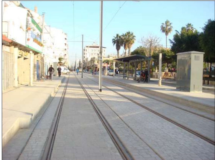
Place de la daïra /Rue Tripoli / Hussein Dey (Source : prise de vue par l'auteur).
