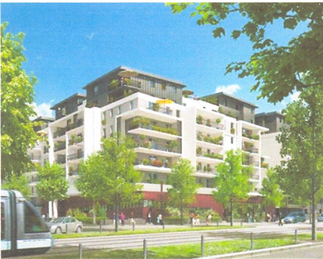
Fig. 38. : Façade Immeuble rénové à travers l'isolation des murs extérieurs. Francfort, Allemagne
