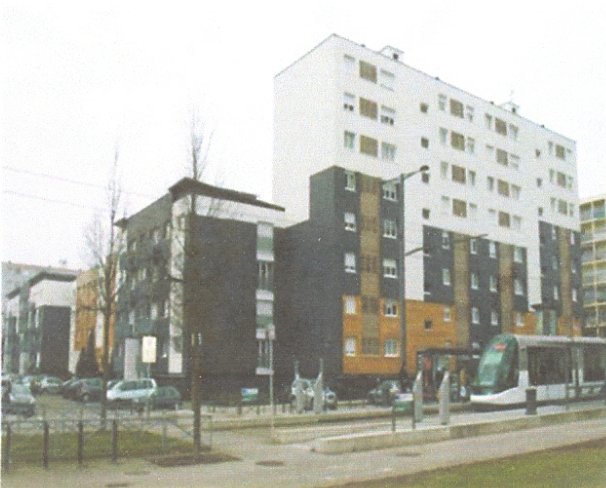
Fig. 39 : Façade Immeuble rénové à travers l'isolation extérieure des façades critiques. Strasbourg, France
