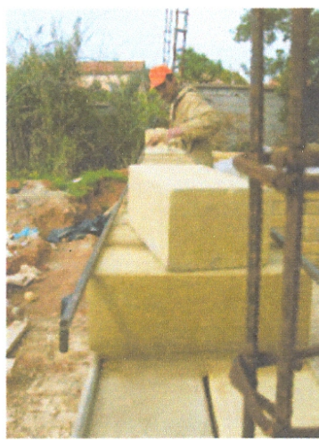
Fig. 11 et 12: Système de maçonnerie chaînée Mur en BTS
