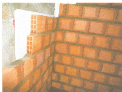
Figure 6 : Polystyrène dans la lame d'air
