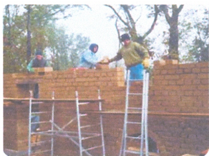
Figure 7 : Mur en Béton de terre stabilisée
