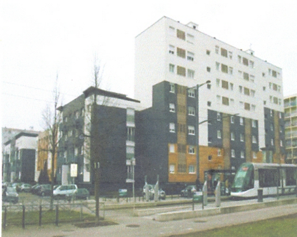
Fig. 39 : Façade Immeuble rénové à travers l'isolation extérieure des façades critiques. Strasbourg, France
