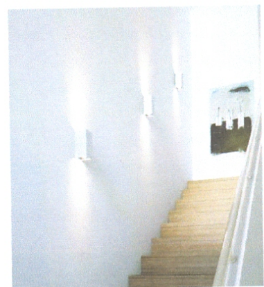
Fig.43 : Eclairage dans cage d'escalier
