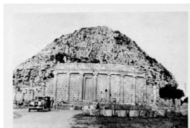
117 - Le trou est bouché. 1926.
