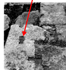
37 - Entaille à double queue d'aronde sur des pierres recouvertes en place. Planches des fondations brutes.
