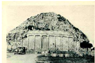
117 - Le trou est bouché. 1926.
