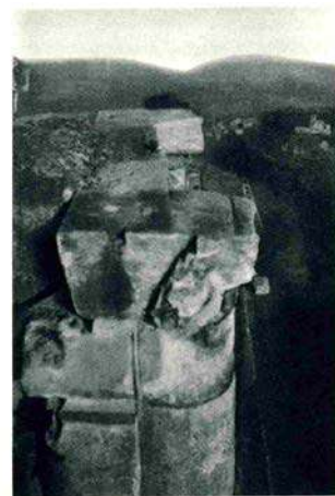
36 - Les 9 e et 10 e assises et le chapiteau de droite de la porte Est.
