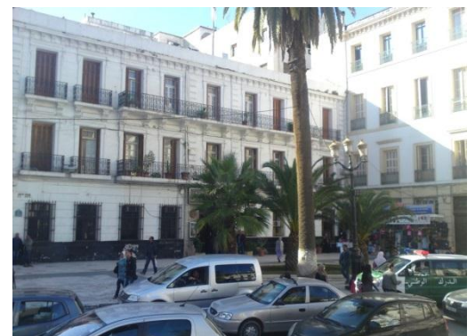
Figure 71 : APC d'Alger Centre. Source : Photo prise par l'auteur le 01/04/2015
