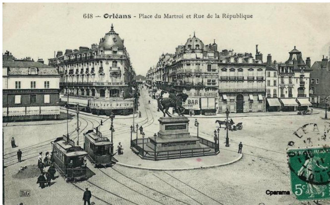
Figure 34 : La ligne du tramway traversant la place du Martroi.
