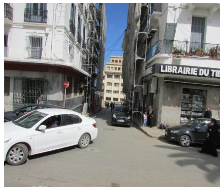
Figure 76 : Percée bloquée de la place de l'Emir Abdelkader vers la mer.
