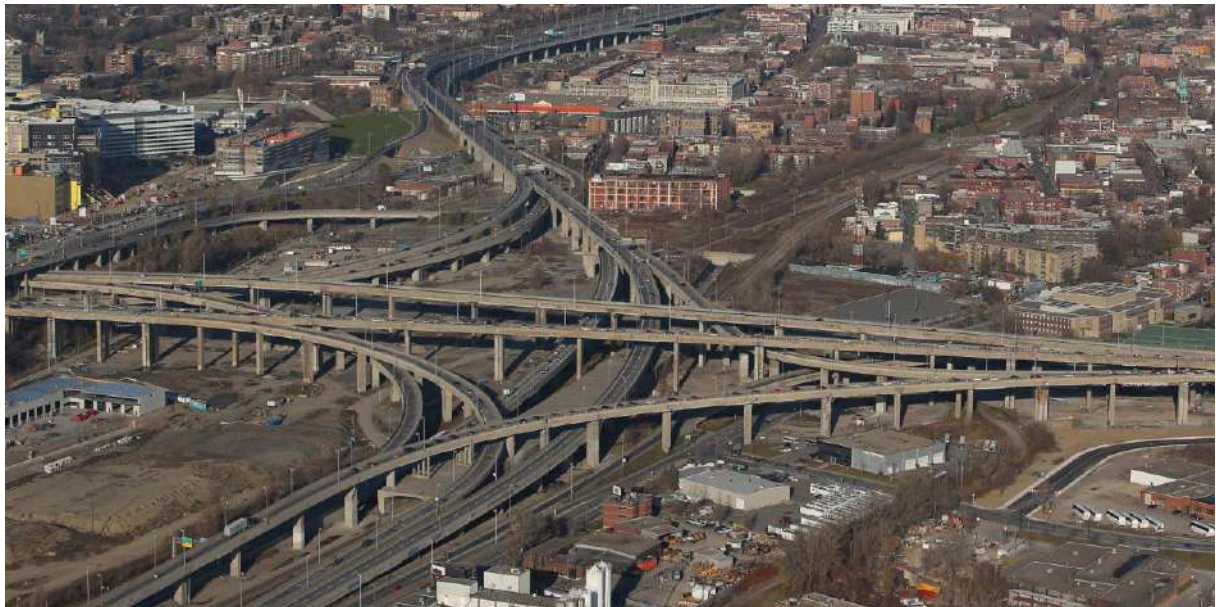
Figure 6: Vue aérienne sur l'échangeur Turcot, dans la banlieue sud-ouest de Montréal, au Canada (open source)
