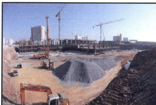
Figure. B. Le chantier du CCL de BABEZZOUAR
