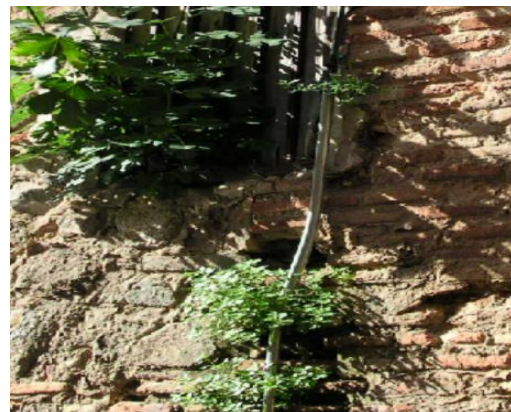
Figure 13 Présence de plantes (le figuier) dans un mur Source : ACHAB Samia
