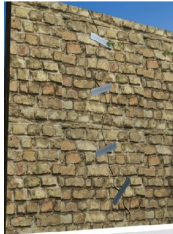
Figure 33 renforcement par épingle ancré dans le mur
