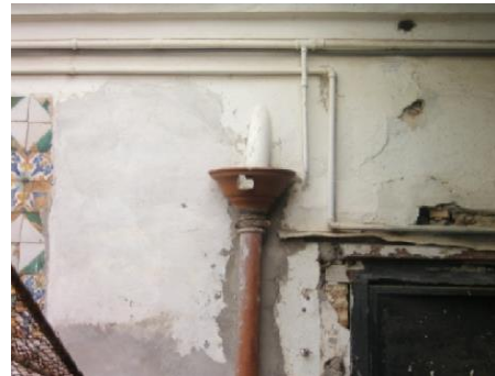
Figure 16 Réfection de l'enduit à base de mortier de ciment Source : auteur
