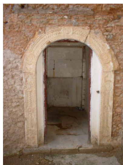
Figure 48 Vue sur un mur Source :OGEBEC
