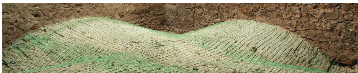
Figure 70 renforcement de la voûte en chape armée
