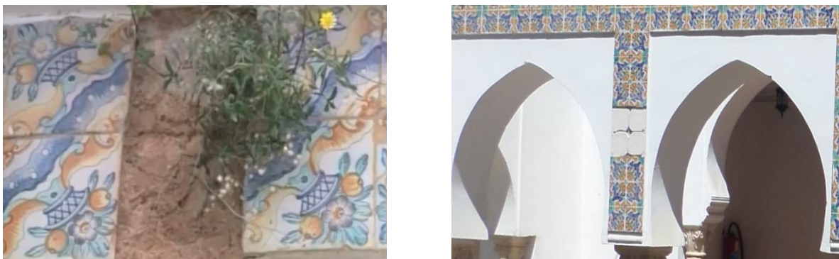
Figure 66 apparition des algues et dislocation des pièces de faïence Source : auteur
