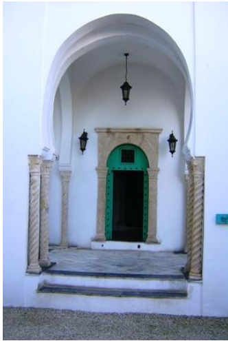
Figure 40 porche d'entrée Source : auteur
