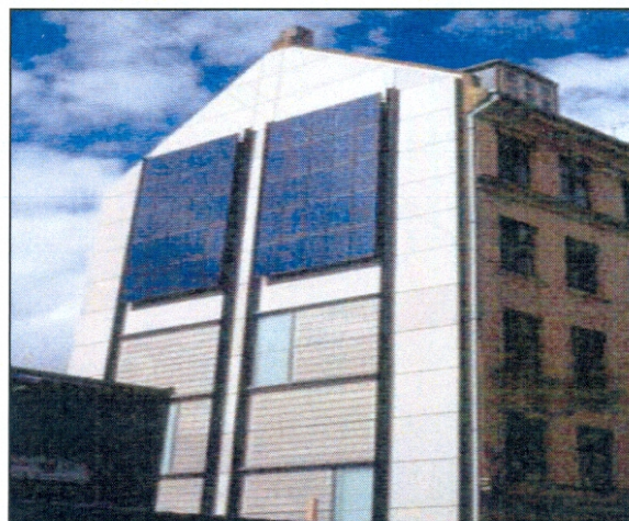
Figure 28 : façade avec panneaux
