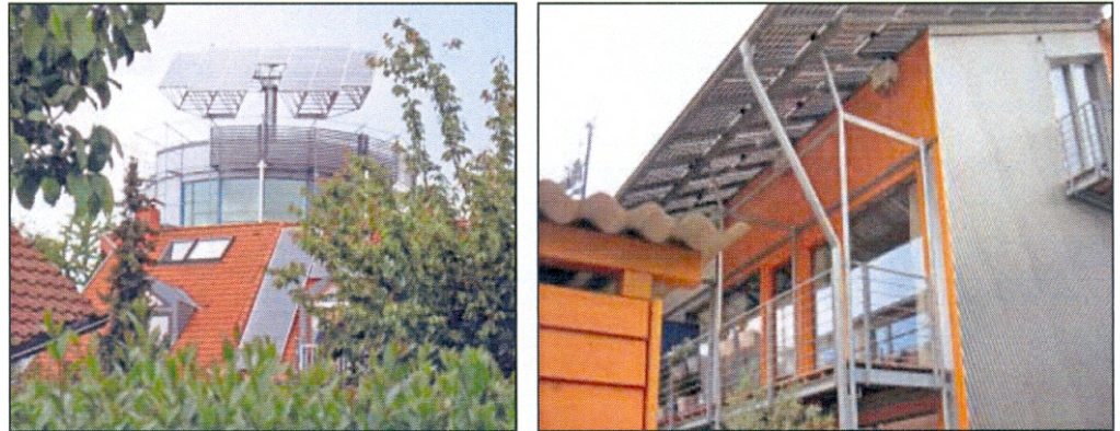
Figure 08 : l'installation des panneaux photovoltaïques et solaires dans tout le quartier
