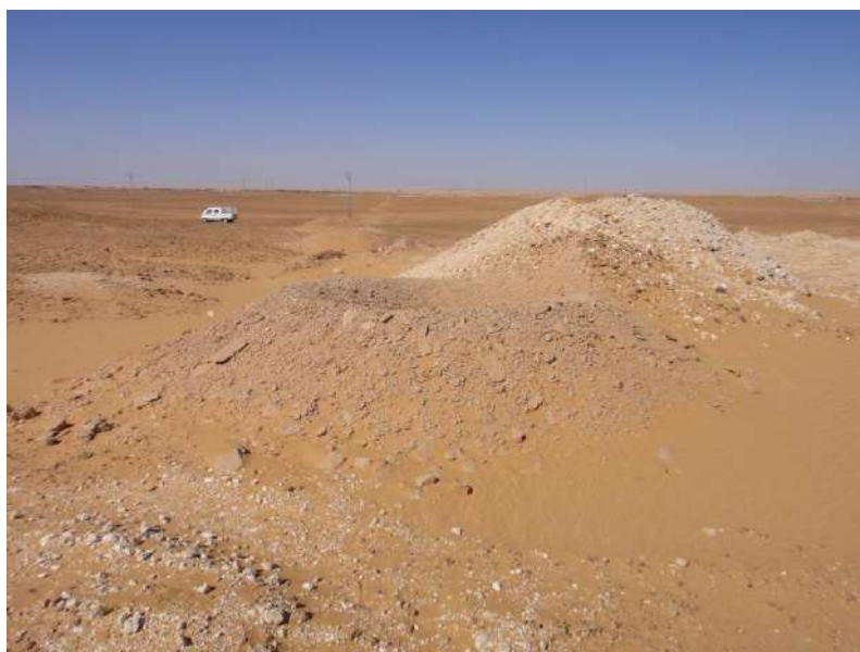
Fig. 63 _ Dernier puits amont de la foggara Amekane envahi par le remblai
