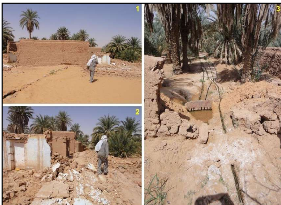
Fig. 81 _ Effondrement d'une maison par l'effet de la libération de l'eau d'une foggara obstruée à Guesbat-El-Kef au Nord de Timimoun. Le canal qui passe par la maison (1) a détruit le mur latéral droit (2) et couvert la séguia et la kesria (3). Photos prise en mars 2014.
