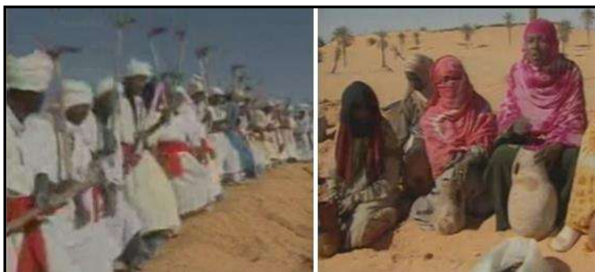
Fig. 44 _ Une Touiza de foggara au Touat, une rangée d'hommes déblayant le sable et un groupe de femmes attendant pour aller humidifier le déblai. Source : Hadj Labbadi, Timimoun.
