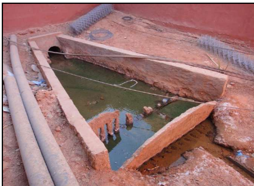
Fig. 76 _ Les parois latérales sont construites sur les limites de l'ancien bassin. L'ancien peigne est doublé d'un nouveau. L'eau est dirigée vers une seule séguia qui irrigue les jardins Ath-Amrane. Photo novembre 2014.
