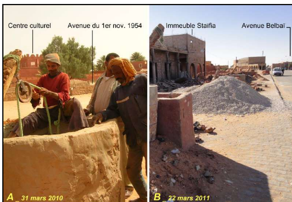
Fig. 69 _ Travaux de curage de la foggara Amekane. En mars 2010 en contrebas de la grande Avenue (A) où un travailleur fait monter le remblai sous l'œil attentif du khabir Hadj Mohamed Boullel. En mars 2011, les travaux parviennent à la moitié de l'avenue Belbaï (B).
