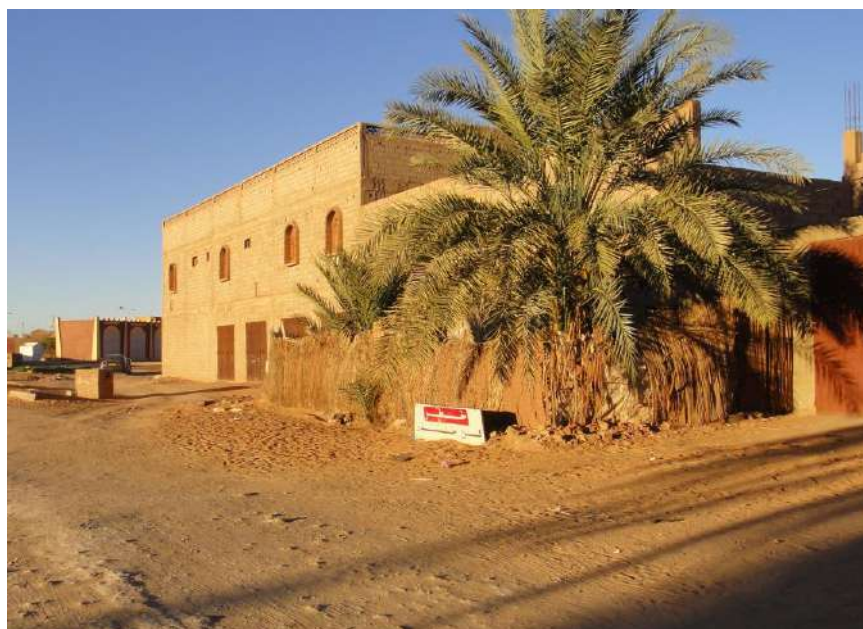
Fig. 74 _ Cité Benhammadi à Timimoun, la plaque posée sur le sol indique le « danger » que représente désormais la foggara Amekane pour la maison. Photo prise le 06/02/2014.
