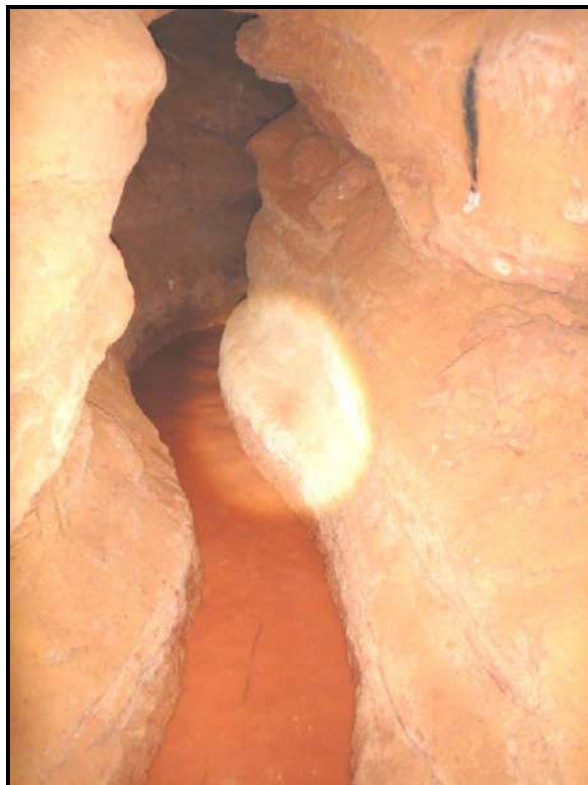
Fig. 35. Dans la galerie de la foggara Amekane en mars 2014. L'aspect sinueux de la galerie dans les premières centaines de mètres n'est pas reflété par la rectitude du tracé suggéré par les puits à la surface.
