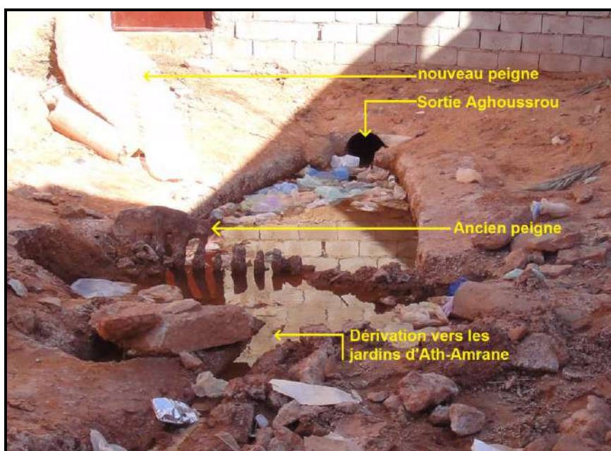
Fig. 70 _ La grande Kesria Amekane en mars 2011. Depuis plus de six mois, l'eau coule à nouveau bien que lentement. La clôture est réalisée à moitié
