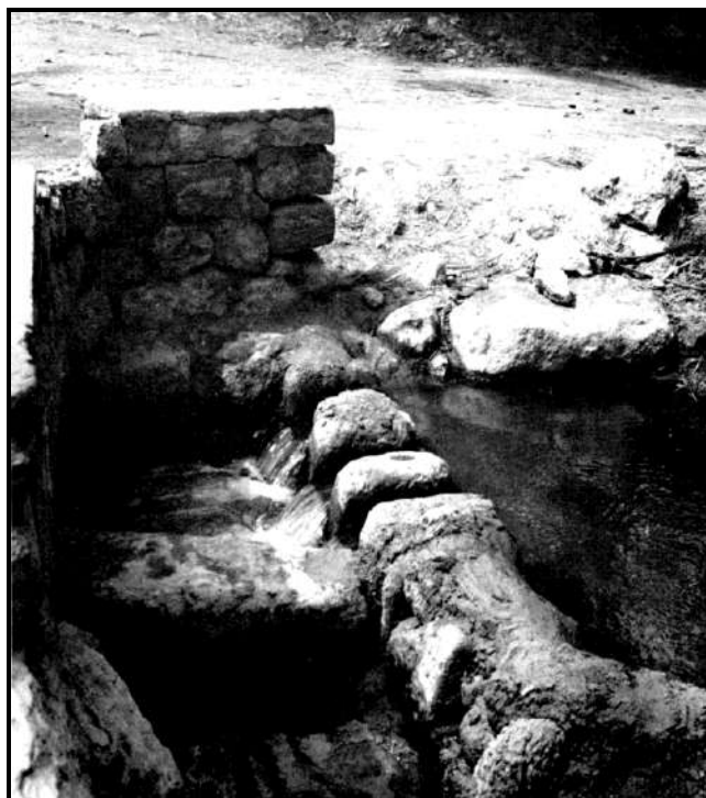
Fig. 75 _ Kesria antique distribuant l'eau par volume dans l'oasis de Kriz (Tunisie). Source : (Trousset 1986 : 171).
