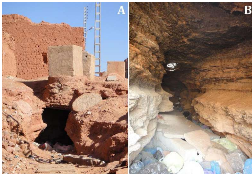
Fig. 64 _ La fin de la galerie Amekane (A) : au droit du dernier puits et de l'escarpement rocheux d'une dénivellée de 3 m. (B) : l'intérieur de la galerie est une petite grotte dont apparaît au fond la lumière du troisième puits. En bas apparaît le début du canal en ciment et couvert de dallages en béton réalisé sur une longueur de 75 m pour protéger l'écoulement. Photos prises en mars 2011 (A) et mars 2012 (B).
