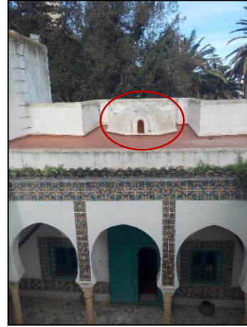
Figure 3.33 : La coupole d'un Ḳbou dans la villa Abdeltif . (Source : auteure, 2016.)
