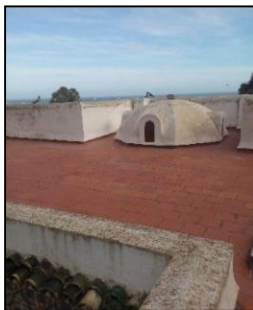
Figure 3.63: La coupole du Kbou dans la villa Abdeltif . (Source : auteure, 2016.)
