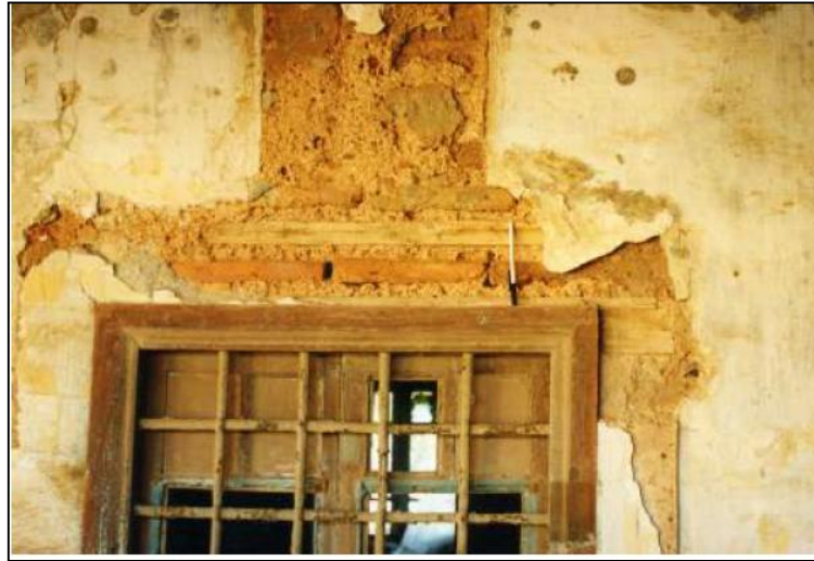
Figure 3.52 : Renforcement des ouvertures avec du bois (palais du Dey). (Source : Revue « vie de ville », n°5)
