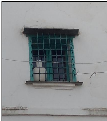
Figure 3.76 : Fenêtre grillagée, Dar Abdeltif . (Source : auteure, 2016.)
