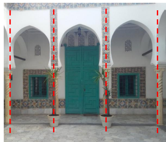
Figure 4.27 : La façade intérieure de la galerie de Dar Abdeltif . (Source : auteure, 2016)
