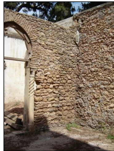
Figure 3.47: Mur en pierre dans Djnen Abdeltif . (Source : DRIOUECHE-DJAALALI.N.K, 2004.)
