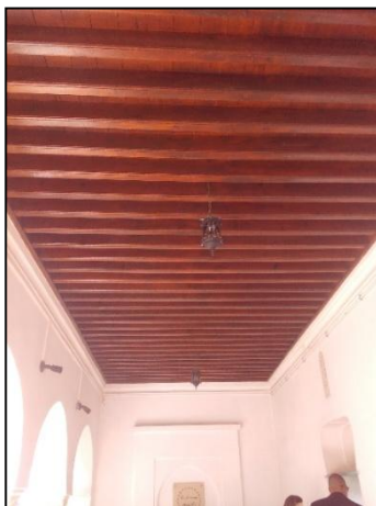
Figure 3.75: Le plancher en bois, Dar Abdeltif . (Source : auteure, 2016.)
