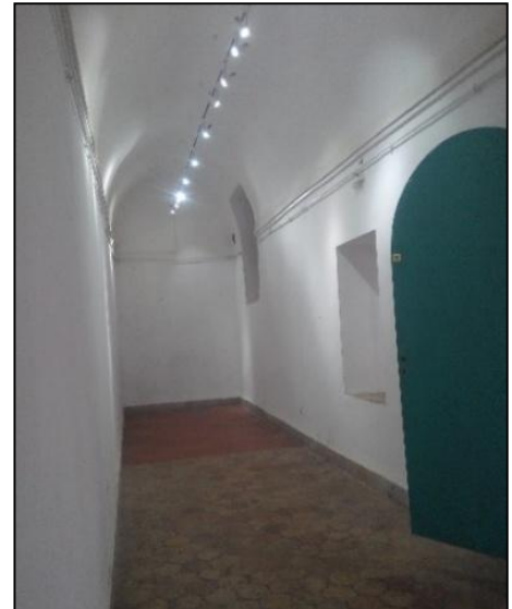
Figure 3.59 : La voûte en berceau de la Skifa de Dar Abdeltif . (Source : Auteure, 2016.)
