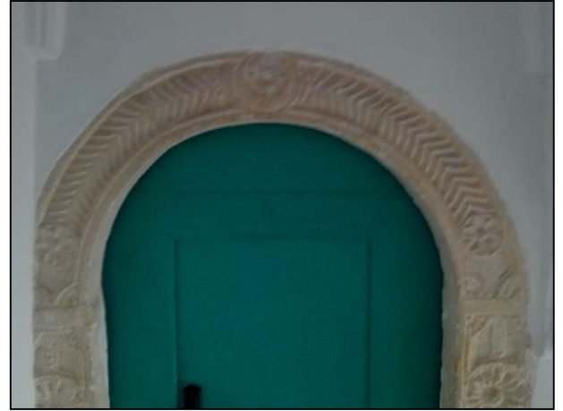
Figure 3.74: Les chambranles de portes, cadre en tuf en arc en plein cintre. (Source : Auteure, 2016.)
