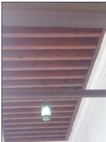
Figure 3.28 : Le système de couverture des galeries de Dar Abdeltif . (Source : auteure, 2016.)
