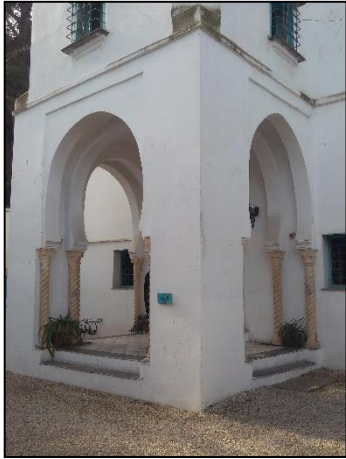
Figure 3.19: Le porche de la villa Abdeltif Source : auteure, 2016.
