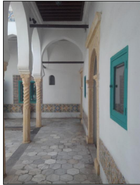
Figure 2.56 : Les arcs de contreventement dans le croisement des galeries de Dar Abdeltif . (Source : Auteure, 2016.)
