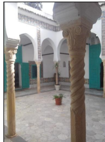
Figure 3. 68 : Les colonnes de la villa Abdeltif . (Source : Auteure, 2016.)
