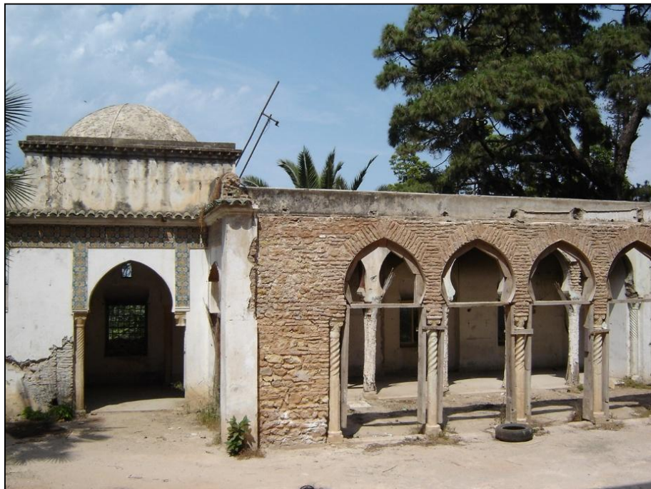
Figure 3.51 : Mur en brique cuite, Kubbah de Djnen Abdeltif . (Source : DRIOUECHE-DJAALALI.N.K, 2004.)
