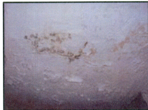
Fig.18 : problèmes d'étanchéité
