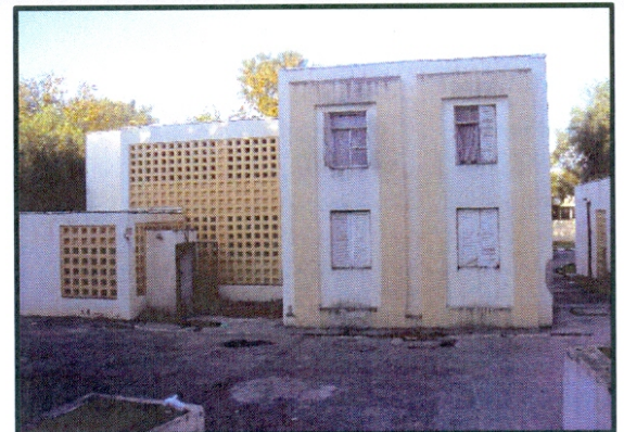
Fig.6 : façade d'un pavillon
