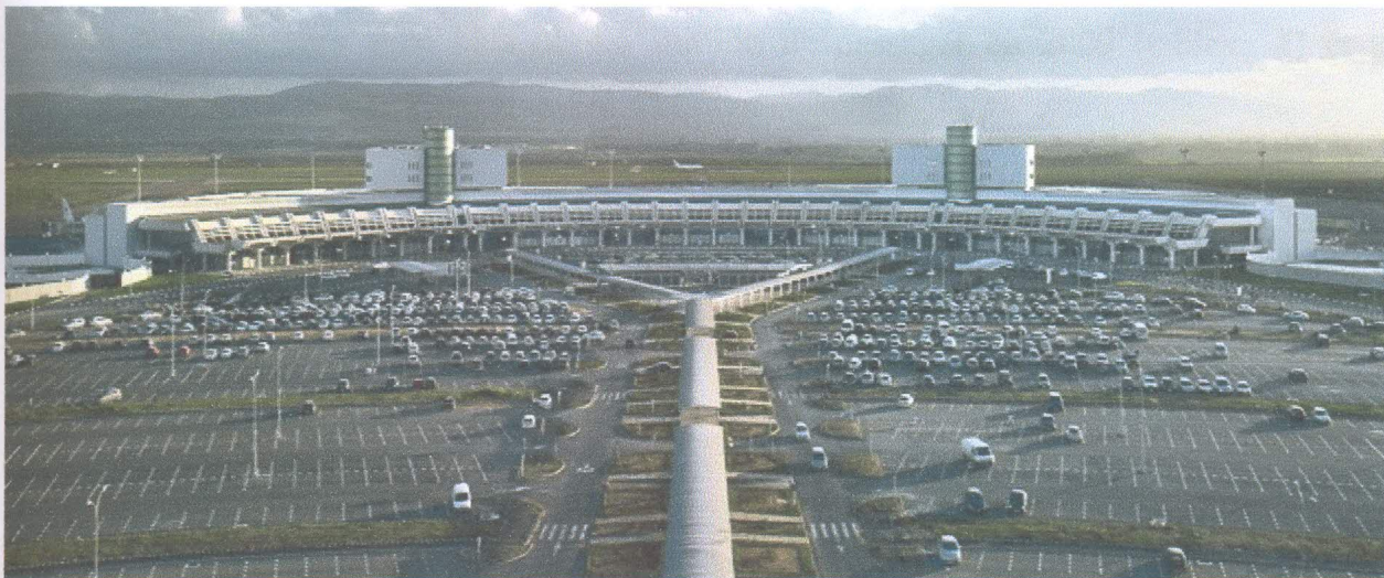
Figure 16 : Aéroport d'Alger (terminal 1). (Source : Google images, 2012).
