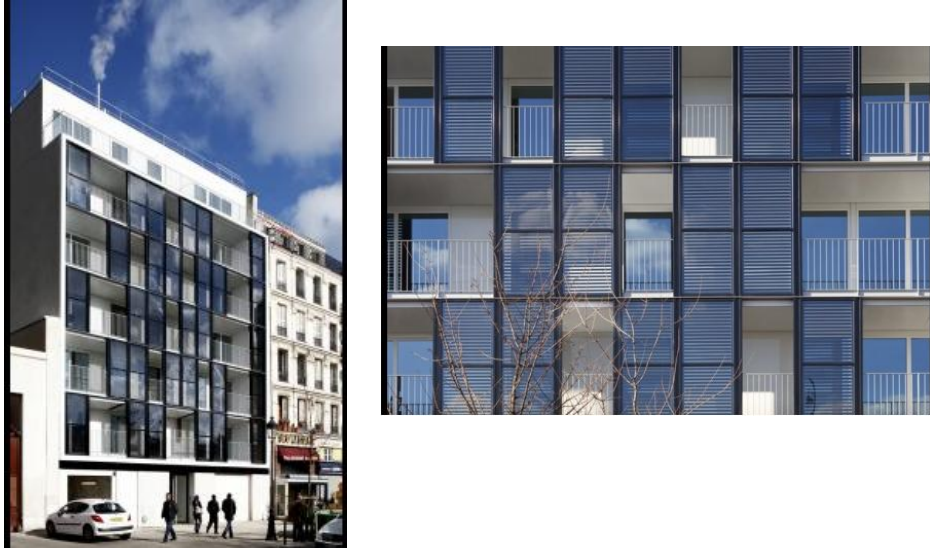
Figure (25): Installation des capteurs solaire sur façade
