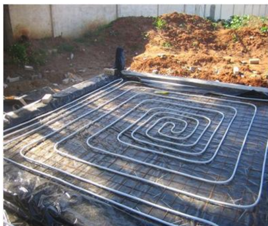
Figure(37) : Pose du serpentin (chambre 1)
