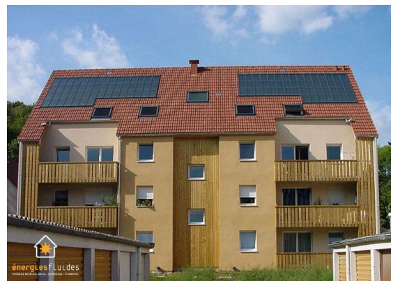
Figure (23): Installation du capteur sur une toiture inclinée respectant l'axe de la fenêtre ( source: solaire thermique: chauffage et chauffe eau, consulté le 23 aout 2015, http://www.energiesfluides.fr/Solaire-thermique.html )
