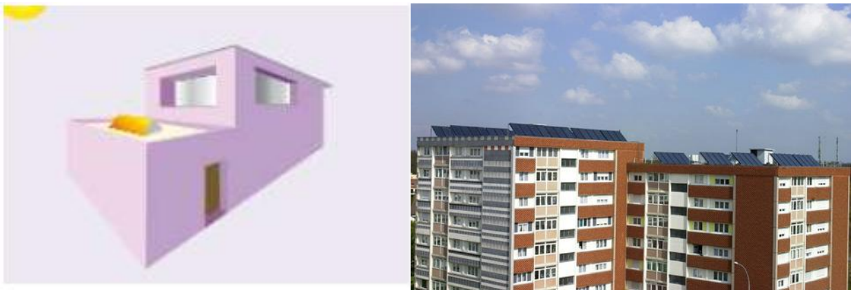
Figure (24): Installation des capteurs solaires sur une toiture terrasse Solaire thermique dans le collectif. ( source: un exemple à suivre, publié le 19 février 2015,consulté le 23 aout 2015, http://conseils.xpair.com/actualite_experts/solaire_thermique-collectif-strasbourg.htm )
