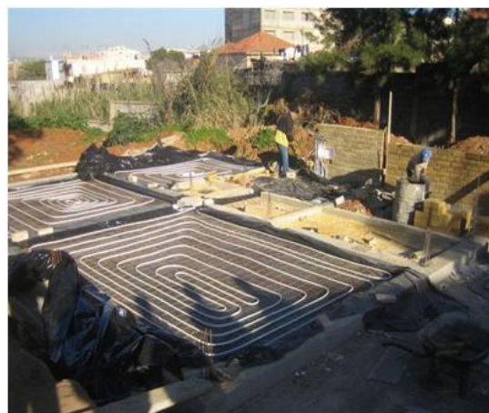
Figure (38): Pose du serpentin sur l'ensemble de la maison
