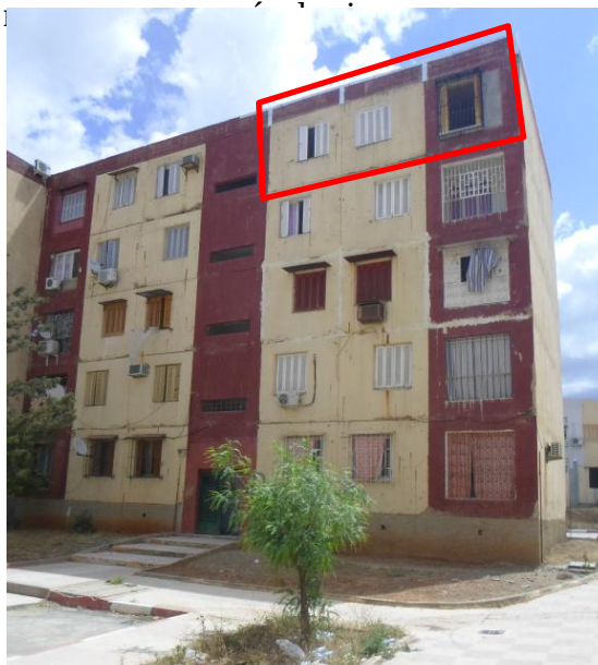
Figure (42): L'aspect extérieur de l'immeuble (source : photo prise par l'auteur)
