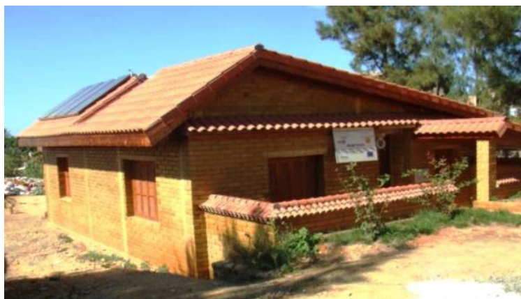
Figure (34): Vue du côté Sud-est de la maison prototype étudiée
