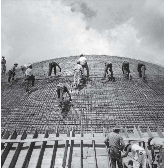
Vu du chantier de la coupole du complexe sportif du 5 juillet.
