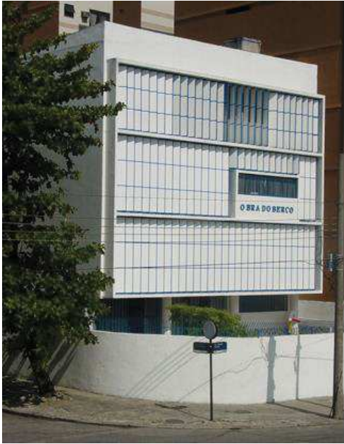
Figure 34: Pilotis de l'Obra do Berço (1937-1940)
