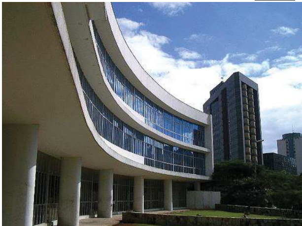
Figure 36: Pilotis de la bibliothèque de Belo Horizonte 1955
