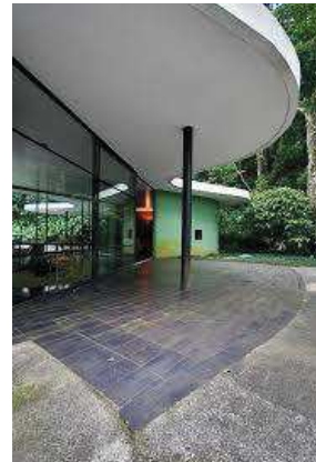
Figure 37: Pilotis la maison de l'architecte à Canoas (1953-1954)
