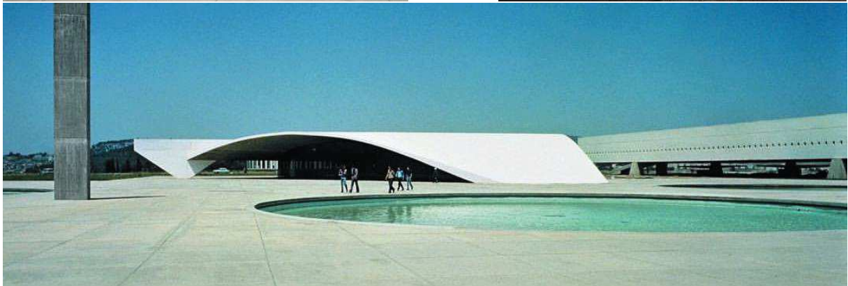
Figure 92 : terminaison de l'arc et son intersection avec le sol
