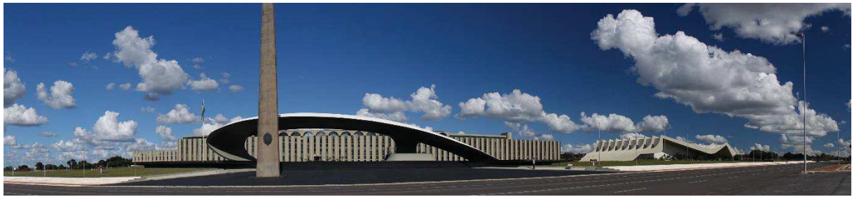
Figure 30: Couverture des tribunes érigées sur l'esplanade du ministère des Armées à Brasilia (1968-1972)
