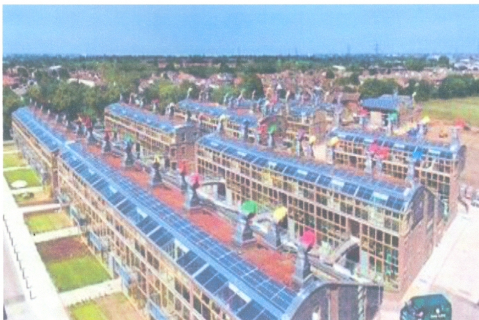
Fig.8: L'écoquartier BedZed (Sutton), Source : www.ademe_eco_quartier.fr ,
