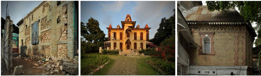
Fig. 3 : Exemple de constructions en maçonnerie qui ne se sont pas effondrées suite au séisme destructeur de Haïti en 2010 [Langenbach R., 2010B].
