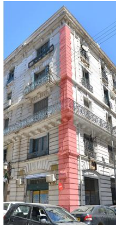
Fig. 51 : Marquage de la tripartite horizontale grâce au refend d'angle. (Crédit photo : Bekkal M.)
