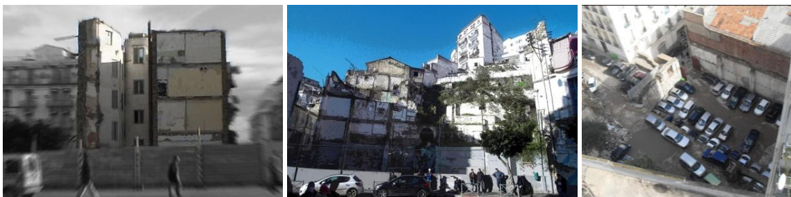
Fig. 2 : Dégradation du bâti (crédit photo : Guerba M. & Tedjini Bailiche W., Abrous N., Benmenni F.).
