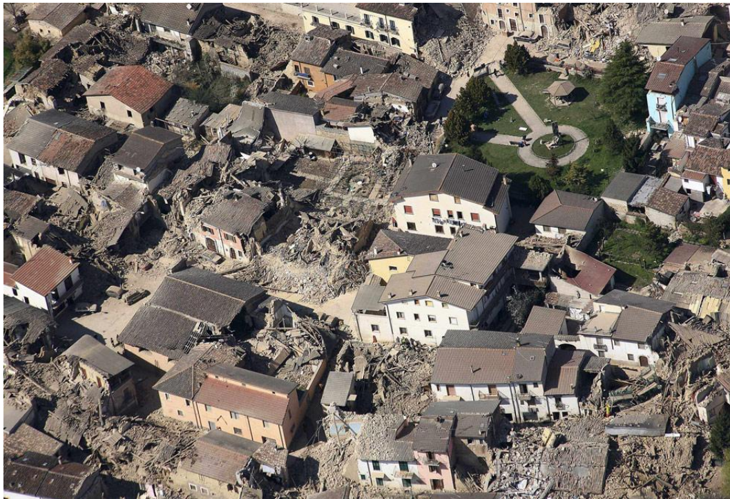
Fig. 4 : Séisme de 2009 à l'Aquila en Italie, les bâtiments de même typologie constructive et architecturale se trouvant au même endroit ont réagi de manière différente face à la secousse 11 .
