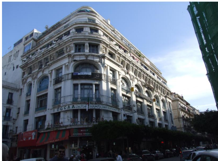
Fig. 63 : les hauteurs d'étage de l'immeuble Milk bar, se réduisent du bas vers le haut. (Crédit photo : Souami M.A.)
