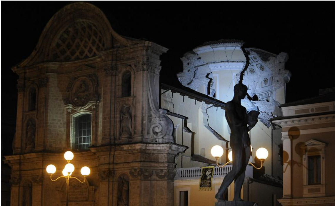
Fig. 12 : Séisme de 2009 à l'Aquila en Italie, l'église St. Maria Del Suffragio n'a subi des dommages qu'au niveau de la coupole. Les façades en maçonnerie sont restées quasiment intactes 30 .
