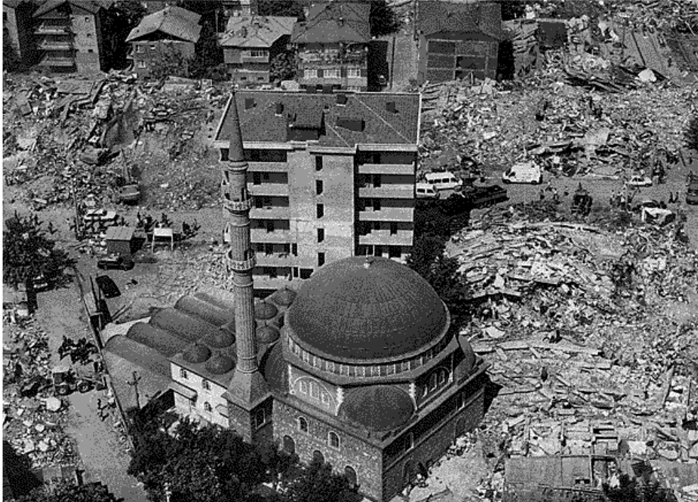
Fig. 10 : Bon comportement au séisme d'une ancienne mosquée en maçonnerie en comparaison avec les autres constructions récentes en béton armé lors du séisme de Kocaeli en Turquie en 1999 [Langenbach R., 2008B]. (Crédit photo : Marti E., Associated Press)
