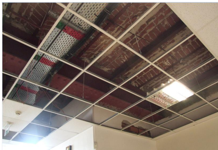
Fig. 103 : Exemple d'une poutre de reprise métallique pour la reprise des murs porteurs en maçonnerie. (Crédit photo : Souami M.A.)
