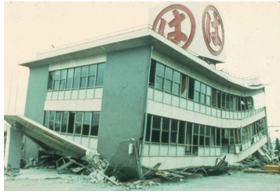
Fig. 41 : Changement de rigidité entre les étages et création d'un niveau souple.
