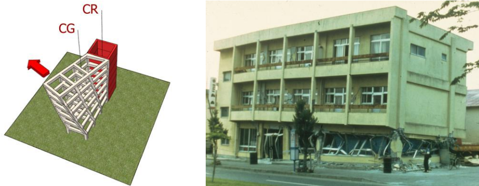
Fig. 30 : Non superposition entre le centre de gravité et le centre de rigidité. Exemple : séisme de Tokachi-Oki, Japon 1968. (Crédit photo : Djennane W., [Zacek M., 2004]).
