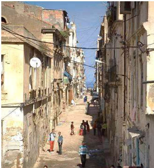
Figure 4 : Dégradation du cadre bâti - Sidi El Houari. Source : Auteure, 2018
