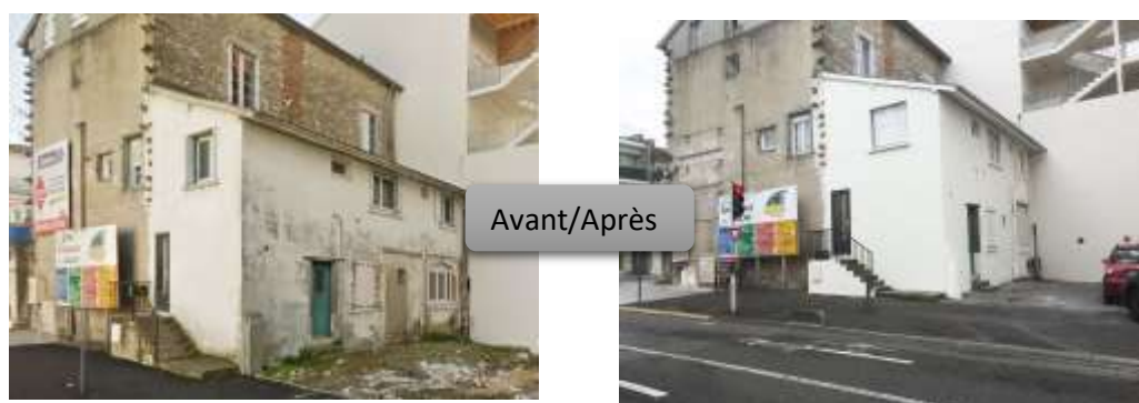
Figure 6 : Compagnes de ravalement de Façades à Dax Source : https://facades40.fr/ravalement-de-facade-a-dax/
