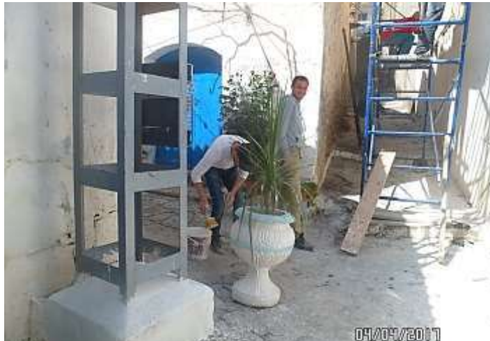
Figure 22 : Mobilisation citoyenne pour des opérations d'entretien du cadre bâti à la Casbah de Dellys. Source: Auteure, 2017.
