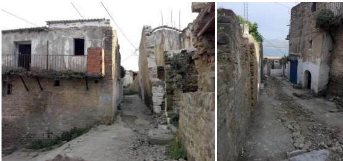
Figure 6 : Dégradation du cadre bâti de la casbah de Dellys. Source : Auteure, 2018.
