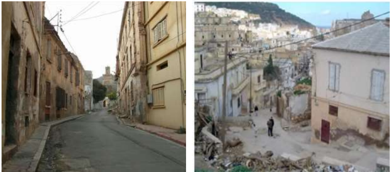
Figure 4 : Vues sur l'état de détérioration avancée à Sidi El Houari. Source : Auteur, 2018.
