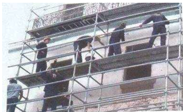
Figure 18 : Ravalement de façade par les stagiaires de SDH. Source : Association Santé Sidi El Houari.
