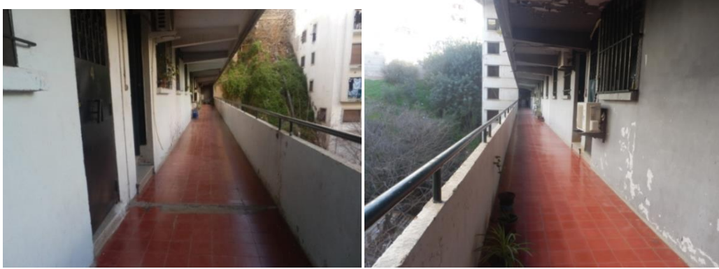
Fig. 268 Vue sur la coursive.
