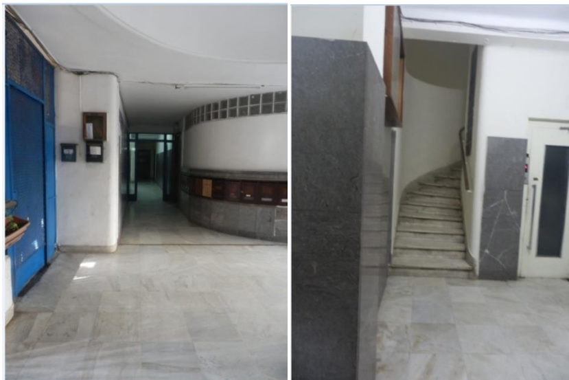
Fig. 202 Vue sur le couloir.
