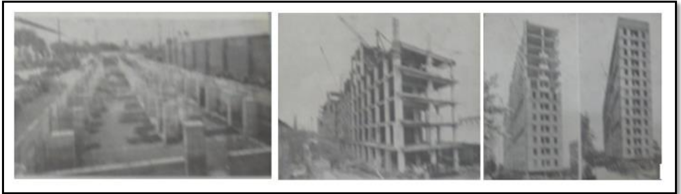
Fig. 238 Le bâtiment en cours de construction
