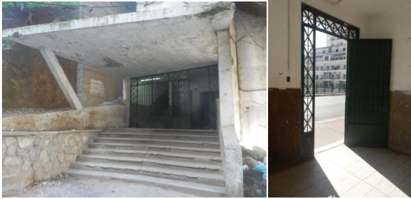
Fig. 258 Accès depuis la rue Khalfi
