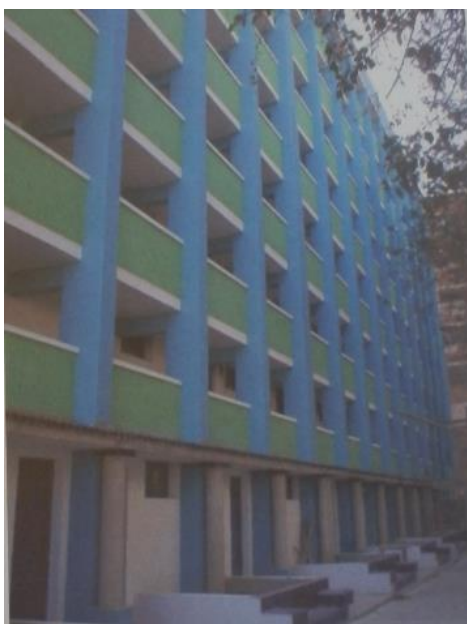
Fig.292 Réhabilitation de la cité des Carrières Jaubert.
