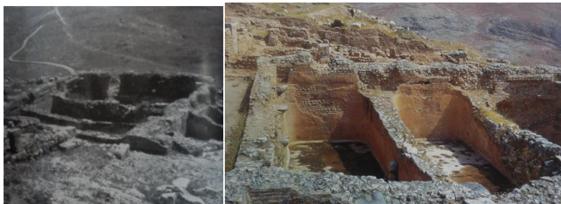
Fig.24Le château d'eau
