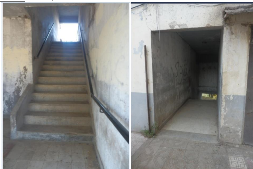
Fig.360 Vue sur l'escalier
