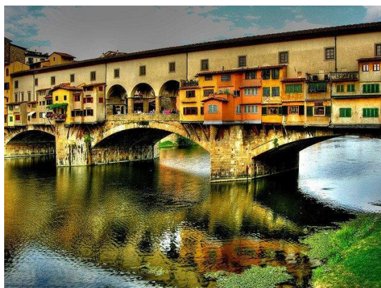
Fig. 79. Le Pont Vecchio.
