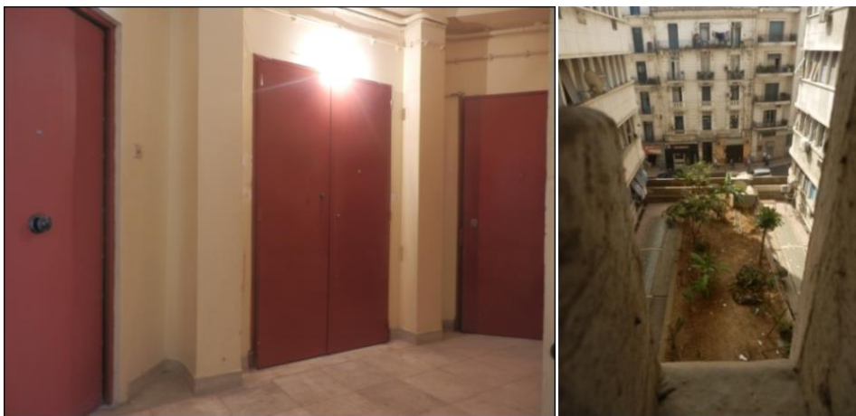
Fig. 194 Portes d'accès aux logements.
