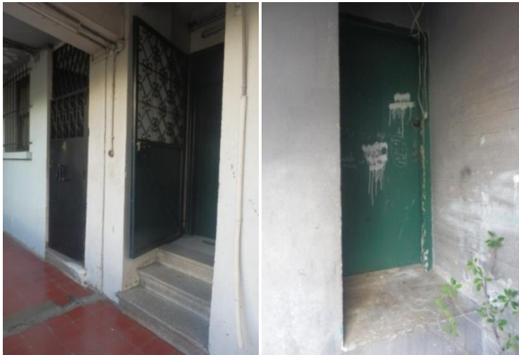
Fig. 270 Portes d'accès aux logements
