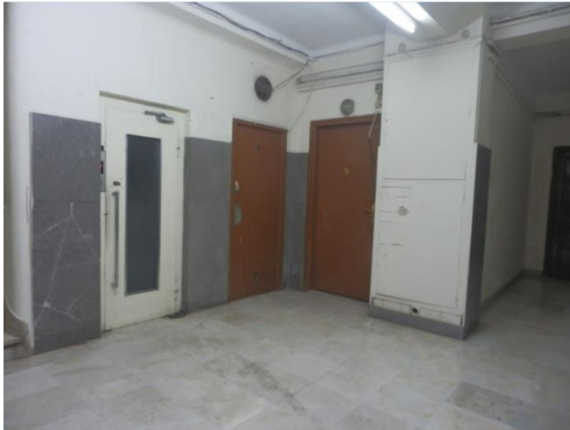
Fig. 206 Portes d'accès aux logements.
