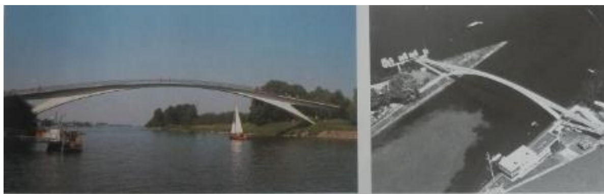
Fig. 73. Arches à rampes en porte à faux franchissant le port de Schierstein en Allemagne.
