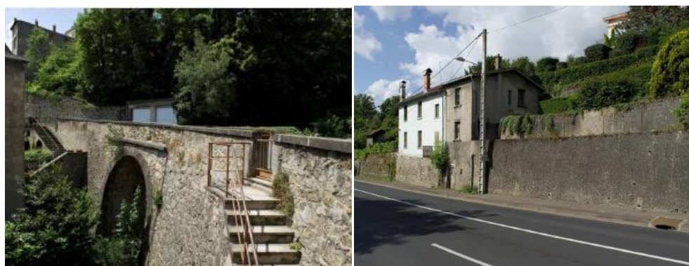
Fig. 50. Murs de soutènement
