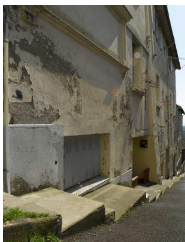
Fig. 56 Aménagement du trottoir.
