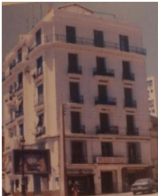
Fig. 161 Vue extérieure de l'immeuble
