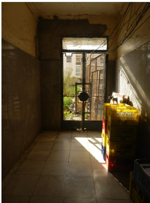
Fig. 217 Sortie vers la terrasse.
