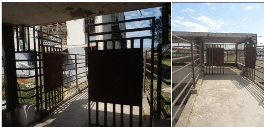
Fig.354Sortie vers la passerelle
