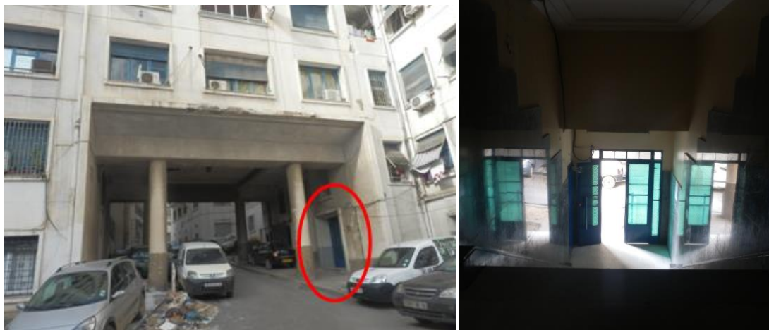
Fig. 215 Accès du bâtiment H.
