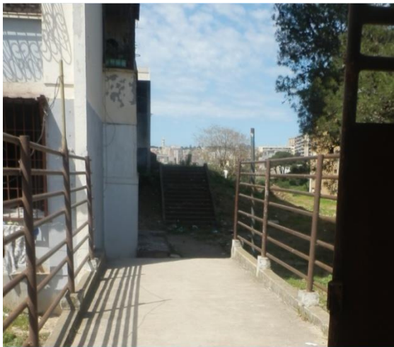
Fig.359 Vue sur l'escalier
