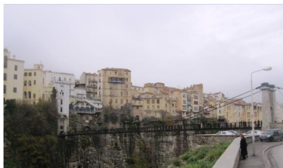
Fig. 66 La passerelle Mellah Slimane (ex Perrégaux).
