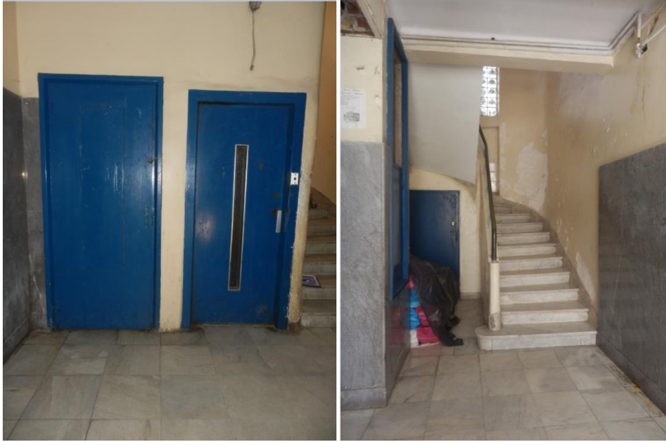
Fig. 218 Vue sur la cage d'escalier et l'ascenseur
