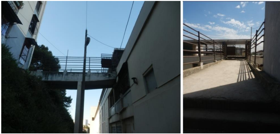
Fig.357 La passerelle vue d'en bas
