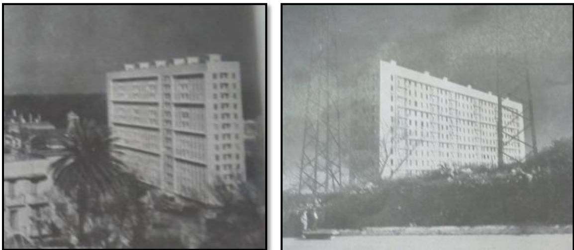
Fig. 239 Façade Nord Ouest
