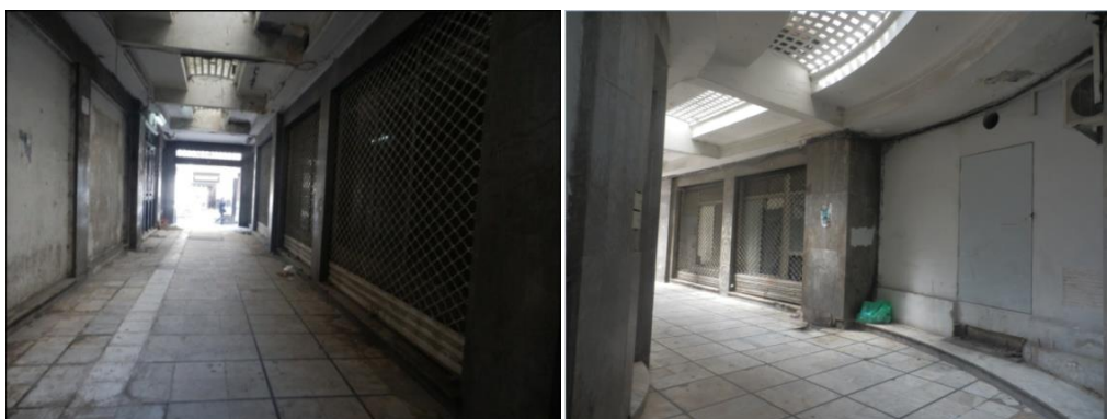
Fig. 186 Vue sur la Galerie marchande
