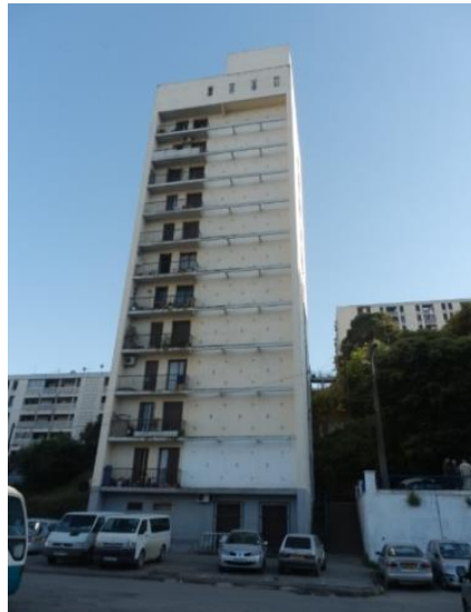
Fig.346 Vue sur l'ascenseur public adossé au bâtiment.
