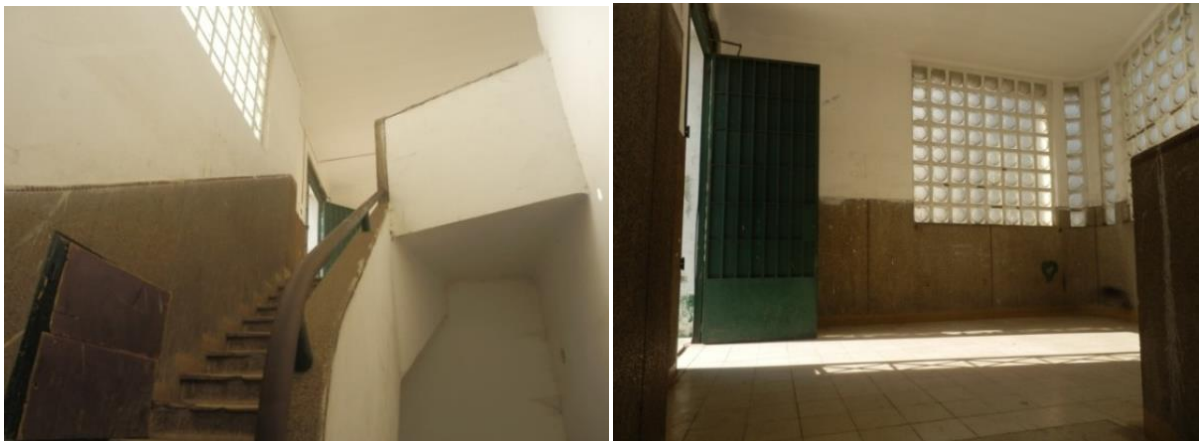
Fig. 254 Escalier menant à la terrasse du bâtiment.
