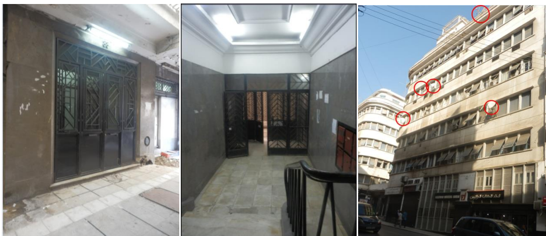
Fig. 190 Porte d'entrée du bâtiment B fermée
