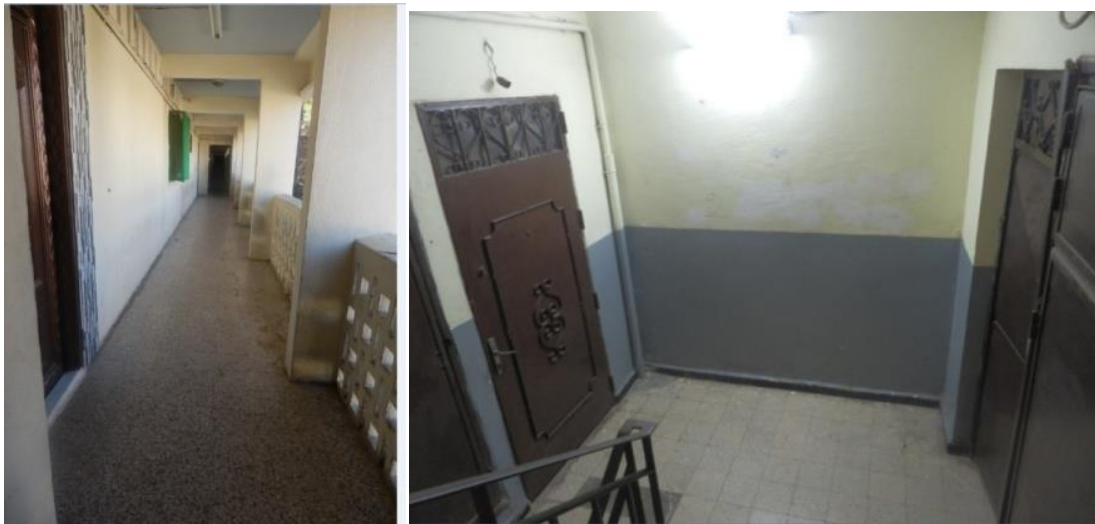
Fig.343 Vue sur la coursive du 10 e niveau.
