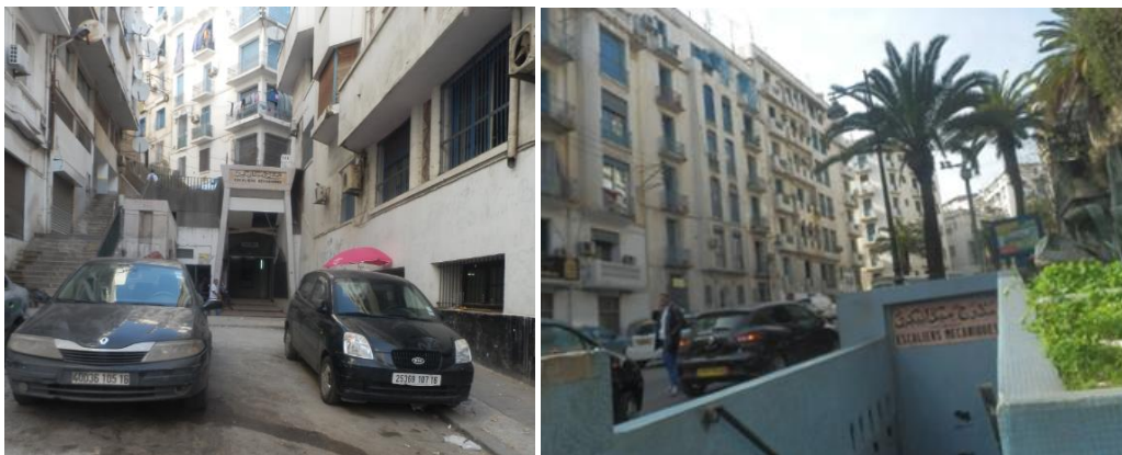
Fig. 155 Accès depuis la rue Didouche Mourad.
