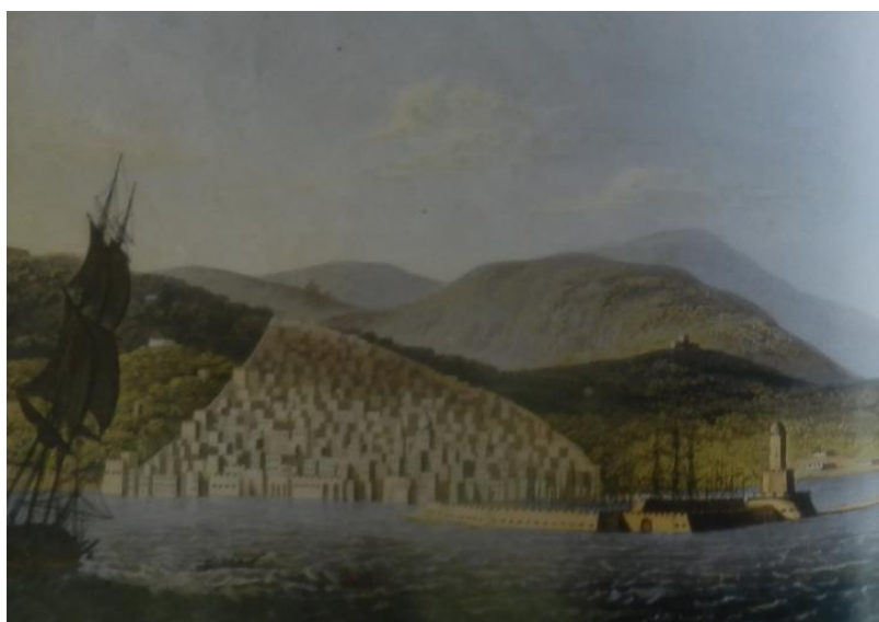
Fig. 30 la casbah vue de la mer
