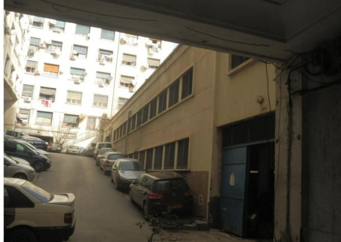
Fig. 211 Vue sur le garage Source : Auteur, 2014.
