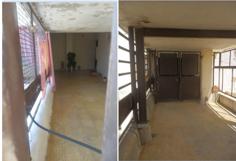
Fig.349 Vue sur le hall.
