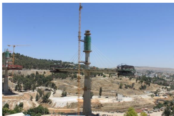
Fig. 69 Le viaduc Trans-Rhummel en chantier.
