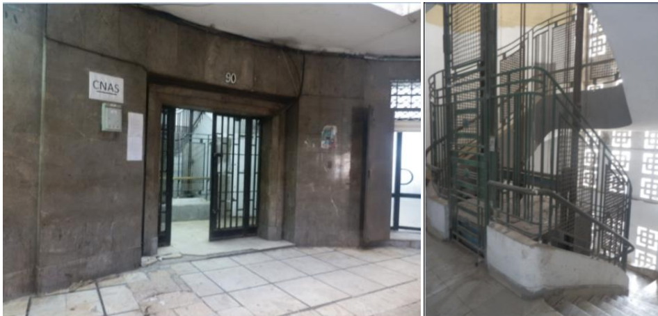
Fig. 196 Entrée du bâtiment C
