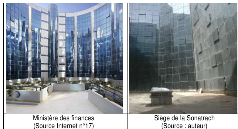
Figure 39 : Le mur-rideau de verre de forte tonalité utilisé dans les patios
