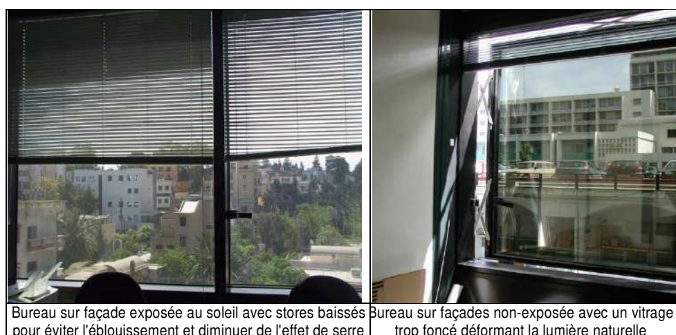
Figure 40 : Vues intérieures du vitrage de façades orientées est et nord, au siège social de la Sonatrach (Chabane, 2006, p. 78;79)
