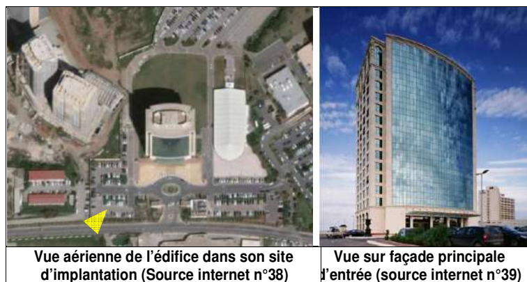
Figure 61 : Vues sur la tour ABC
