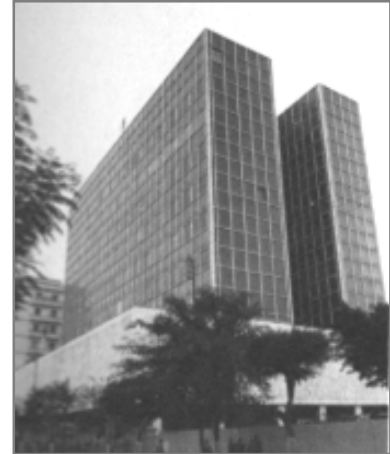
Figure 21 : Immeuble polonais, 1975 (Deluz, 1988, p. 133)
