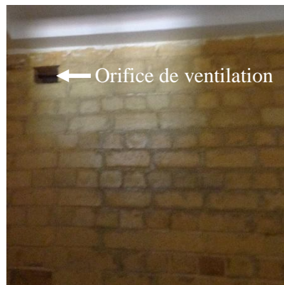
Photographie 8 : Photo de la paroi aveugle orientée ouest de la chambre 2 au niveau de la jonction mur, plancher haut. Source : Auteur.
