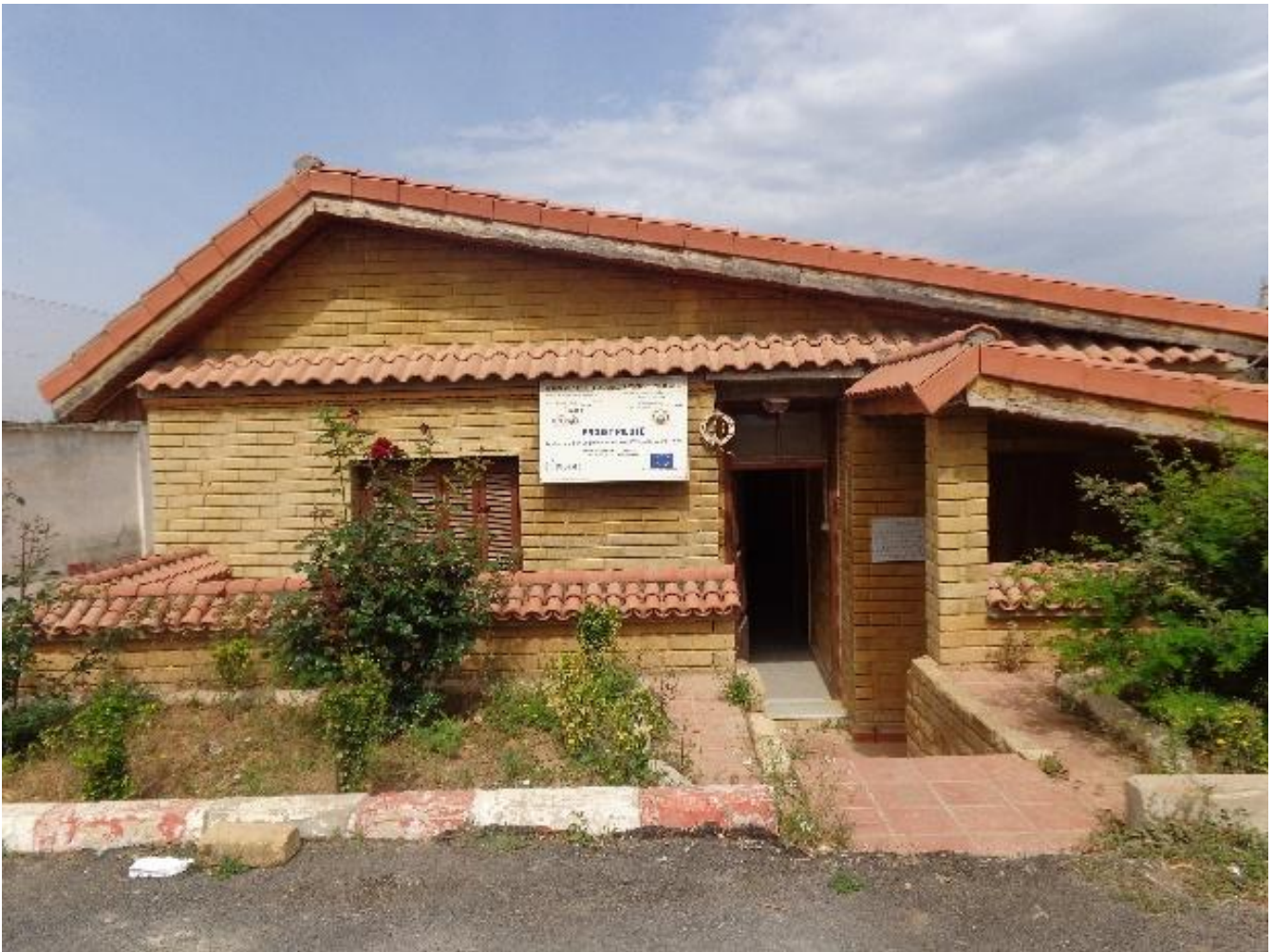
Photo et thermogramme de la façade est :
