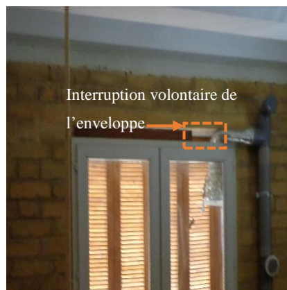
Photographie 4 : photo de la porte fenêtre du séjour. Source : Auteur
