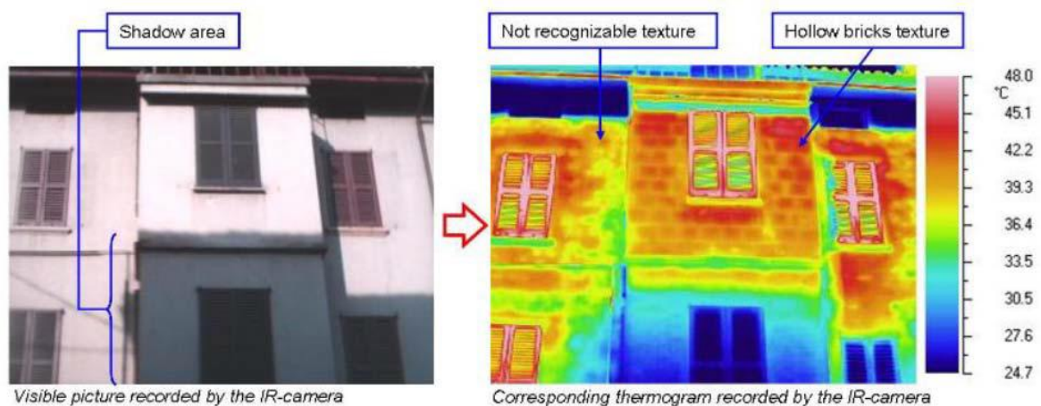
Figure 11 : Détection du matériau de construction de la partie saillante du bâtiment, (les parties en retrait sont trop éloignées ou la couche de plâtre est trop épaisse pour déceler son matériau) grâce à l'imagerie thermique. (Source : (Pleșu, Teodoriu et Țăranu 2012)
