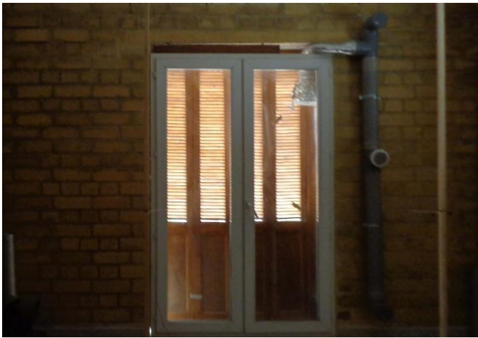
Figure 37 : Photo de la façade orientée est du séjour. Source : Auteur.
