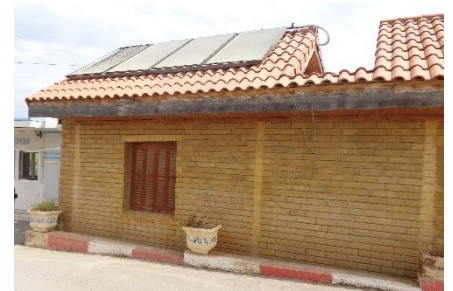
Photographie 2 : Façade sud du côté de la chambre 1. Source : Auteur.
