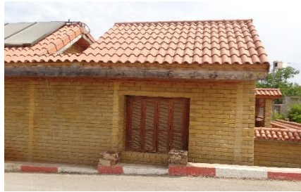
Photographie 3 : Façade sud du côté du séjour. Source : Auteur.
