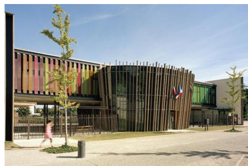
Figures N°2 & N°3 : dispositif de protection contre le soleil de l'école Daniel Pennac de La Colle sur Loup, Alpes maritimes. (Source : http://www.cyberarchi.com/article/une-ecole-hqe-integree-dans-la-demarche-de-developpement-durable-07-10-2013-14888 ; 2013 )
