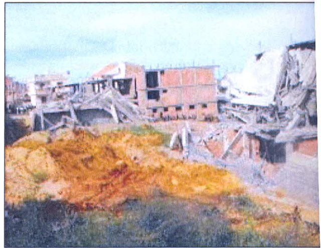
Figure n° 14 Tipasa : Démolition de 35 villas construites illicitement Avril 2013 1
