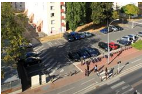
Figure 17: Construction La rénovation de la rue Casalis
