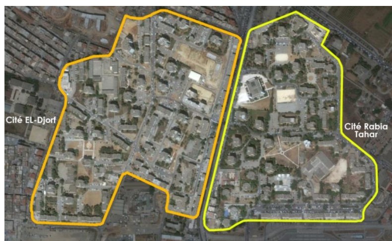
Figure 27: Vue aérienne des deux ensembles, Source : Image satellite (modifiée par l'auteur)
