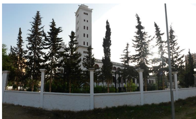
Figure 35: La Mosquée Elforkan repère à l'intérieur de la cité Rabia Tahar
