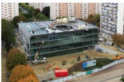
Figure 18: Construction de la nouvelle médiathèque
