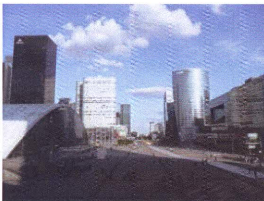
Figure 18 : image du quartier d'affaire de la défense à Paris ou chaque tour se distingue par une forme spécifique.
