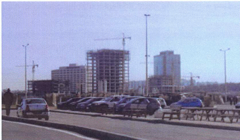
Figure 16 : image illustrant les tours de bureaux et le Flats hôtel en construction, en arrière-plan : la Tour ABC et l'Hôtel HILTON. Image prise sur le site.
