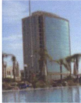
Figure 6 : La tour D'affaire ABC. Photo prise sur le site.
