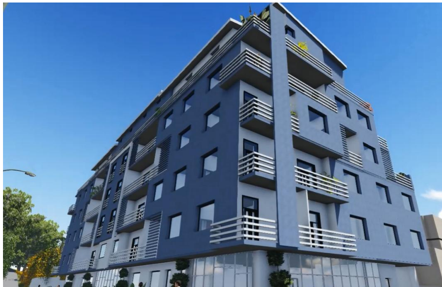
Figure 28: Une vue sur les façades EST et SUD –OUEST de la résidence. Source : la filiale Alliance Real Estates.
