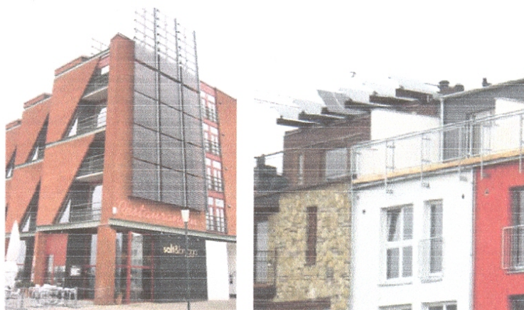
Figure 12. Panneaux solaires intégrés en façade et en toiture
