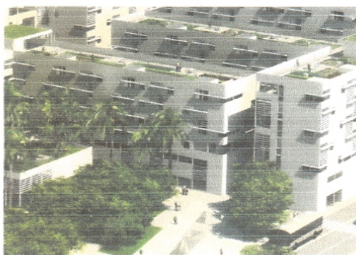
Figure 22. Toiture végétalisée et accessible
