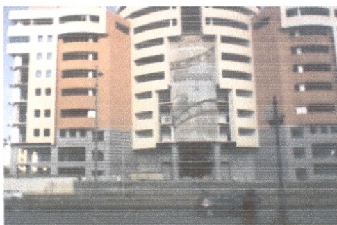
Figure 67. Futur centre commercial CidarPas encore ouvert au public
