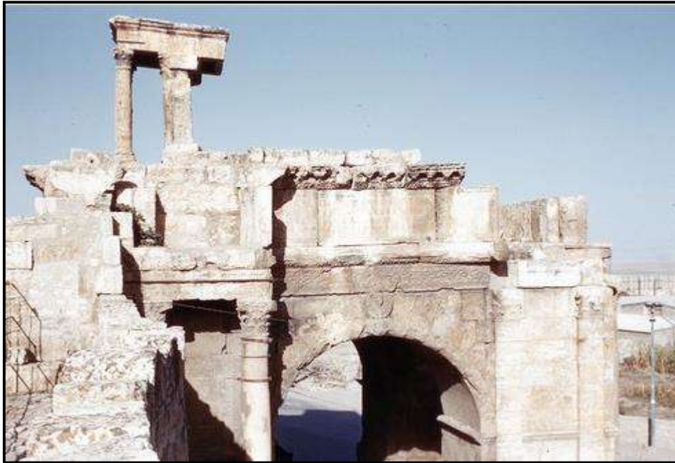
Figure 61: édicule, arc de Caracalla à Tébessa.
