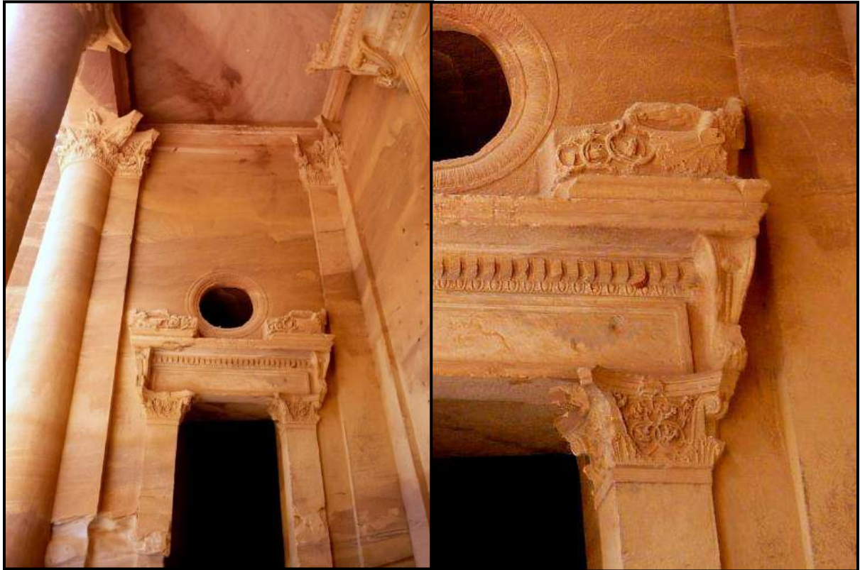
Figure 60: Consoles supportant une corniche, porte latérale du Khazneh à Petra, Jordanie. Source: http://www.sabyplanete.com/article-32869152.html
