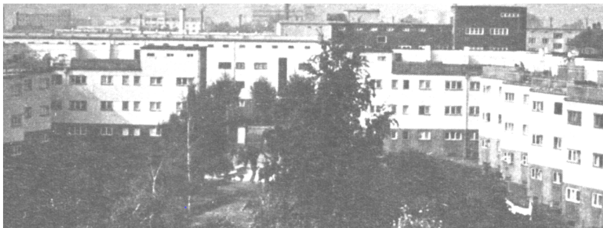
Figure I- 9: Vue sur les bâtiments du quartier d'Ernst May
