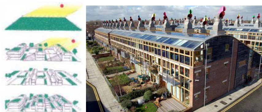
Figure II- 29: A gauche : Axe héliothermique 47 comme élément fédérateur de l'organisation du quartier de BedZED. A droite : utilisation de panneaux photovoltaïques pour la production d'énergie sur les toits des bâtiments du quartier BedZED
