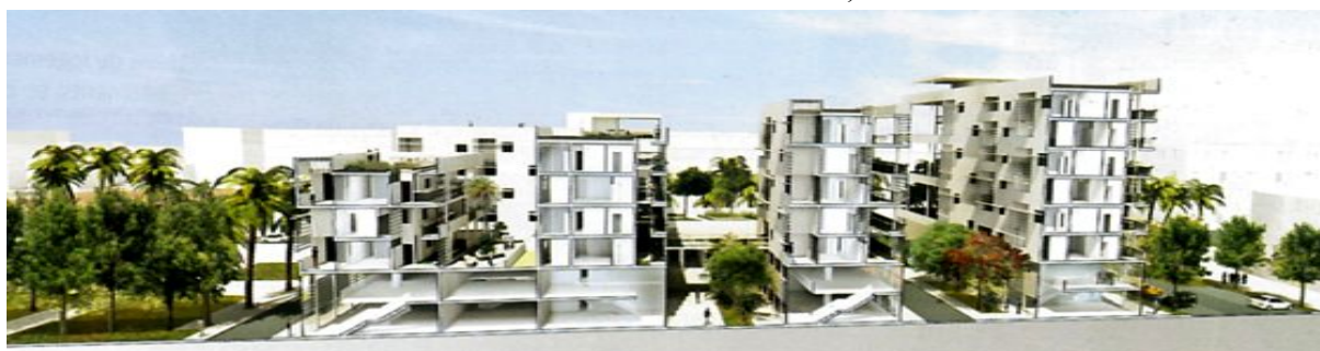
Figure III-17: Vue sur les bâtiments et leurs sols de référence Source : La Revue Vies de Villes, 2012
