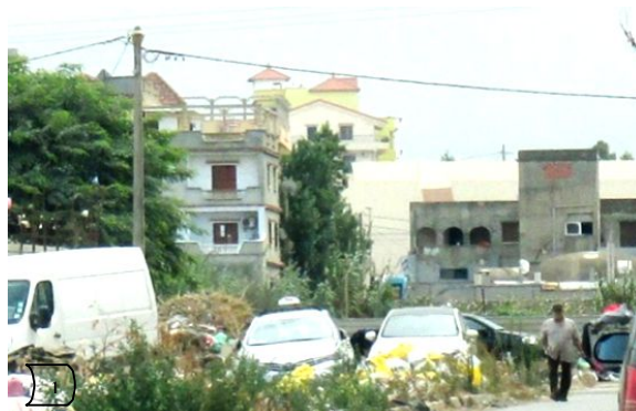
Figure III-8: Vue sur les maisons individuelles entourant le site du projet du côté Sud. Source : Auteur de ce mémoire (photo prise en avril 2015)
