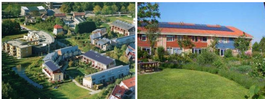
Figure II-5: Vue sur l'éco-quartier Lanxmeer
