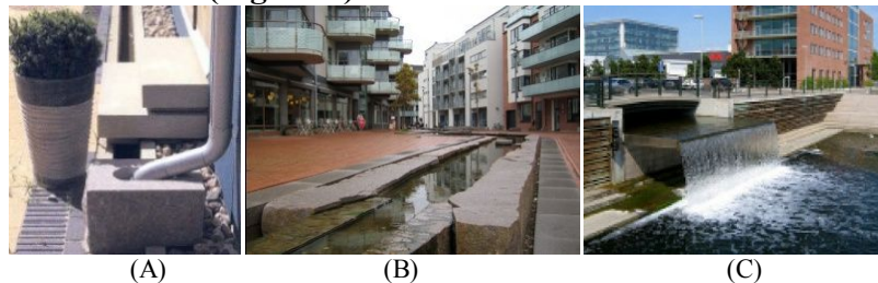
Figure 5 : Collecte des eaux de pluie provenant des toitures (A). Aménagement des rigoles (B) et un bassin (C) recueillant les eaux pluviales. Source: www.lausanne.ch (Consulté le 10/06/15)
