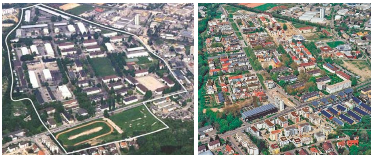
Figure II-4: A gauche : vue sur les douze casernes avant l'opération de réhabilitation 1992, à droite : le site après la construction de l'éco-quartier Vauban 2006.
