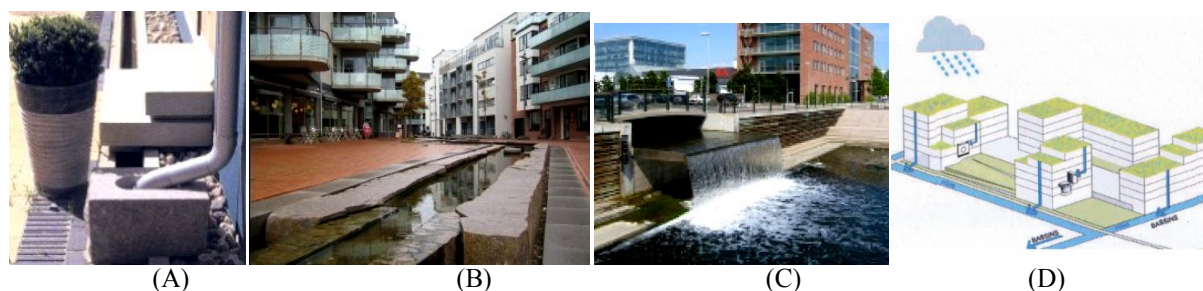
Figure II- 30 : Exemples de la récupération des eaux pluviales dans l'éco-quartier Bo01 : Collecte des eaux de pluie provenant des toitures (A). Aménagement de rigoles (B) menant ces dernières au bassin de rétention (C). (D) schéma illustratif de la technique
