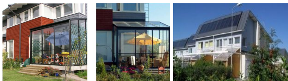
Figure II- 28: A gauche : des serres aménagées dans les logements de l'éco-quartier Eco-Viikki. À droite : des panneaux photovoltaïques installés sur ses toitures.
